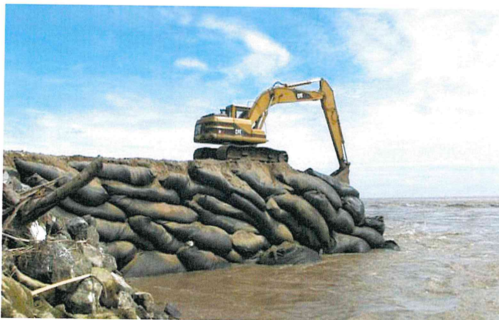
Imagen N° 3 Protección con geobolsas
