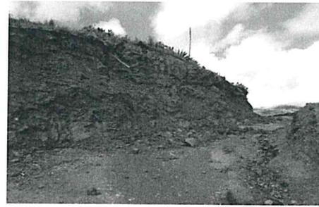
Vista Actual de como se esta desmoronando y cediendo la plataforma de las lagunas de oxidacion, que hacen que este a punto de colpsar las estructuras, siendo arrasados por la erosion y socavamiento producido por las constantes y persistentes lluvias que estan a punto de hacer colapsar las estructuras de las lagunas de oxidacion practicamente ya estan a punto de ser arrasados por los huaycos - requieren pronta intervencion y asegurado con muros de contencion (margen derecha laguba rio qanqoyaku
