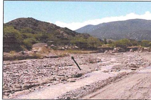
Vista hacia la margen derecha del cauce, donde se muestra que el cauce del río Chillico está erosionado. Asimismo, se observa que existe enrocado que no funcionó y que actualmente se encuentra en riesgo, asimismo se evidencia que existe vegetación conformado por arbustos, que detrás de éstas se tiene áreas agrícolas.
