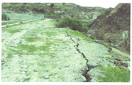
Vista Actual de como se están partiendo los terrenos y se están desmoronando producto de la erosión y socavamiento producido por las constantes y persistentes lluvias que están a punto de hacer colapsar las estructuras de las lagunas de oxidación que prácticamente ya están a punto de ser arrasadas por los huaycos - requieren pronta intervención y asegurado con muros de contención (margen derecha laguna rio qanqoyaku)
