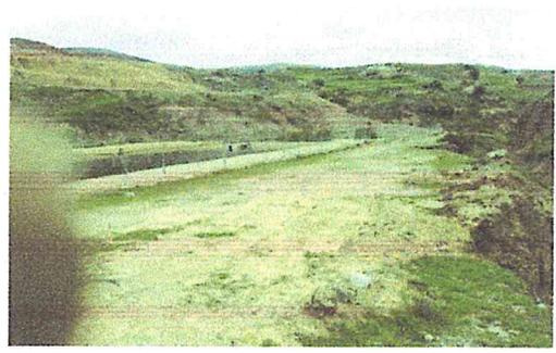
Vista actual del desmoronamiento de terrenos por erosión y socavamiento producto de las constantes y persistentes lluvias que están a punto de hacer colapsar las estructuras de las lagunas de oxidación - requieren pronta intervención y asegurado con muros de contención (margen derecha laguna rio qanqoyaku)
