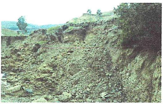
Vista actual del desmoronamiento de terrenos por erosión y socavamiento producto de las constantes y persistentes lluvias que están a punto de hacer colapsar las estructuras de las lagunas de oxidación que prácticamente ya están al borde del huayco - requieren pronta intervención y asegurado con muros de contención (margen derecha laguna rio qanqoyaku)
