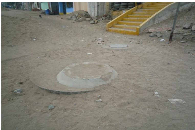
Foto 14.- Se muestra las alcantarillas de agua y desagüe.
