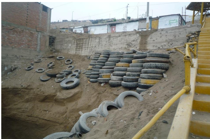
Foto 18. A.H. Héroes del Cénepa, se muestra una pared formada por llantas sobrepuestas, con la finalidad de estabilizar
