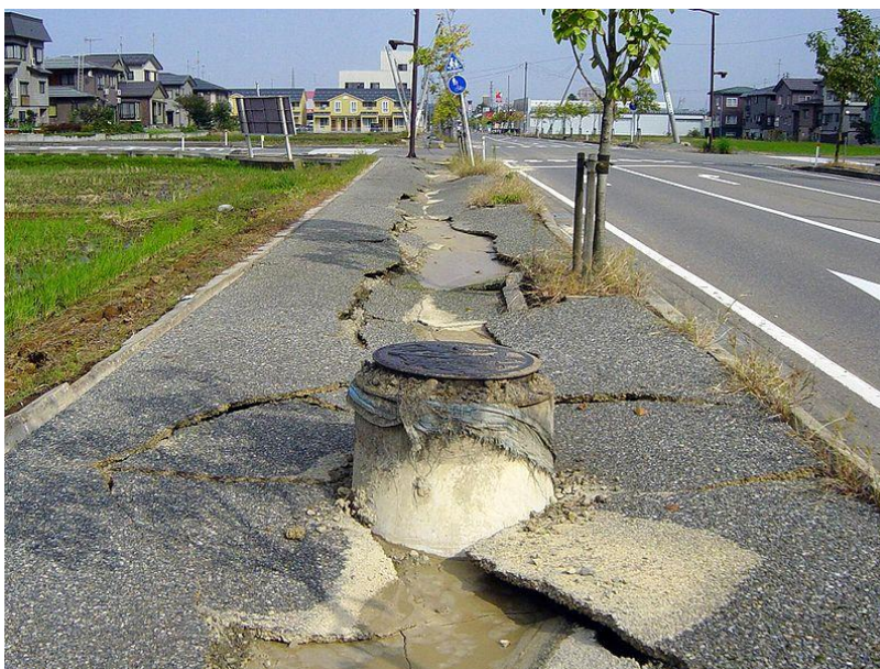
Foto 16. La licuefacción permitió que esta boca de alcantarilla flotara y se elevara por sobre la superficie (Imagen tomada de: http://es.wikipedia.org )
