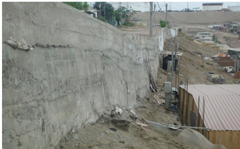
Foto 5. Muro de protección, A.H. Héroes del Cénepa.
