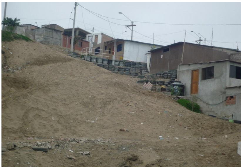
Foto 2. Viviendas precarias en el sector evaluado.
