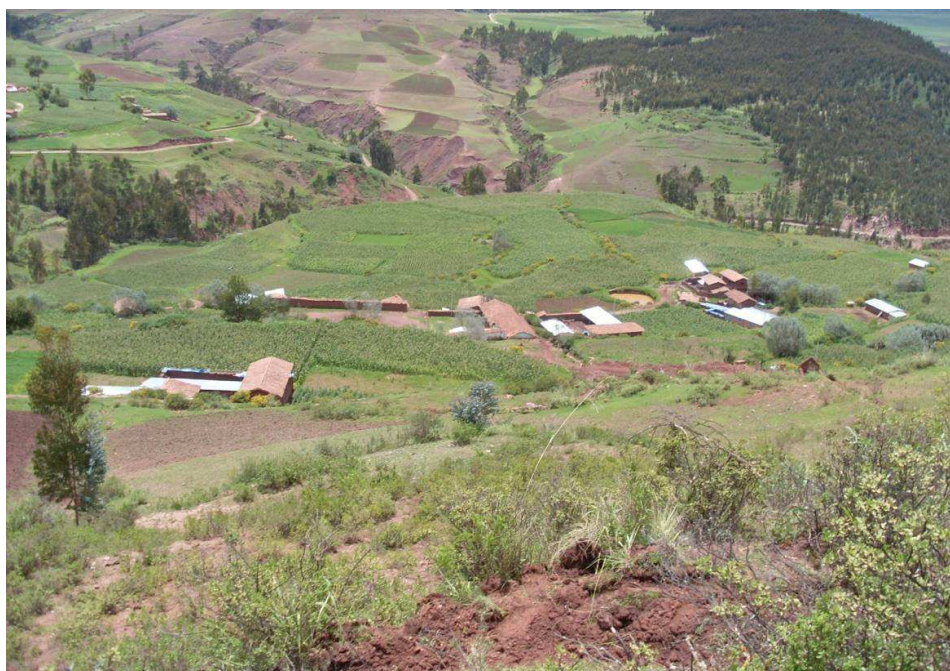
Figura N° 24 Viviendas en la parte baja del deslizamiento
