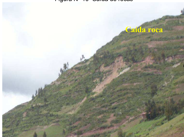
Figura N° 19 Caída de rocas
