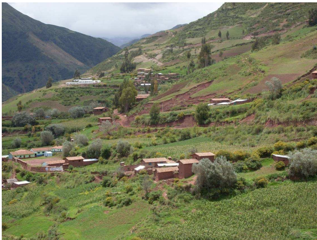
Figura N° 16 Deslizamiento de Ccanacchimpa
