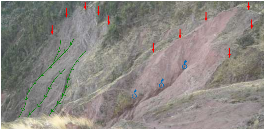
Foto 09: Deslizamientos en la margen derecha de la quebrada Thuniyoq, con procesos de socavamiento y surgencias de agua.
