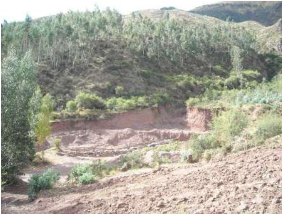
Foto 14: Vista del disipador 1, ubicado en la desembocadura de la quebrada Thuniyoq.
