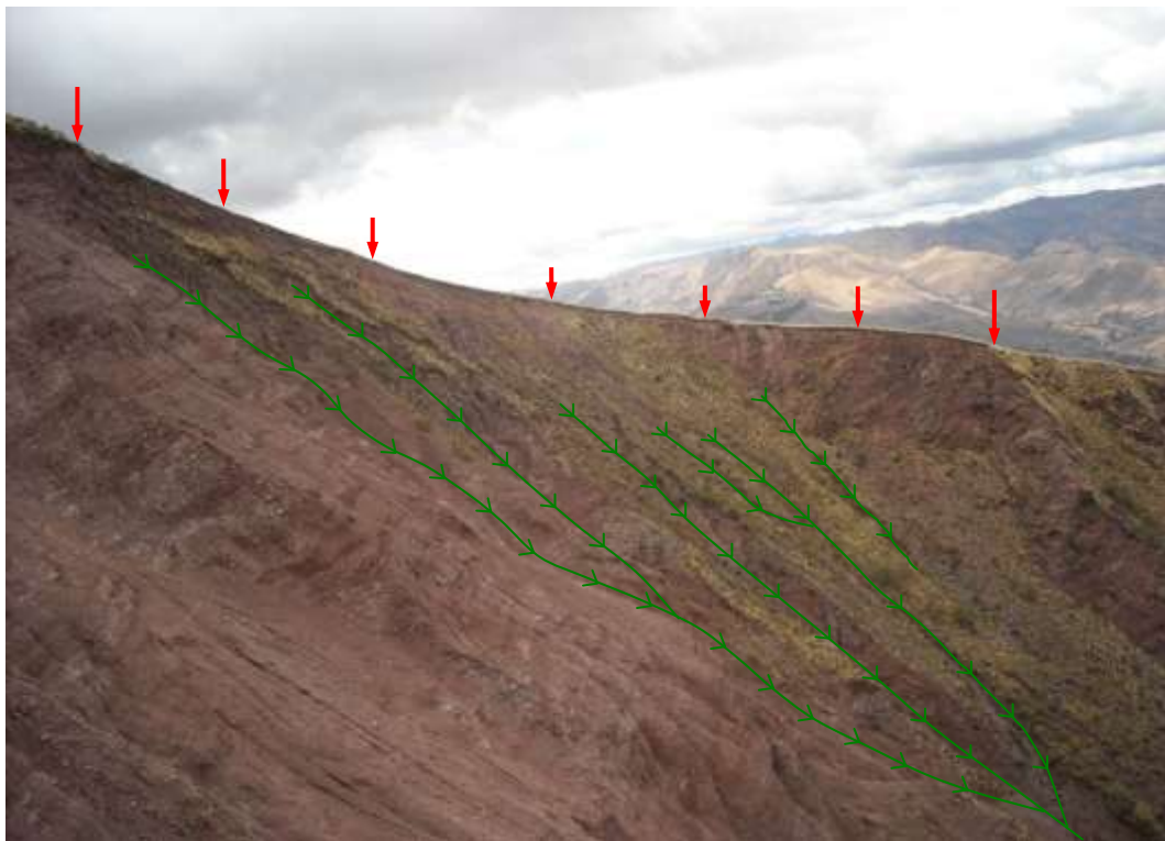
Figura 08: Erosión en surcos debido a la escorrentía superficial
