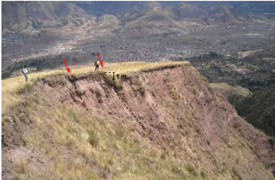
Foto 07: Flanco izquierdo con grietas y desniveles en el terreno.
