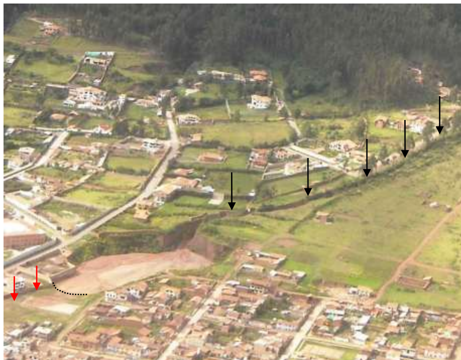
Foto 16: Vista aérea del dissipador 2, las flechas negras demarcan el canal que proviene del dissipador 1, la línea punteada demarca el límite del dissipador colmatado y las flechas rojas marcan la zona de desborde (Marzo 2011).
