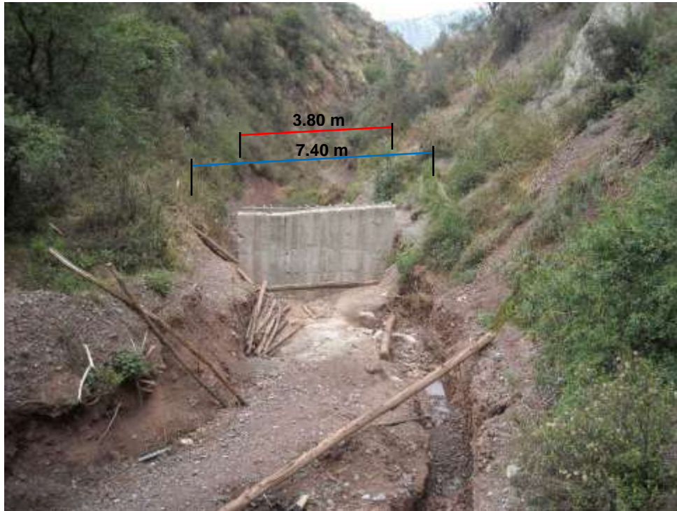
Foto 12: Se observa en línea roja la longitud del muro de contención y en color azul la longitud de la base de la quebrada, vista tomada hacia aguas abajo.
