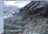
7. Cerros de la zona media, que son muy altos y están muy cercanos a la ciudad de Huaraz. Los cerros de la zona media son muy peligrosos y pueden generar grandes deslizamientos y derrumbes.
