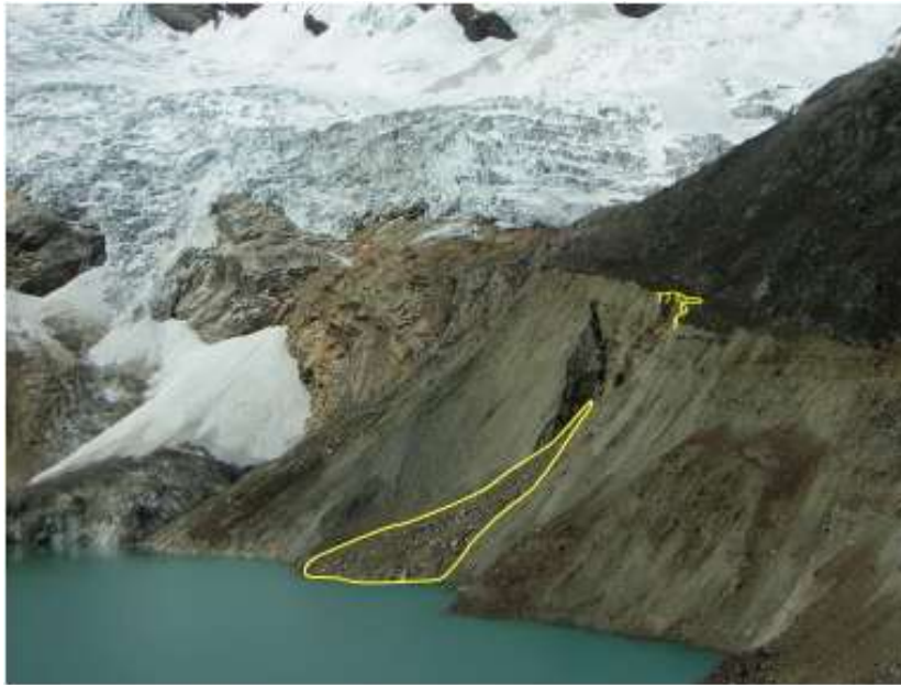
Foto 5.5: Deslizamiento - avalancha de rocas y detritos producto de las infiltraciones por precipitaciones pluviales en el mes de Marzo del 2003.
