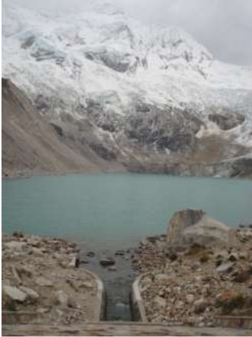
Foto 7.6: Sistema de canalización realizada en la Laguna Palcacocha, a la derecha se muestra la presa artificial realizada por la Unidad de Glaciología y Seguridad de Lagunas de Electro Perú S.A. para reforzar el sistema de canalización. (Fotos: Santillán, 2008).
