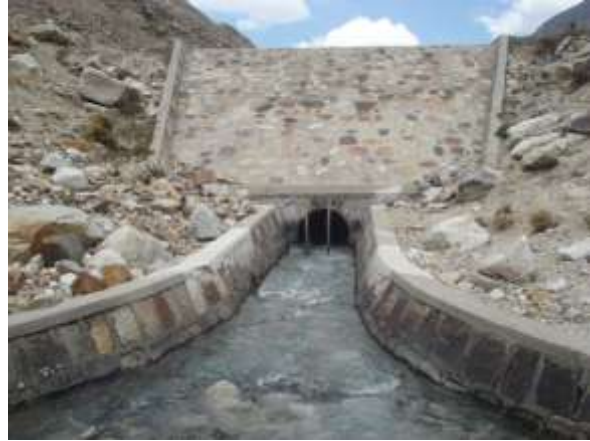
Foto 7.6: Sistema de canalización realizada en la Laguna Palcacocha, a la derecha se muestra la presa artificial realizada por la Unidad de Glaciología y Seguridad de Lagunas de Electro Perú S.A. para reforzar el sistema de canalización. (Fotos: Santillán, 2008).
