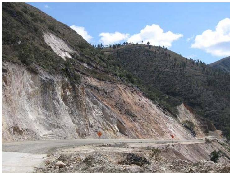
Foto: Deslizamiento en el Km 25+670 de la carretera Huamachuco -Trujillo, provincia Sanchez Carrión.
