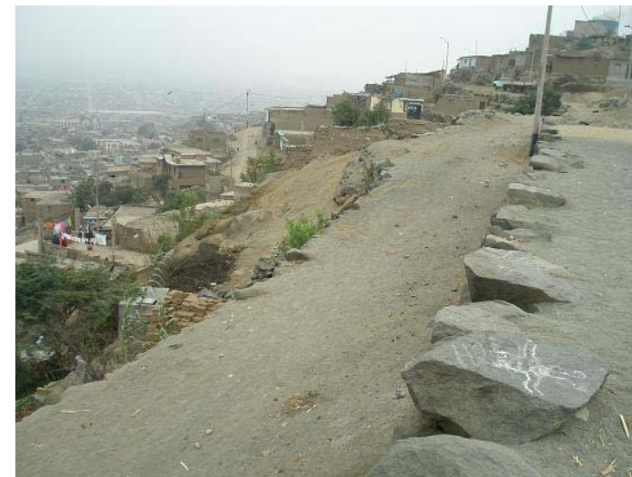
Foto: Área susceptible a derrumbe en caso de sismo. Sector 2, El Mirador del Provenir, distrito El Porvenir, provincia Trujillo.
