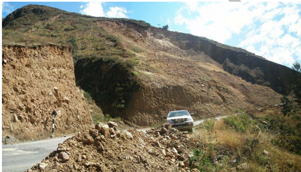
Foto: Deslizamiento rotacional en el Km 34+100 de la carretera Trujillo-Huamachuco, distrito y provincia de Otuzco.
