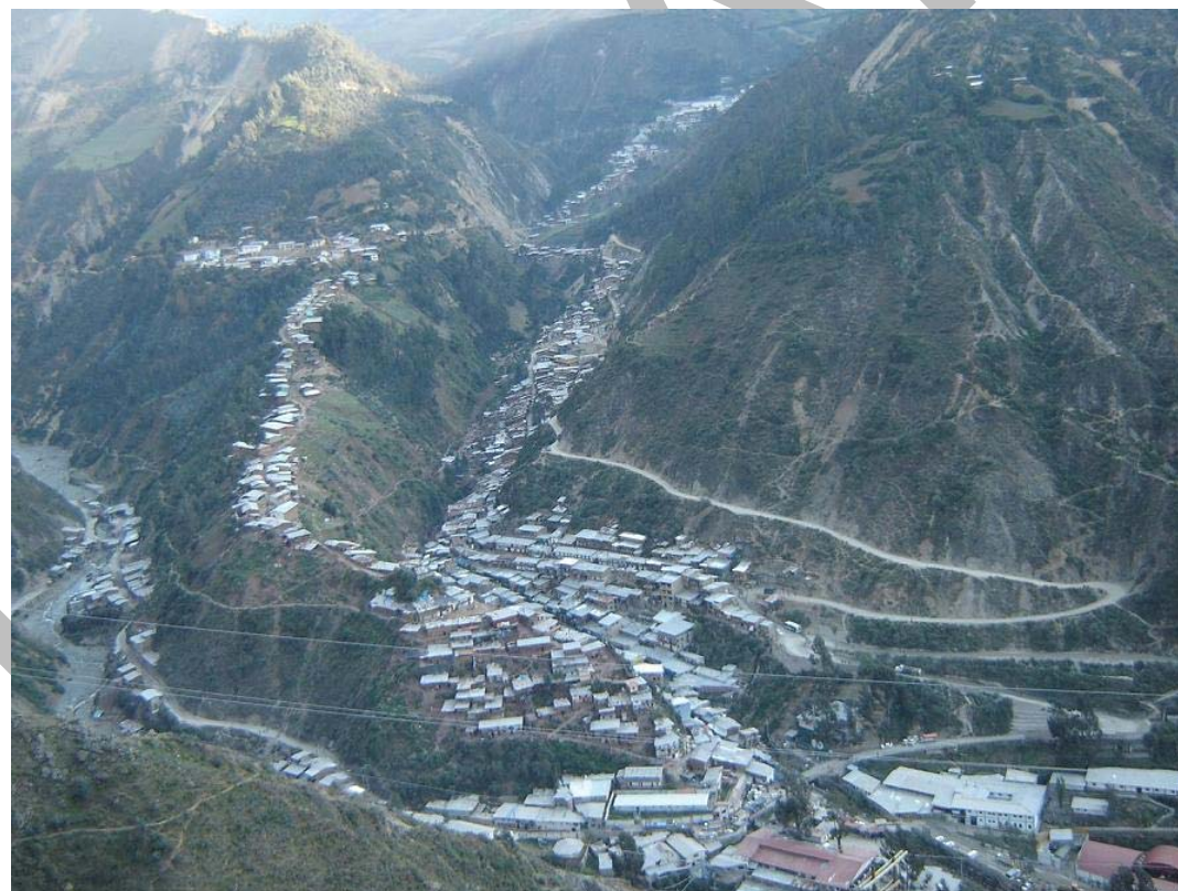
Foto: Vista panorámica de los sectores de Parcoy y Retamas. Área susceptible a la ocurrencia de flujos. Las viviendas se encuentran construidas dentro del cauce de la quebrada Patacocha.
