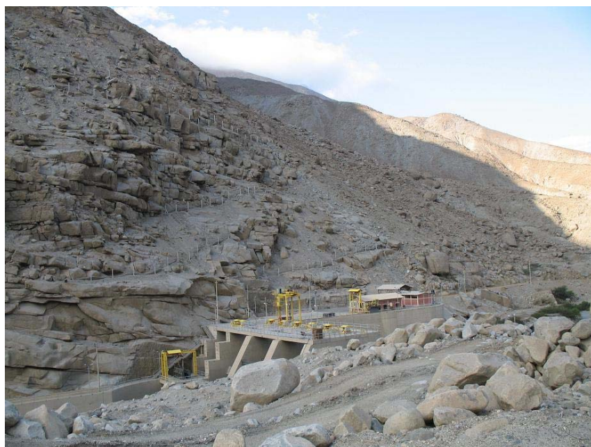
Foto: Vista de la Bocatoma Chavimochic. En los taludes del cerro se observa bloques de roca.
