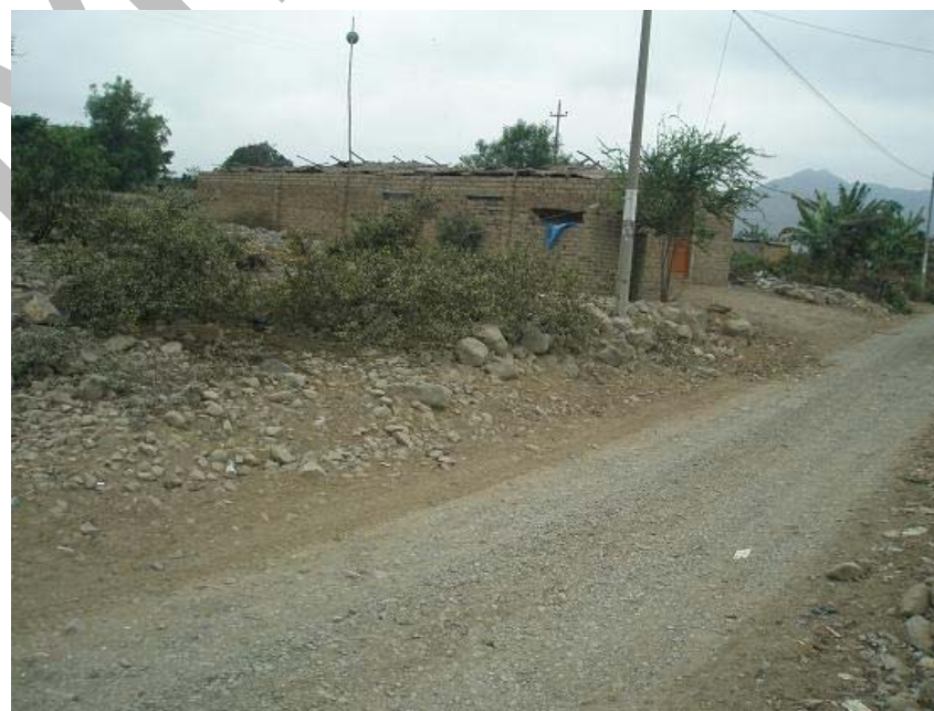
Foto: Depósitos de flujo de detritos en el sector El Niño, distrito Chao, provincia Virú. Las viviendas se encuentran asentadas en los depósitos de flujo.
