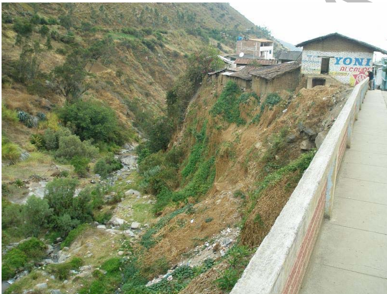
Foto: Erosión fluvial en la margen derecha de la quebrada la Cuesta. Distrito La Cuesta, provincia de Otuzco. Podría afectar a viviendas ubicadas al borde de la quebrada. Viviendas se encuentran ubicadas sobre depósito de derrumbe antiguo.
