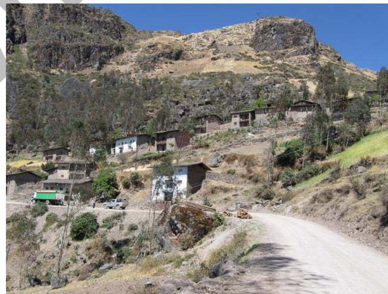
Foto 31. Derrumbe en la parte alta del caserío de Laclambay, distrito Charat, provincia Otuzco, también presenta caída rocas ocasionados por sismos.
