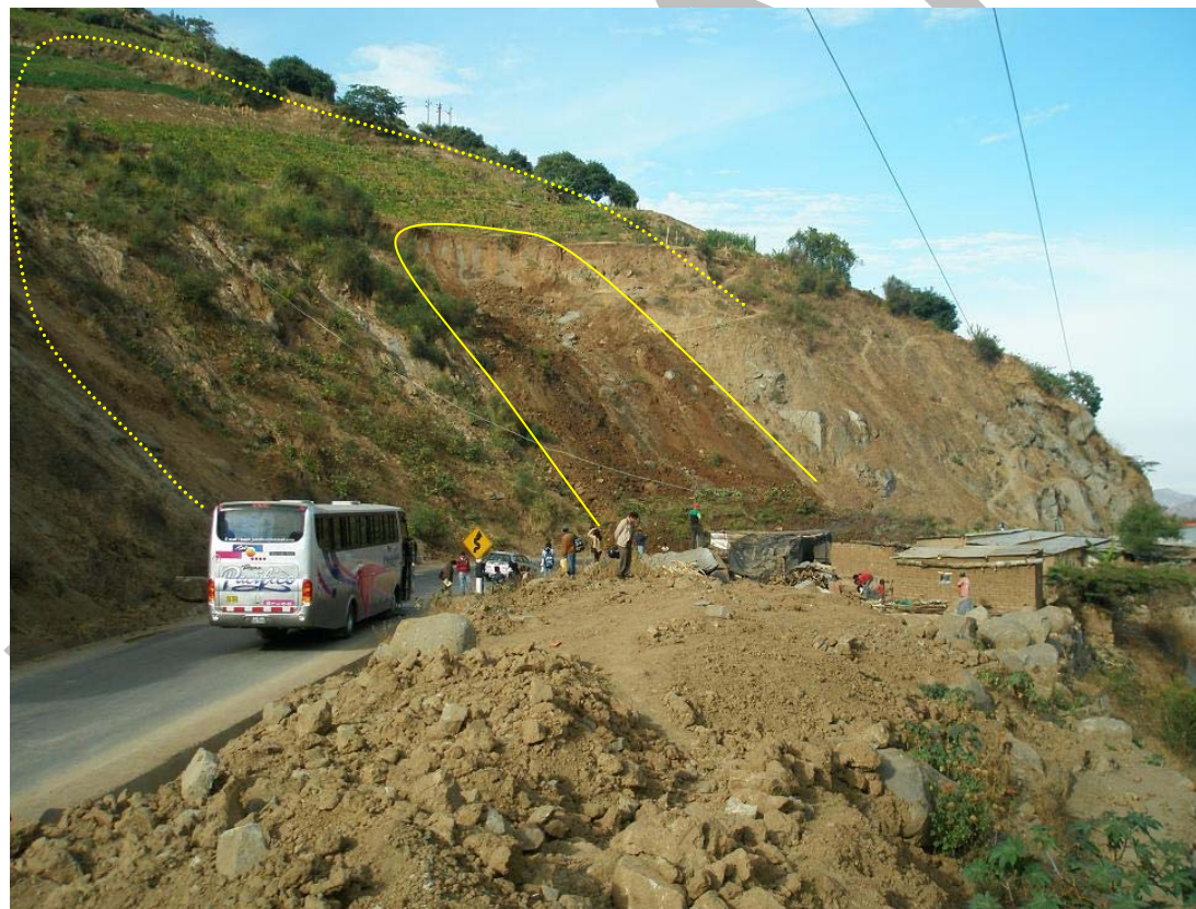
Foto: Deslizamiento en el talud superior de la carretera Trujillo - Otuzco, Sector Plazapampa, distrito de Salpo, provincia de Otuzco.
