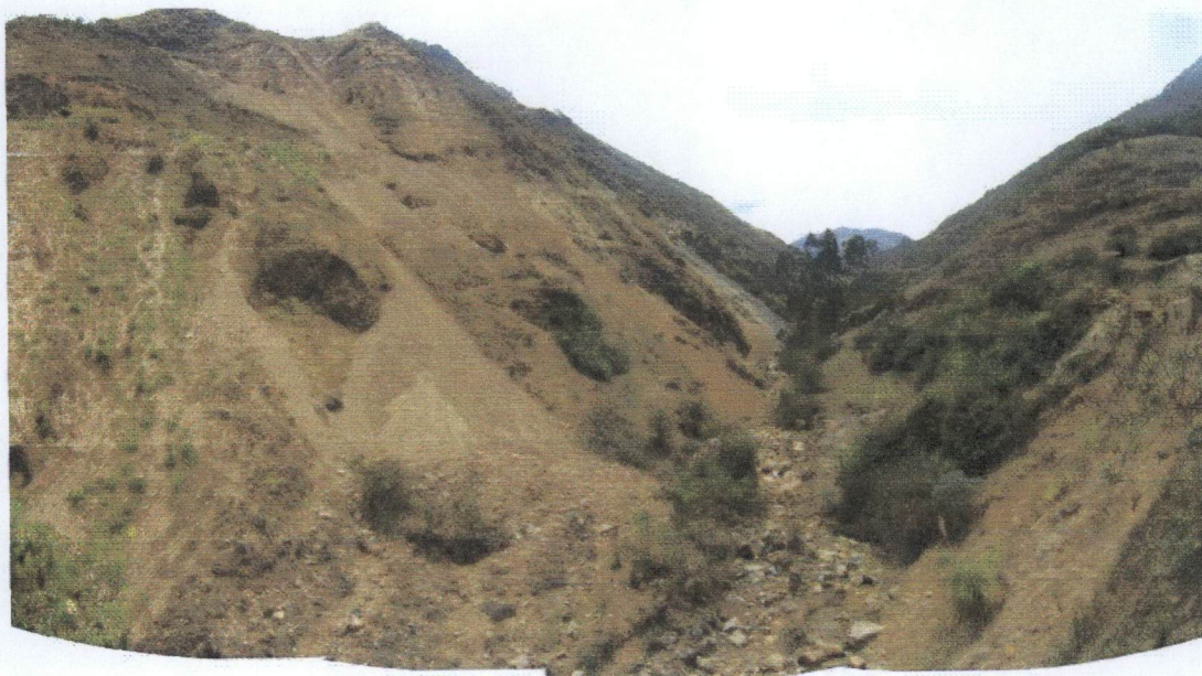
Foto N° 22 Vista aguas arriba del cauce del río Laclambay, con acumulación de detritos (Flanco oeste del cerro Mulaya) que inclusive ocupan el lecho actual del río; estos pueden generar avalanchas de detritos
