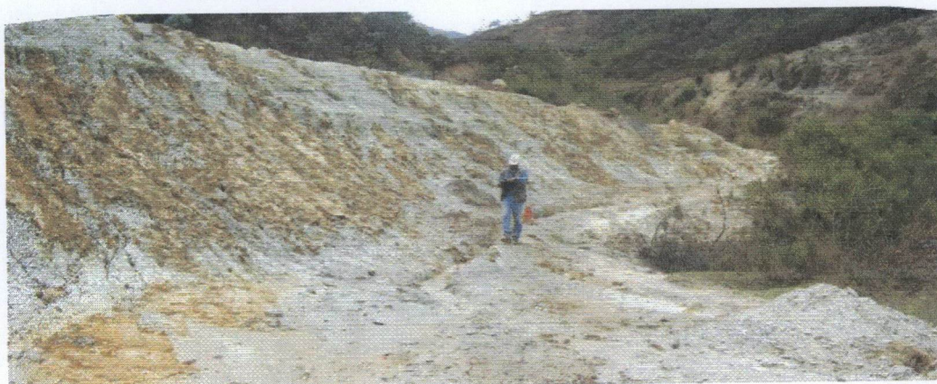
Foto N° 27 Muestra tres vistas de la relavera El Rejo susceptible a erosión fluvial excepcional, así como erosión pluvial; por contacto con el agua representa además un peligro de contaminación.
