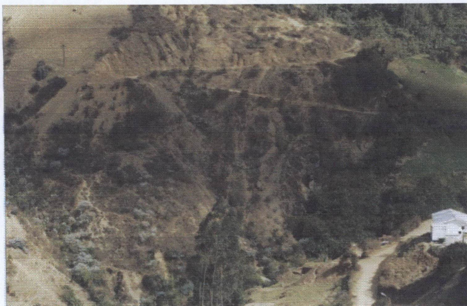
Foto N° 18 Derrumbes en cara libre hacia el cauce de la quebrada Laclambay, margen derecha (frente a Belén). En el talud inferior se observan bloques de rocas inestables
