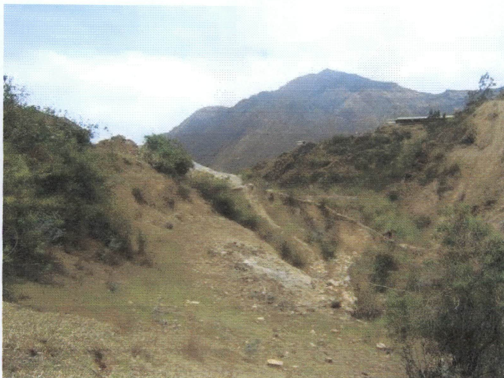
Foto N° 28 Vista aguas abajo del río Laclambay donde el río erosiona en su margen izquierda, donde se ubica adyacentemente la relavera El Churge.
