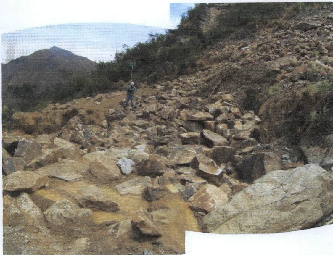
Foto N° 32 Varias vistas de la obstrucción del cauce de la quebrada Laclambay, por depósitos de escombros o escombreras, que representan una amenaza por avalanchas y flujos de detritos.
