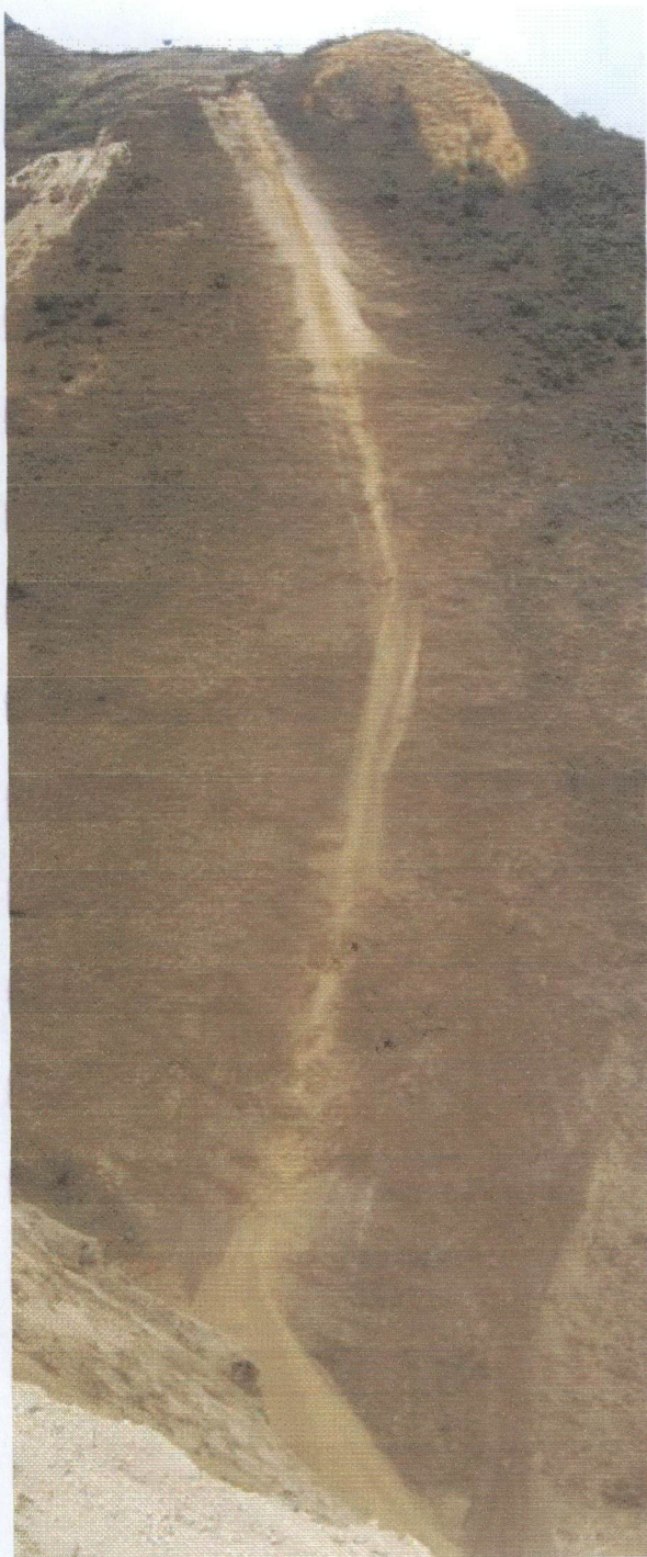
Foto N° 33 Varias vistas de desmontes arrojados por los cortes en los taludes efectuados en la carretera de acceso a Pozo Seco, ladera de cerro Blanco. Estos se pueden activar con lluvias y generar huaycos aguas abajo.
