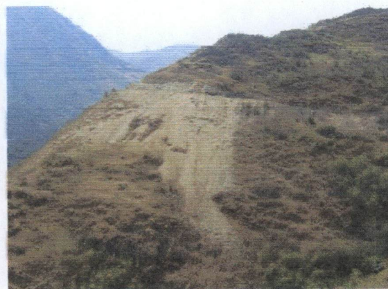
Foto N° 33 Varias vistas de desmontes arrojados por los cortes en los taludes efectuados en la carretera de acceso a Pozo Seco, ladera de cerro Blanco. Estos se pueden activar con lluvias y generar huaycos aguas abajo.
