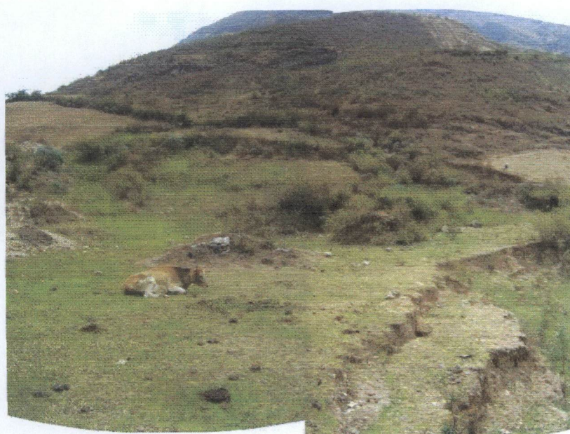
Foto N° 8 Vistas del deslizamiento traslacional en la margen izquierda del cauce de la quebrada Laclambay muy cerca de la relavera El Churgue, reactivado en un depósito antiguo.
