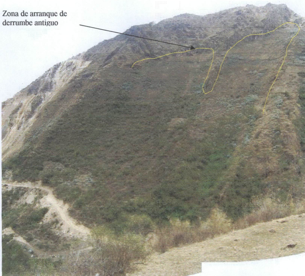
Foto N° 19 Vista de la ladera del cerro Mulaya donde se aprecia la zona de arranque de un derrumbe antiguo, así como el depósito al pie.
