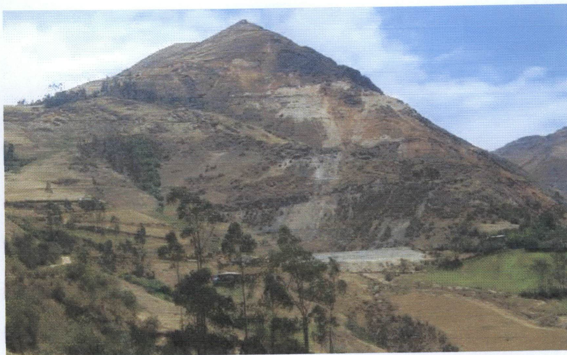
Foto N° 30 Ladera norte del cerro Mulaya, áreas inestables por la actividad minera informal, así como la construcción de nuevos accesos (carreteras), peligro de derrumbes, caída de rocas y avalancha de detritos.
