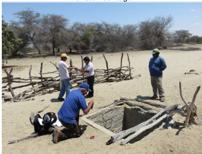
FOTOGRAFIA 07: Pozo IRHSN°– 042, pozo tajo abierto de uso doméstico-riego ubicado en el distrito de Sechura
