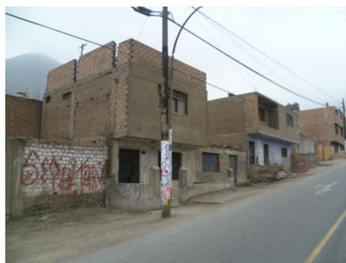
Figura 64. Viviendas de mampostería confinada con techo de losa aligerada
