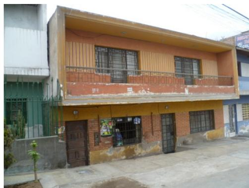
Figura 62. Vivienda de mampostería confinada con techo de losa aligerada.
