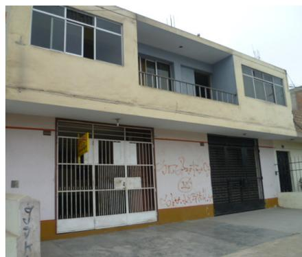
Figura 37. Vivienda típica de albañilería de 2 pisos
