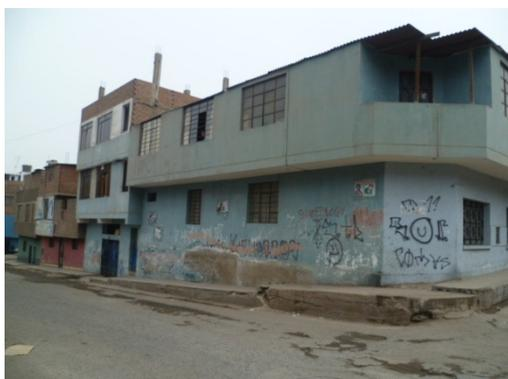
Figura 61. Vivienda de albañilería confinada con techos de calamina
