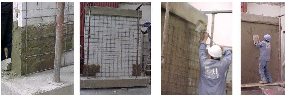
Figura 375: Detalle de refuerzo sobre las caras del muro
