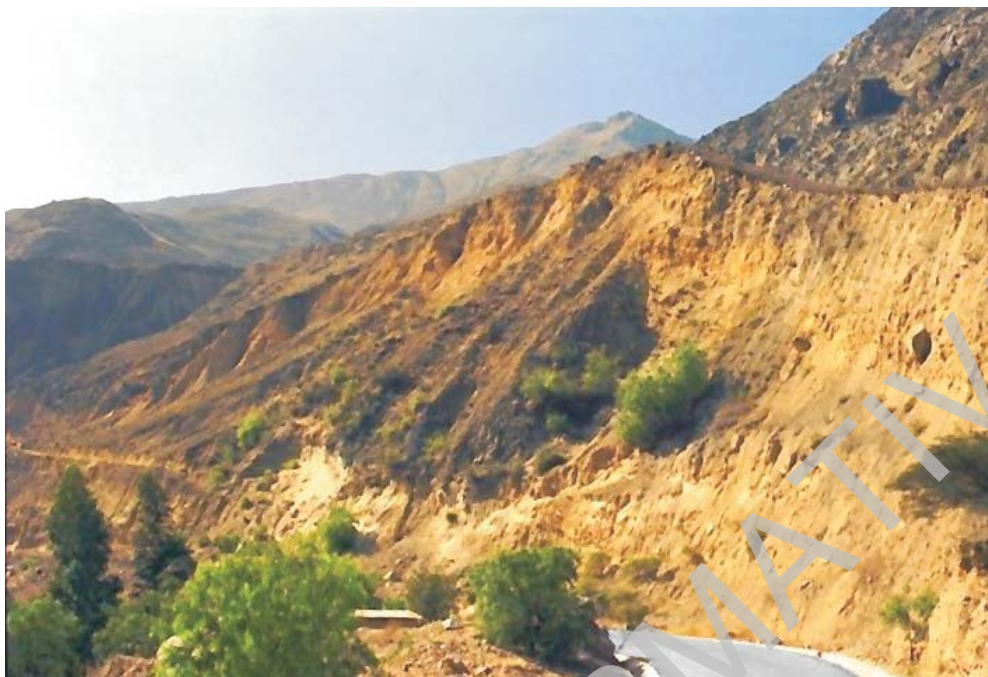
Foto N° 112 Zona Crítica: Cerro Tauripunco (Canta, Lima). Deslizamiento del cerro Tauripunco en la margen derecha del río Chillón que afecta tramo de la carretera Lima-Canta (km 82+500-83+500). (Foto S. Núñez).
