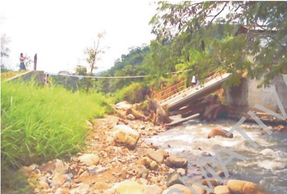
Foto N° 100 Vista aguas abajo el río Panamá, afluente del río Satipo, sector de San Pedro Alto, donde se aprecia el colapso de un puente afectado por un huayco en noviembre de 2002. (Foto B. Zavala).
