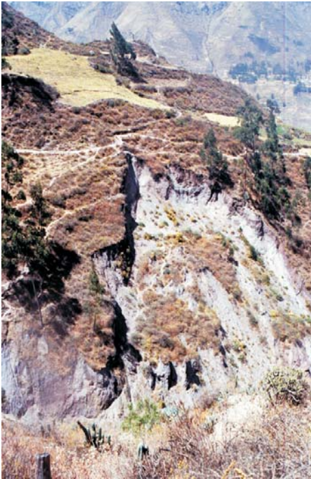
Foto N° 116 Zona Crítica: Quebrada Paihua (Huarochiri, Lima). Margen derecha de la quebrada que muestra una zona de deslizamiento activo en el sector de Paihua; podría generar un flujo aguas abajo y represar el río Rimac, inundando la localidad de Matucana, como los eventos ocurridos en 1959 y 1983. (Foto S. Núñez).
