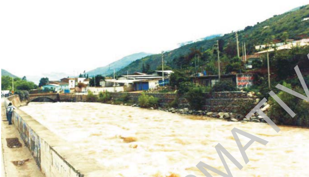
Foto N° 94 Inundación fluvial, año 1998, afectó la avenida 16 de Noviembre, sector de Huancapata, distrito de Ambo, Región Huánuco. (Foto G. Valenzuela).
