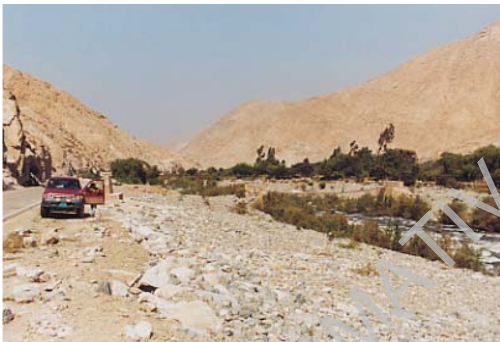
Foto N° 120 Zona Crítica: Sector Huaquish en el río Fortaleza, ambas márgenes, (Chasquitambo, Ancash); erosión fluvial e inundaciones. (Foto L. Fidel).
