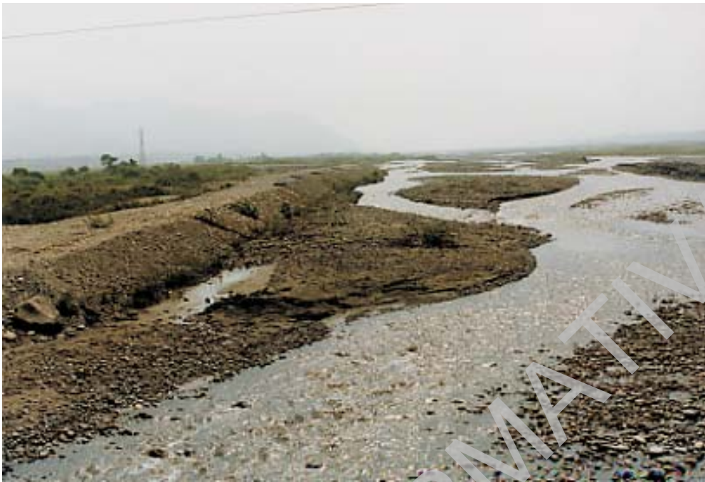
Foto N° 118 Zona Crítica: Sector aguas arriba del Puente Bolívar sobre el río Pativilca en la Carretera Panamericana Norte. Inundación y erosión fluvial en ambas márgenes. Sector crítico hasta su desembocadura en el mar. (Barranca, Lima). (Foto L. Fidel).
