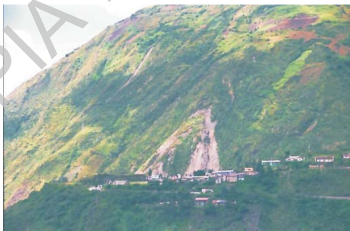
Foto N° 104 Zona Crítica: Sector Carpapata, km 63+500 al 67+000, carretera Tarma Merced. Valle del río Tarma con laderas de fuerte pendiente y substrato rocoso de mala calidad, con ocurrencia de derrumbes, deslizamientos, caída de rocas y huaycos. Afecta periódicamente varios sectores de la Carretera Marginal de la selva. (Fotos B. Zavala).
