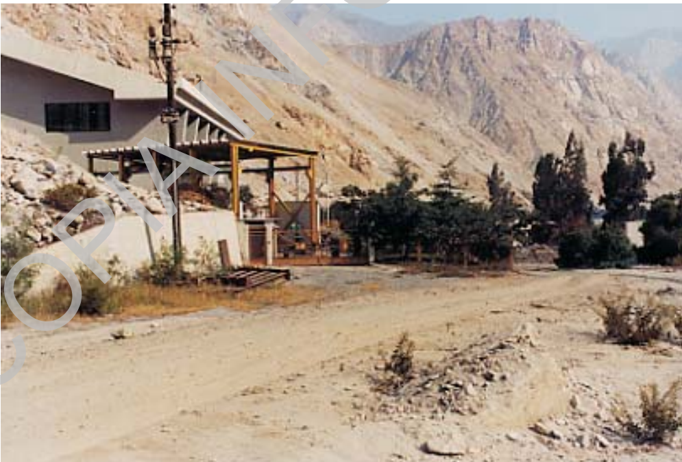
Foto N° 101 Central Hidroeléctrica de Cahua ubicada en la margen izquierda del río Pativilca; afectada por el desembalse artificial del derrumbe de Curquish (Aluvión de Rapay, 2001). (Foto L. Fidel).
