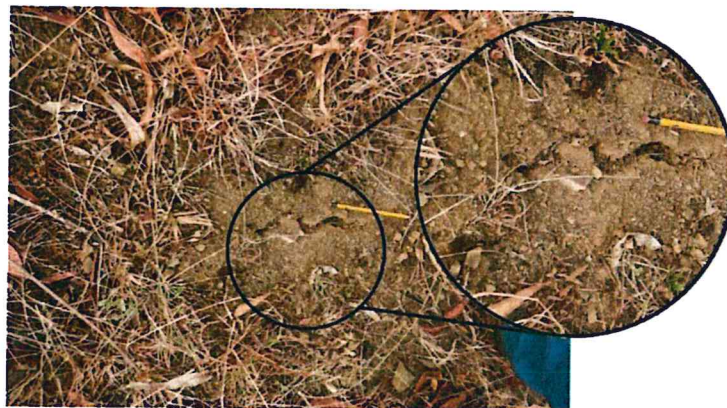
Figura 9. Se aprecian grietas con, 0.07 m de longitud con una separación de 0.02 – 0.04 m
