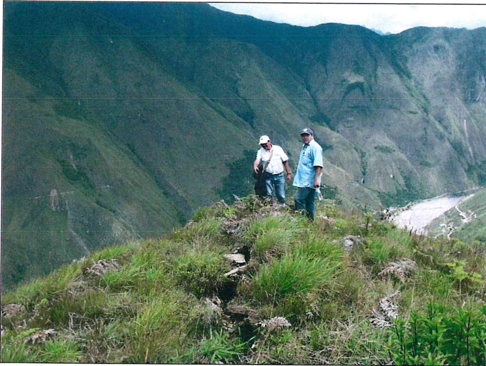
Fotografía 2. Divisoria de aguas del Cerro San Valentín, notar agrietamiento que afecta a ambas laderas del Cerro en dirección a Santa Teresa y Huadquiña. Fuente Gómez J., 2012.
