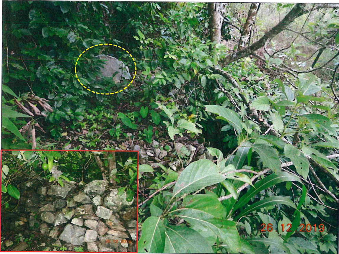
Figura 14. Vista de bloques caídos de la parte alta del cerro San Valentín, los cuales son retenidos por los muros secos construidos en la parte baja.
