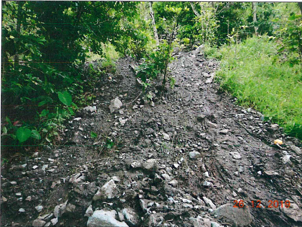
Fotografía 5. Material transportado por el flujo de detritos (huaico) hacia la zona baja.
