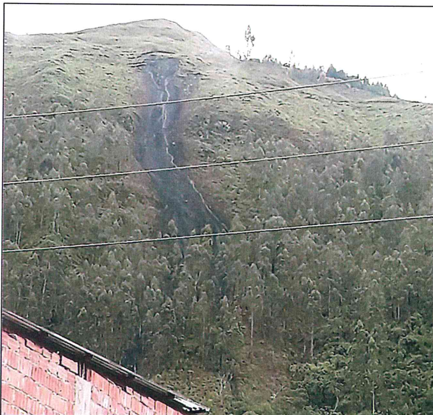
Fotografía 3. Vista de filtración de agua tipo manantial en el cerro San Valentín.
