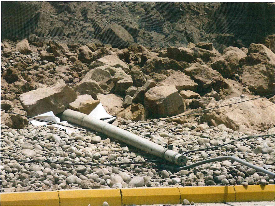
Fotografía 1: En la imagen se puede ver el poste de alumbrado eléctrico afectado por el derrumbe.
