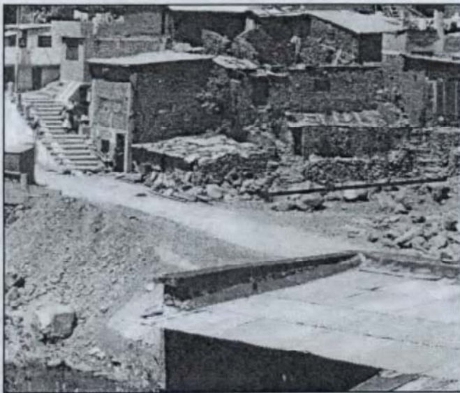
Foto 11.- Margen derecha de la quebrada Chichamaco, se aprecian viviendas ubicadas en su cauce.
