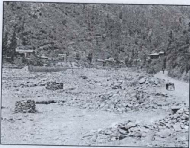
Foto 8.- Zonas de inundación fluvial, ubicada aguas arriba del puente Sandía. En ambas márgenes falta culminar las defensas ribereñas.
