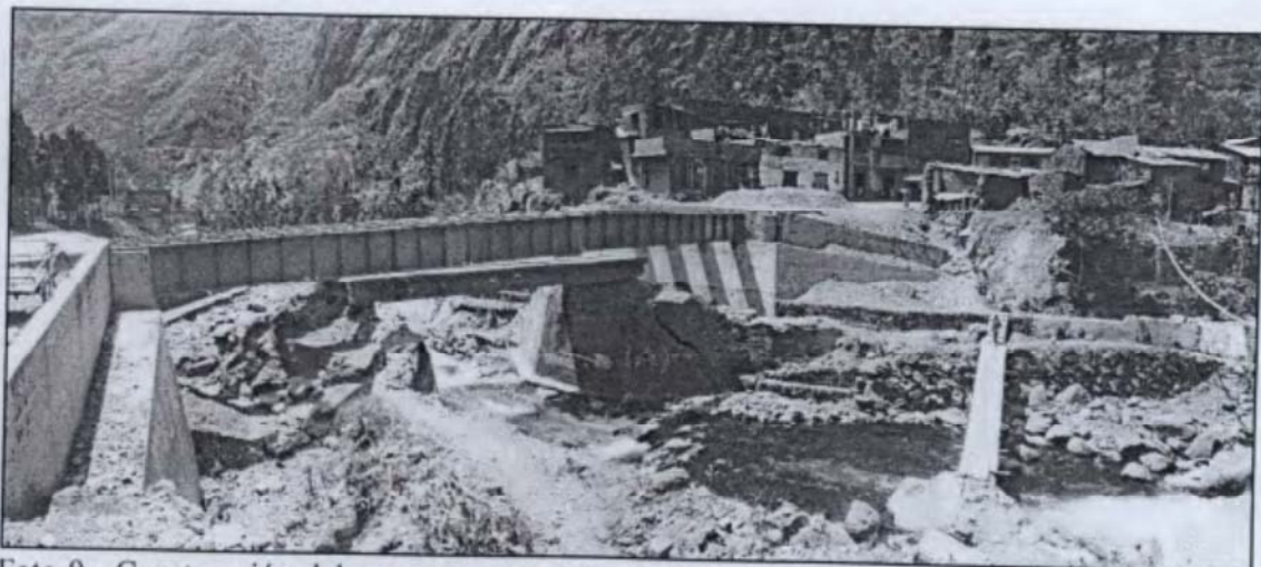
Foto 9.- Construcción del nuevo puente sobre el Río Sandía, aun se aprecian las estructuras falladas (A) del antiguo puente.
