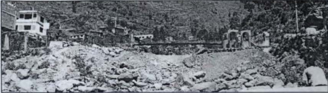
Foto10.- Flujo que discurre sobre la quebrada Chichamaco, se aprecia la cantidad de material suelto en su lecho
