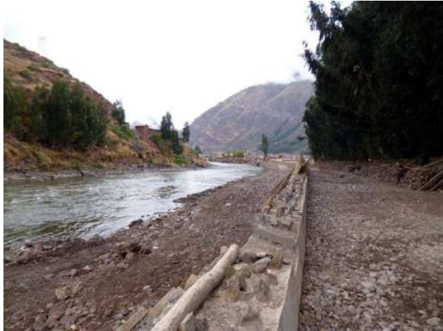
Foto 44: Trabajos de encauzamiento del río Vilcanota con muros de concreto aguas abajo del poblado de Pisac.
