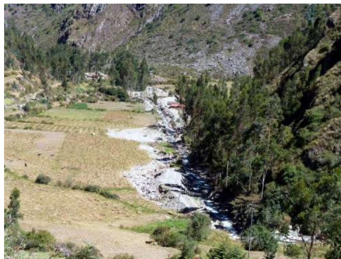
Foto 87: Huaico en el río Patacancha se desbordo y afectó terrenos de cultivo y viviendas en el sector de Huilloc.
