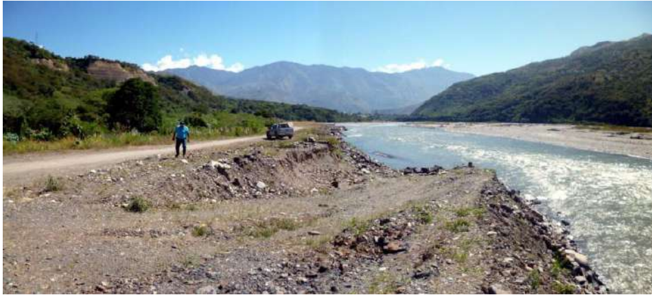
Foto 30: Sector de La Balsa, espigones rehabilitados después del último evento del periodo lluvioso 2008.
