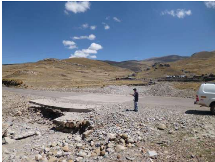
Foto 2: Quebrada que corta la carretera hacia Velille, en el sector de Tarucamarca.
