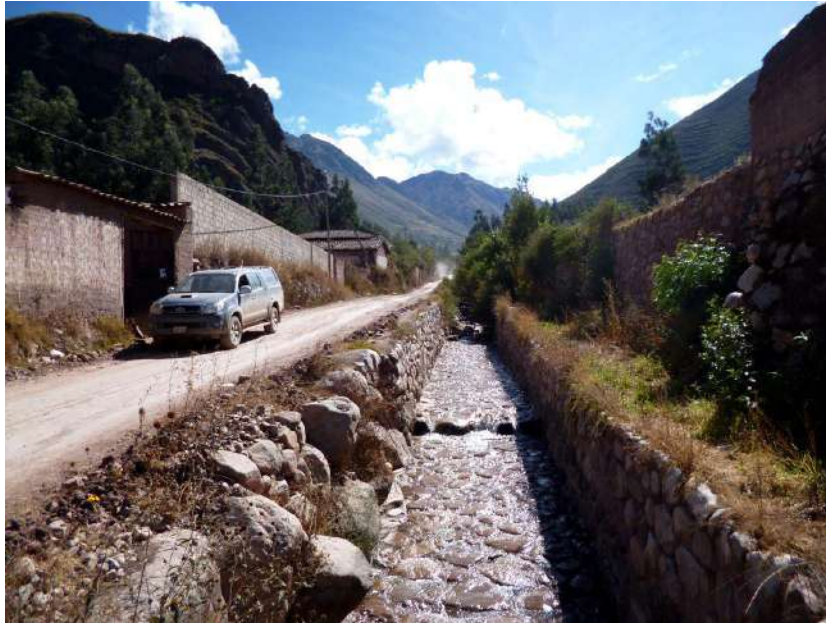
Foto 92: Tramo encausado de la quebrada Chicón en la localidad de Urubamba.
