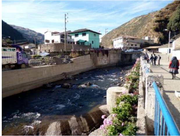
Foto 97: Vista aguas arriba de la quebrada Quencomayo, tramo encauzado con muros de concreto en la localidad de Paucartambo.
