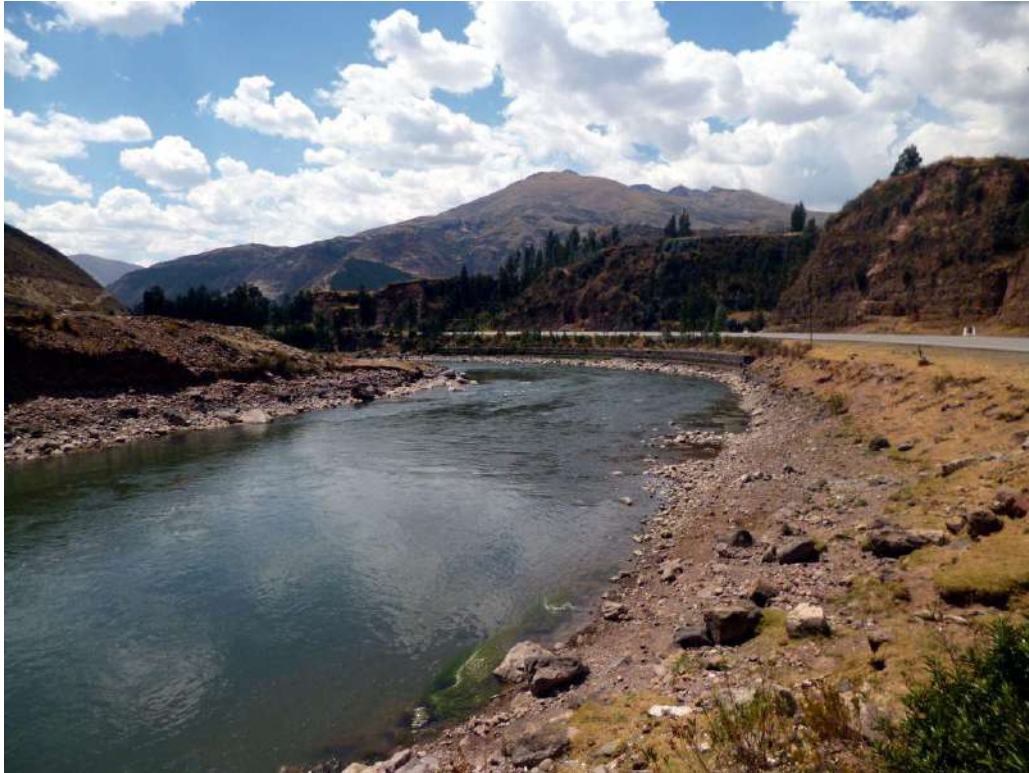
Foto 71: Erosión fluvial en el sector de Cusipata, afecta carretera.
