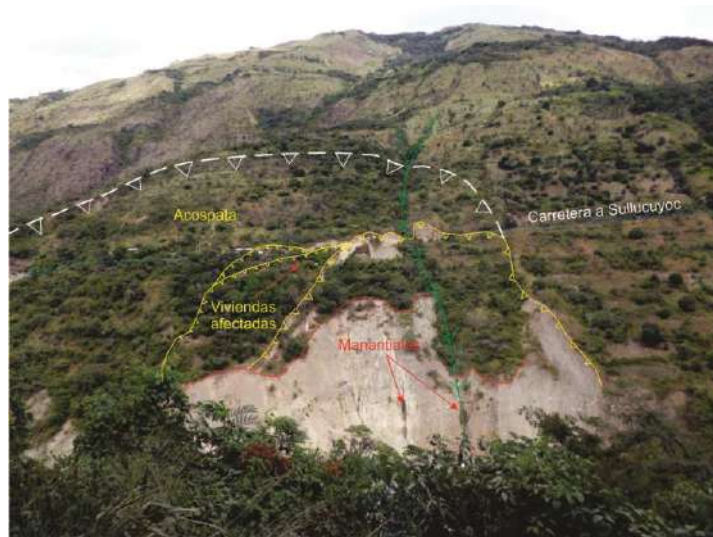
Foto 16: Vista del deslizamiento de Acospata.
