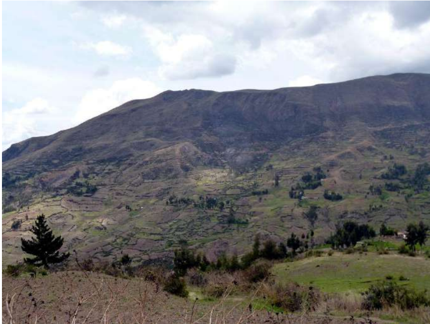
Foto 103: Deslizamiento rotacional antiguo reactivado en el cerro Jachi, produce asentamientos en plataforma de carretera.
