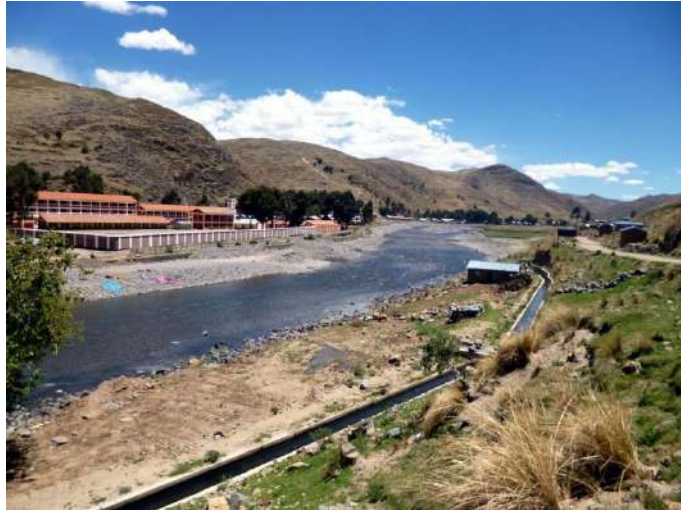
Foto 1: Río Velille produce erosión en ambas márgenes, también inundaciones con subidas del Caudal.
