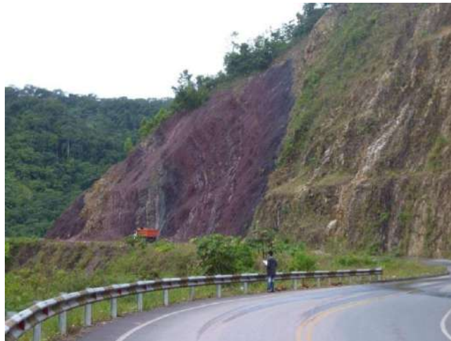
Foto 51: Derrumbe en talud superior de carretera compromete secuencia de areniscas y conglomerados, sector puente Media Luna.
