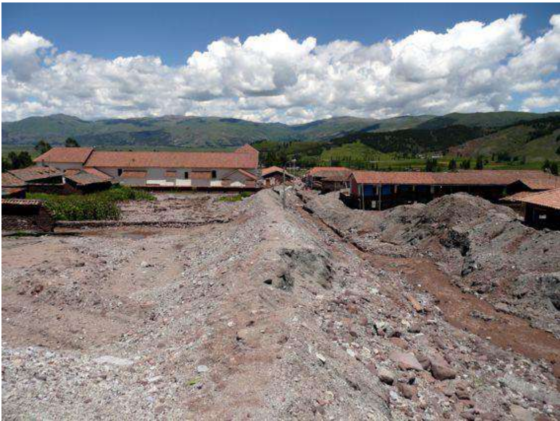
Foto 79: Cauce colmatado de la quebrada Qenqo, el material transportado supero la capacidad de carga del canal produciéndose desbordes y la formación de albardones. El flujo de detritos afecto viviendas y calles de Zurite.
