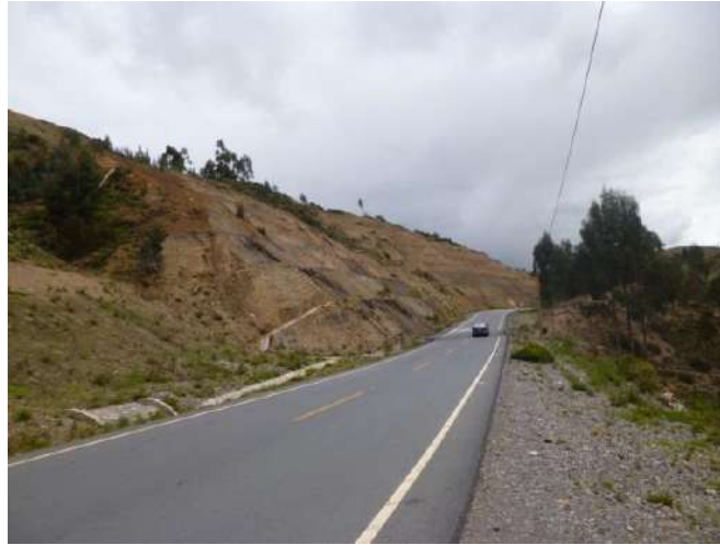
Foto 59: Talud de corte con baquetas que buscan estabilizar la zona afectada por el deslizamiento de Huayllopampa.
