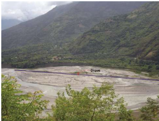
Foto 28: Sector de Mandor, afectado por erosión fluvial.
