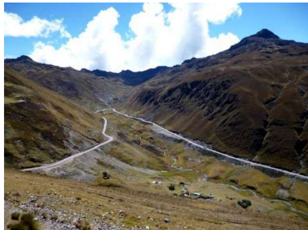
Foto 81: Derrumbes en el talud superior de carretera entre los km 119+500 al 121+500; vista de la quebrada Pillanicancha, tributaria de la quebrada Tanjac.
