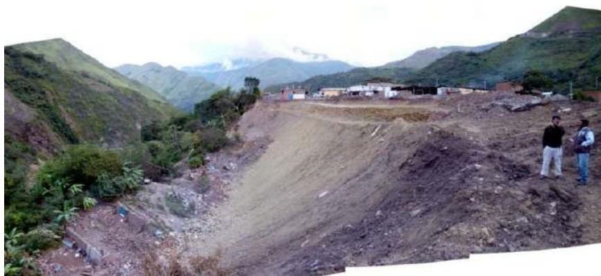
Foto 20: Superficie de ruptura cóncava del deslizamiento de Ocobamba, que produjo la destrucción de 30 viviendas en el poblado de Ocobamba.
