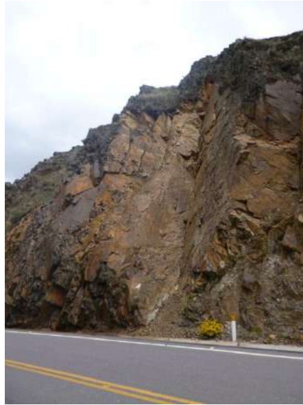
Foto 62: Caída de bloque de roca por mecanismo de falla en cuña, km 52+400 de la carretera Interoceánica.
