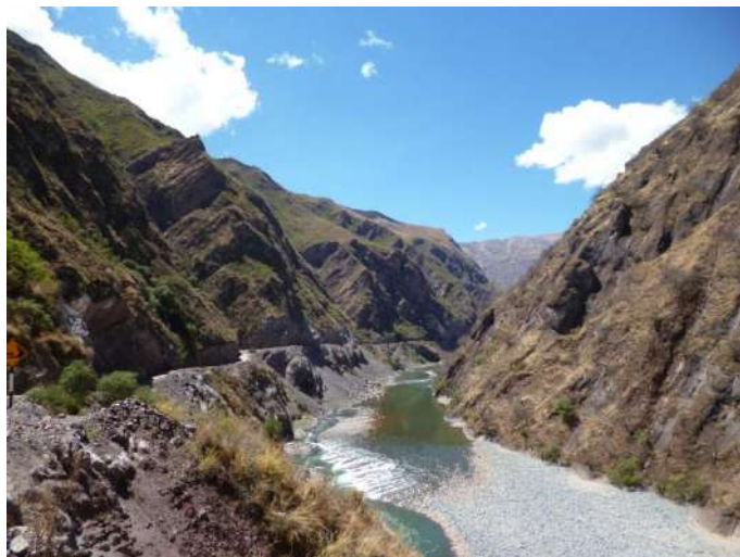
Foto 107: Carretera Cusibamba Bajo-Huaro Bamba trazado en la margen izquierda del valle del río Apurímac, en una ladera que supera los 40° de inclinación.
