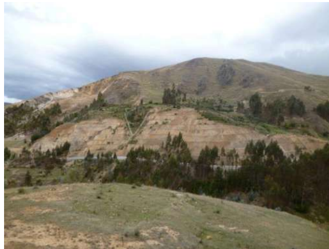
Foto 60: Vista panorámica del deslizamiento de Huyllopampa a la altura del km 50 de la carretera Interoceánica.
