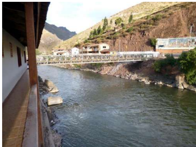
Foto 45: Puente tipo bayle colocado sobre el río Vilcanota para dar pase a la localidad de Pisac; el puente antiguo fue destruido por el caudal del río.
