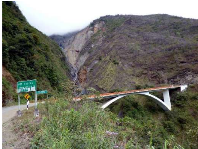
Foto 33: Quebrada con derrumbe activo en la cabecera de cuenca, material caído es acarreado como huaico en el sector de Puente Paccha.
