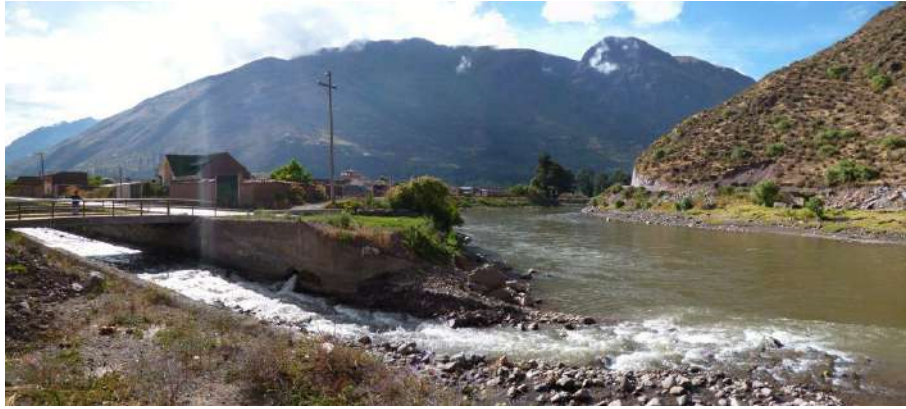
Foto 38: Confluencia del río Ccochoc en el río Vilcanota, se observan la ausencia de protección en la margen derecha del río Vilcanota.
