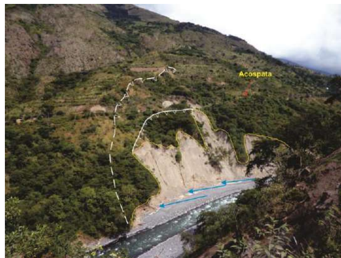
Foto 17: Erosión en el pie del deslizamiento de Acospata.
