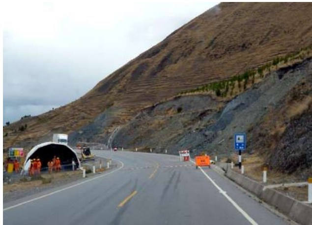
Foto 57: Trabajos de estabilización en zona de derrumbes de la carretera Interoceánica, sector de Cerro Morallaqui.
