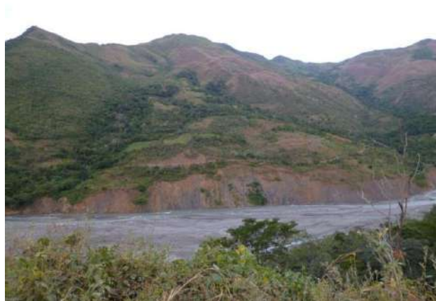
Foto 23: Deslizamientos y erosión fluvial en la base de la ladera en el sector de San Lorenzo, compromete el poblado y carretera.
