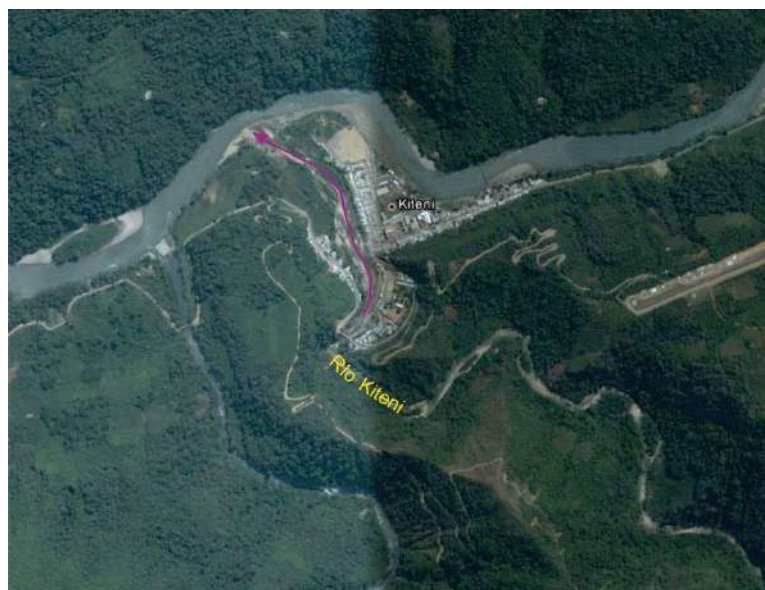
Figura 6.8: Vista del poblado de Kiteni asentado en la margen derecha del río Kiteni, afectado por un huaico el año 1998.
