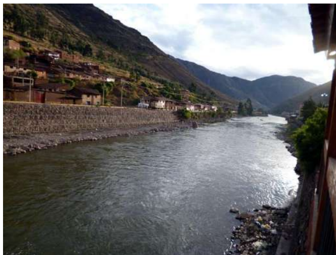
Foto 46: Tramo encauzado del río Vilcanota con gaviones.
