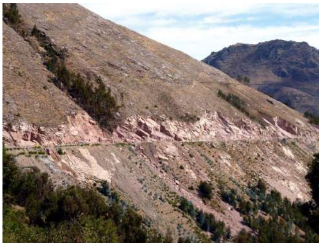
Foto 101: Secuencia de la Formación Huancané que se inclina a favor de la pendiente de la ladera, caída de bloques por falla planar entre el km 12+100 al 16+100 de la carretera a Huancarane.
