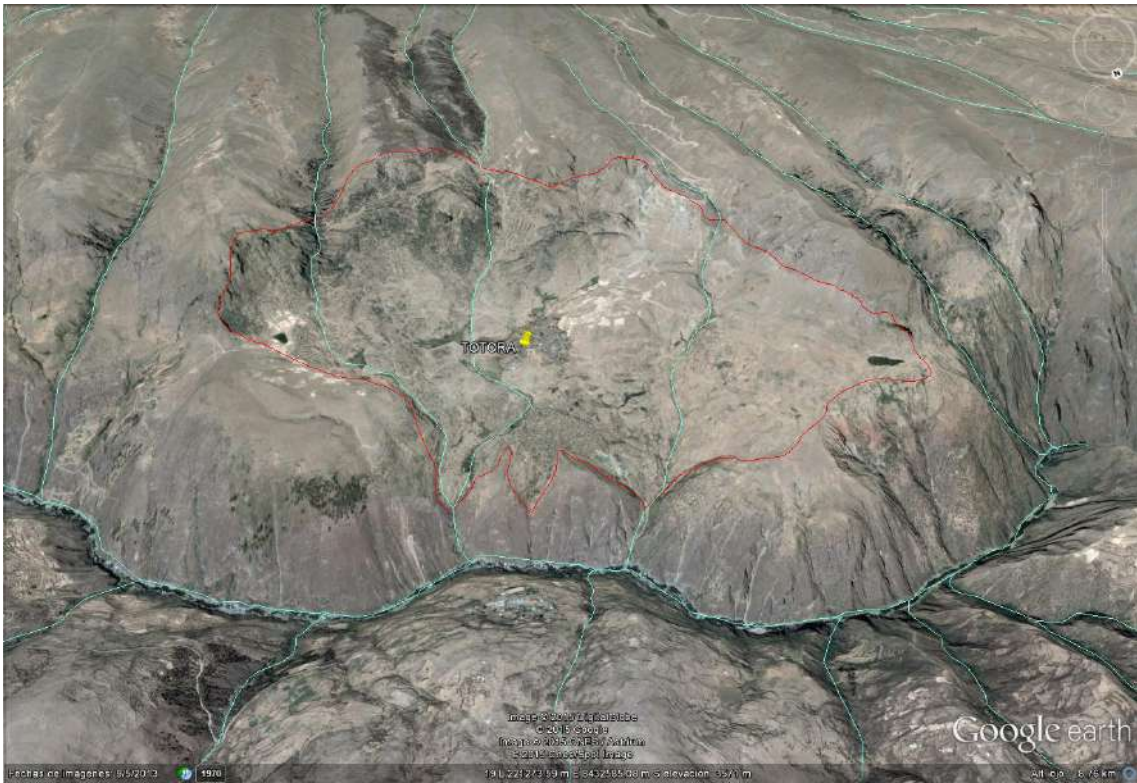
Figura 2: Imagen Google Earth con vista al suroeste donde se señala con líneas rojas los límites del deslizamiento en la localidad de Totorá.
