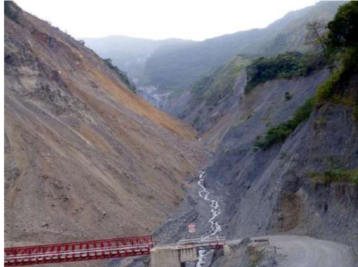
Foto 15: Flujo de detritos en la quebrada de Puente mayo, sector de Mesacancha.
