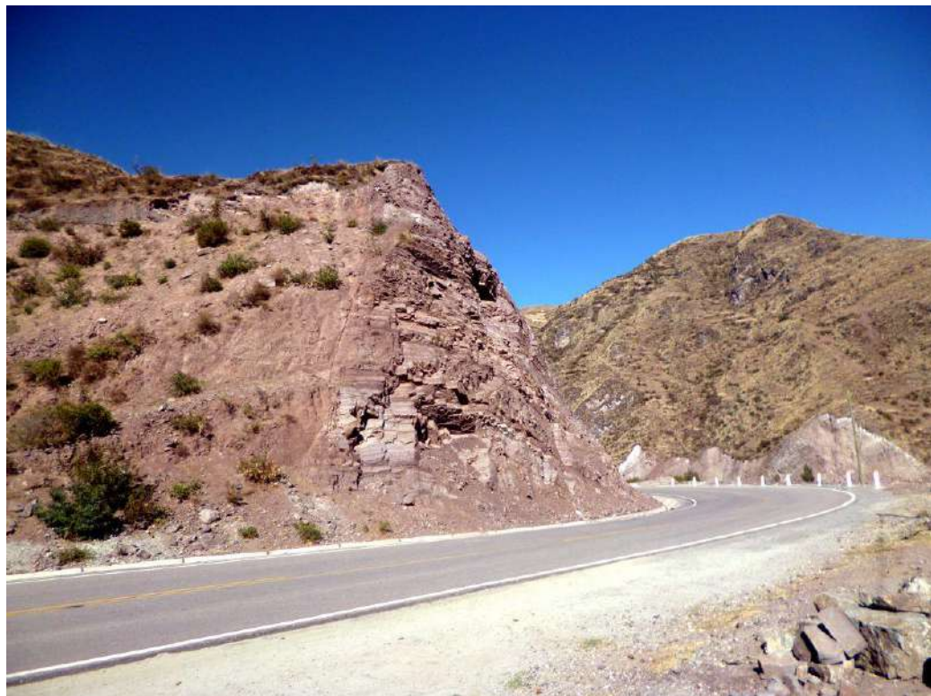
Foto 111: Km 24 de la carretera Acomayo-Pitumarca, con taludes de corte subverticales en capas rojas, las caídas de material están controladas por la estratificación de las capas de roca, la familia de fracturas y la dirección del trazo de carretera.
