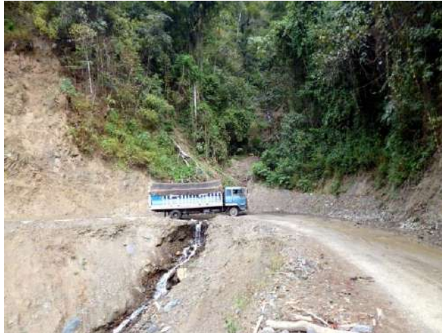
Foto 22: Flujo de detritos que corta la carretera a Ocobamba, cerca de Chinganilla.
