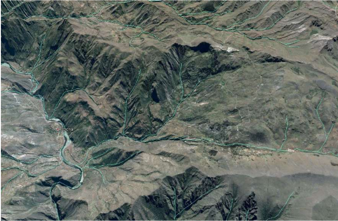
Figura 18: Quebrada Saramayo donde se presentan derrumbes y deslizamientos reactivados que producen el asentamiento de la carretera hacia la localidad de Colcha.
