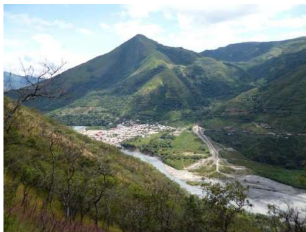
Foto 6.9: Huaico de la quebrada Quellomayoc, puede afectar el poblado de Quellouno asentado en el abanico proluvial.
