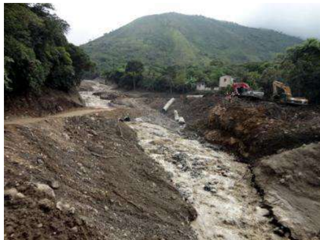
Foto 29: Quebrada Yuracmayo, vista tomada el 14 de febrero, se observa la magnitud del evento, socavó y erosiono su cauce.
