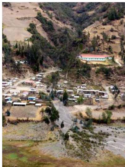
Foto 96: Flujo de detritos que baja por la quebrada Mecllaypata en la margen izquierda del río Paucartambo, puede afectar viviendas del poblado de Mecllaypata.
