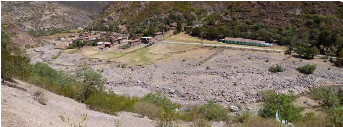
Foto 109: Valle del río Paruro y del poblado de Cusibamba bajo asentado en su margen izquierda cerca a la desembocadura en el río Apurímac, afectado por procesos de erosión fluvial y huaicos, se han colocado espigones con gaviones para evitar que el poblado sea afectado.
