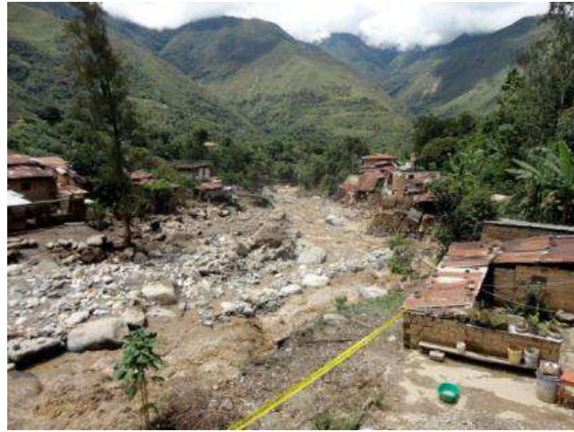
Foto 10: Destrucción de viviendas asentadas cerca del cauce de la quebrada Calquiña en Huyro.
