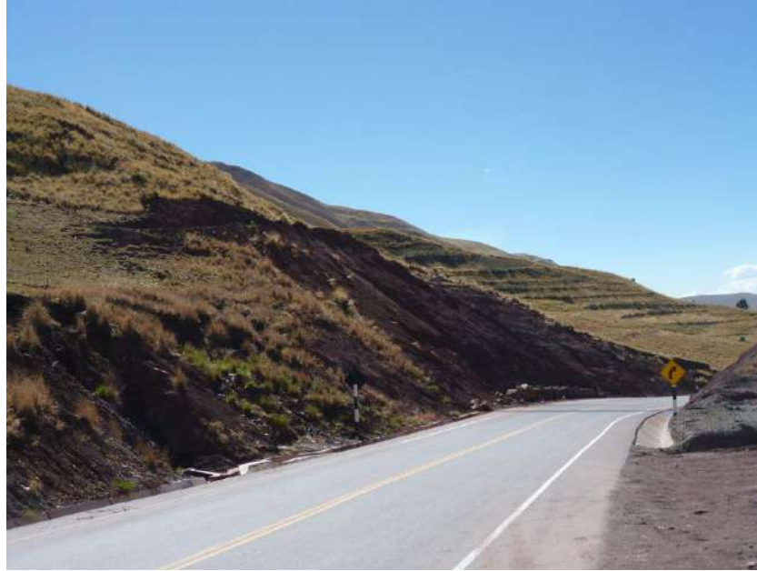
Foto 112: Derrumbe en el talud superior entre el km 14+300 al km 15+900 de la carretera Sicuani-El Descanso-Espinar.
