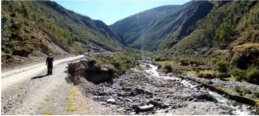
Foto 86: Erosión fluvial en la margen derecha del río Patacancha afecta talud inferior de carretera.
