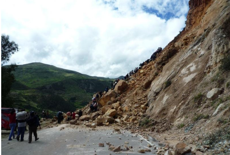
Foto 13: Derrumbe que cortó en febrero del 2010 el tránsito hacia la ciudad de Huancavelica, cerca al poblado de Cachi.
