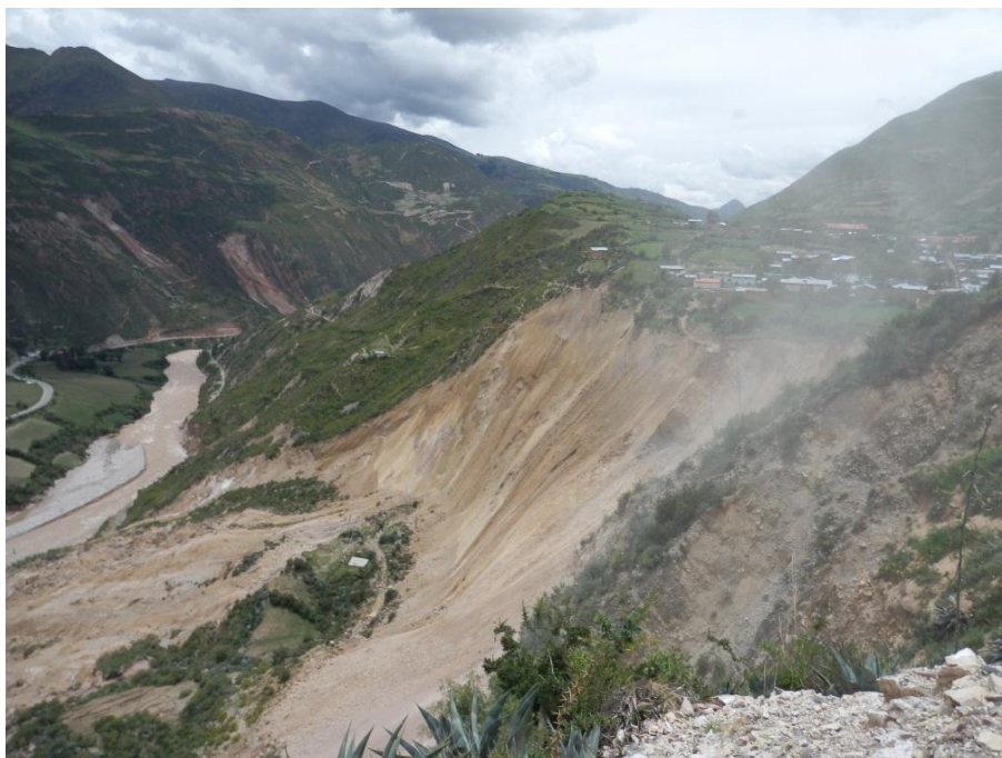
Foto 2: Zona crítica 2, vista lateral del deslizamiento de Cuenca, el material caído represó el río Mantaro.
