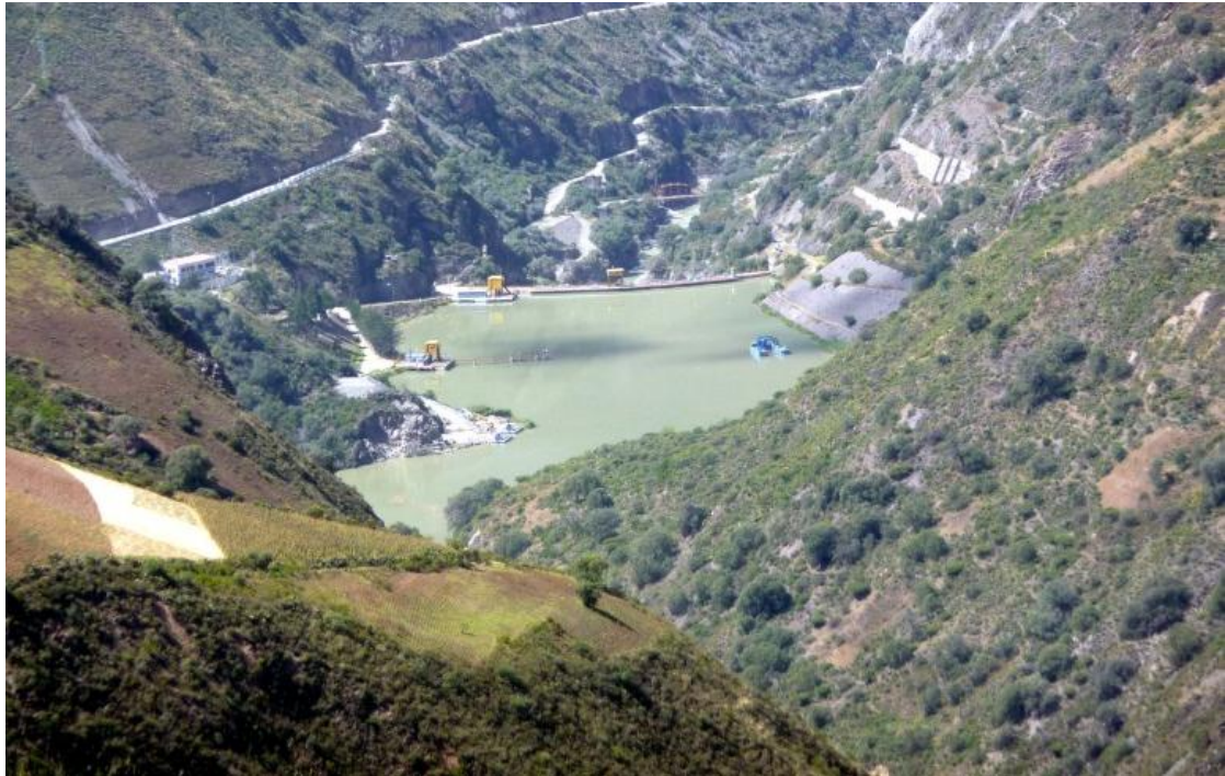
Foto 41: Presa de Tablachaca, se observan muros de contención de concreto colocados en la ladera de la margen derecha para estabilizar un deslizamiento.
