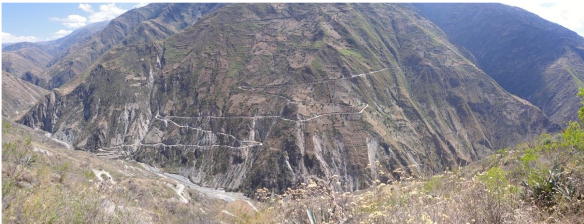
Foto 31: Erosión de laderas en cárcavas a lo largo de las laderas del río Huanchuy, entre Cerro Huamaní- Cerro Chucchuni, carretera a Salcabamba.
