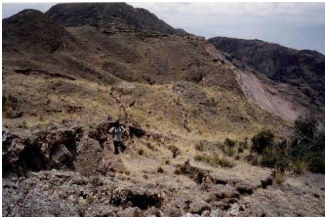
Foto 63: Intensos agrietamientos en las laderas contiguas al deslizamiento de Uralla (cerro Panco), que puede producir deslizamientos de gran magnitud, afectando el centro poblado de Uralla. (Foto: Dávila, 2000)
