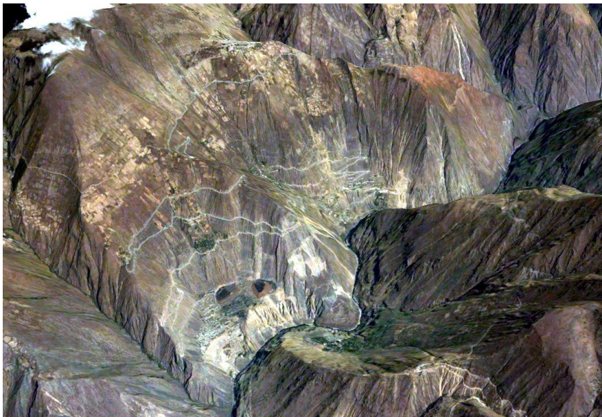
Figura 5: Vista inclinada de la mina Cobriza, se puede observar los derrumbes en la margen izquierda del río Mantaro.
