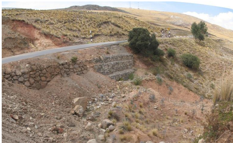
Foto 20: deslizamiento y derrumbes que afecta tramo de carretera en el km 63+200.
