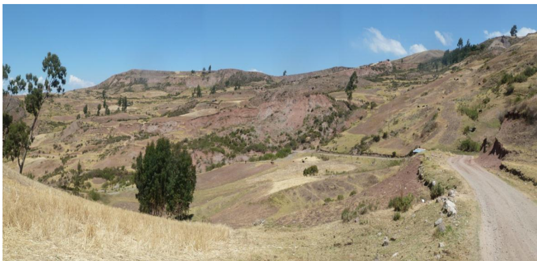
Foto 52: Deslizamiento en Cerro Lirioyoc, sector de Libertad, cerca de Marcas, produce asentamientos en plataforma de carretera.
