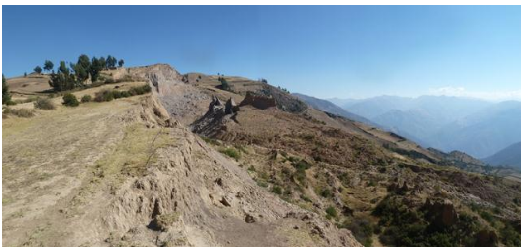
Foto 53: Vista del deslizamiento de Chilcapite, se observa los asentamientos de terreno en la corona.
