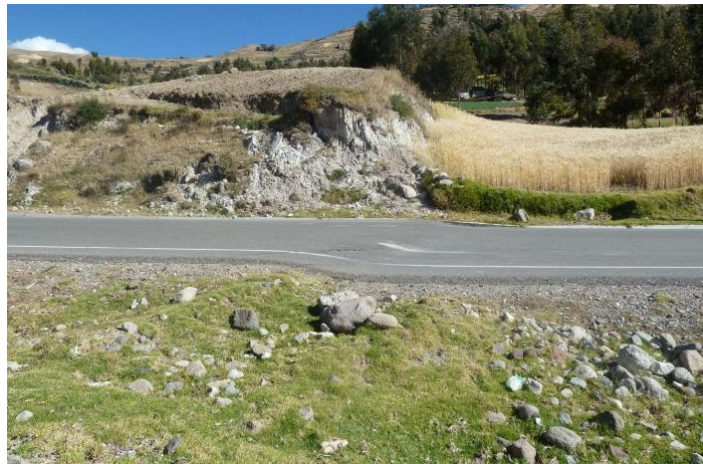
Foto 14. Asentamientos en plataforma de carretera, sector de Huando producido por un deslizamiento.
