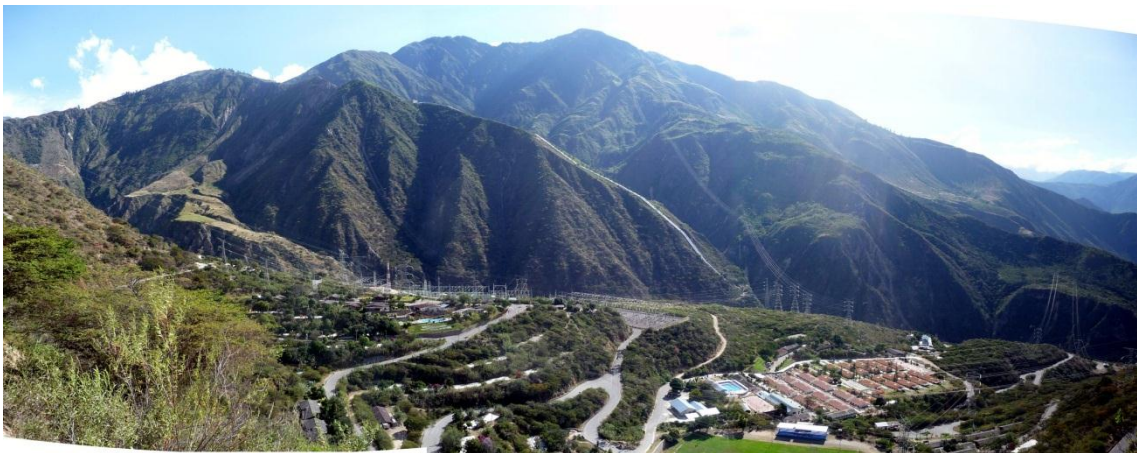
Foto 42: Vista panorámica de la central hidroeléctrica del Mantaro, en Campo Armiño, se observan laderas disectadas por cárcavas.
