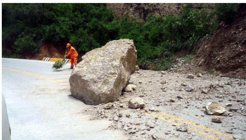
Foto 29: Caída de rocas en la carretera Acostambo-Izcuchaca.
