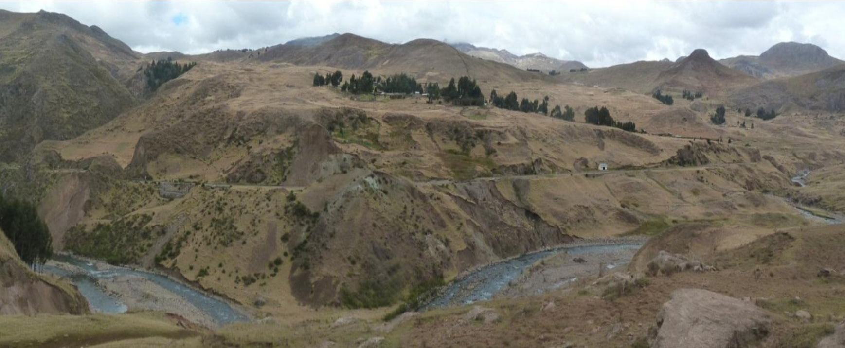
Foto 1: Zona critica 1, movimiento complejos de deslizamientos-flujos, reptación y derrumbes en el sector de Pomagoria/ carretera Huancavelica-Yauli.
