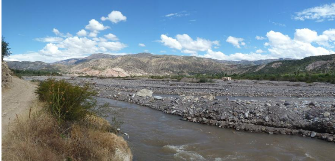
Foto 61: Vista donde es posible observar los efectos de la erosión fluvial hacia ambas márgenes del río Cachi, dejó una vivienda en medio del cauce.
