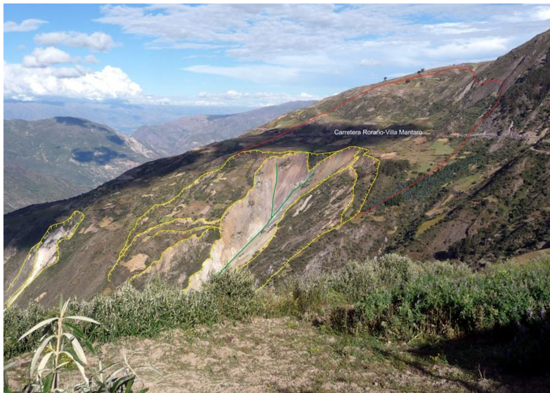
Foto 55: Vista desde el norte, donde se ha resaltado con líneas amarillas la zona de derrumbe activa, reactivación en el cuerpo de un deslizamiento antiguo (línea roja) en Huachirpampa-Rosario.
