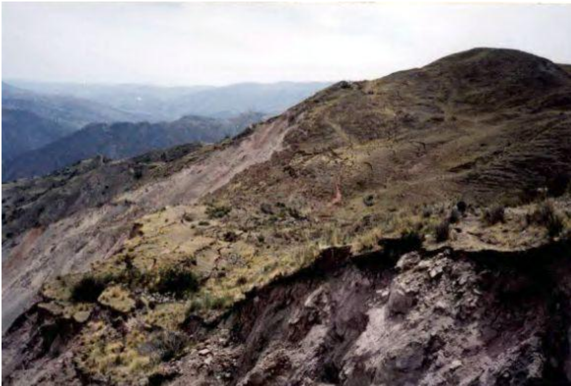
Foto 62: Sistema de agrietamientos intensos en la ladera superior de la zona de arranque (corona) del deslizamiento del 16-03-2000, en Uralla. (Foto: Dávila, 2000)
