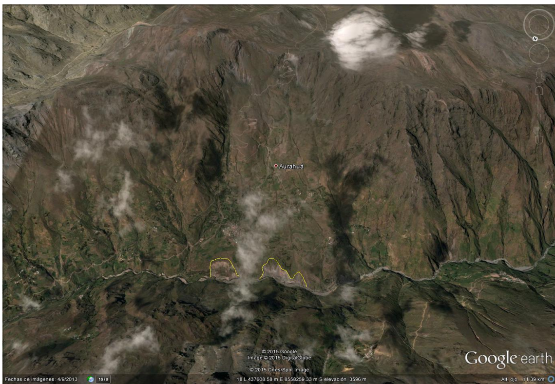
Figura 8: Vistas hacia el este donde se aprecia la localidad de Aurahuá asentada en el cuerpo del deslizamiento antiguo, las reactivaciones en el pie del deslizamiento fueron delimitadas con línea amarilla.
