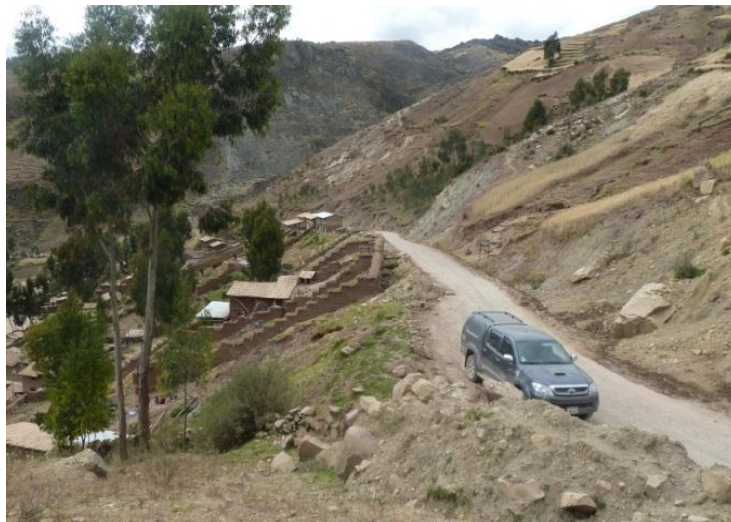
Foto 17: Derrumbe de rocas y suelos km.11+700 Huancavelica-Yauli, afecta tramo de carretera y viviendas asentadas debajo.
