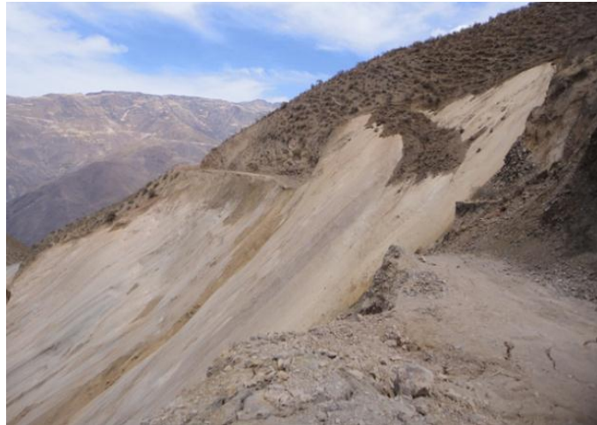
Foto 50: Vista del deslizamiento en las progresivas 39+450- 44+200 / Cerro Jayana, se observa el plano de deslizamiento (2011).
