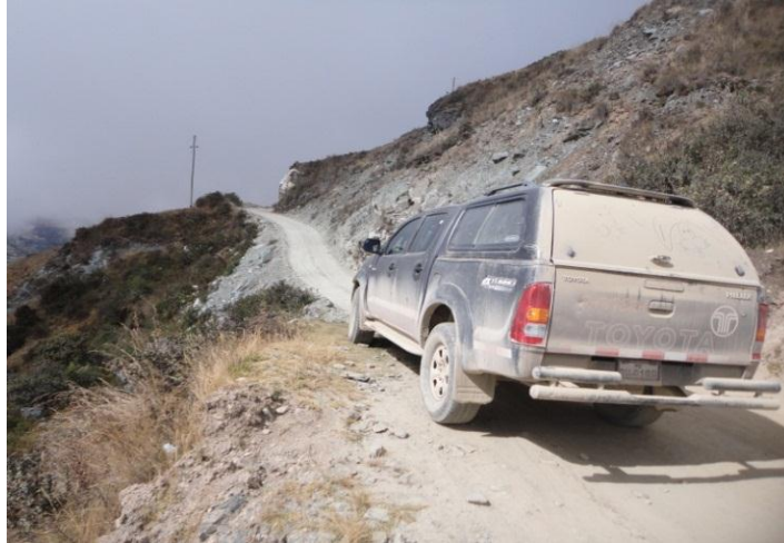
Foto 30: Asentamientos en plataforma de carretera por deslizamiento activo en la Quebrada Mantaca; Carretera a Colcabamba.
