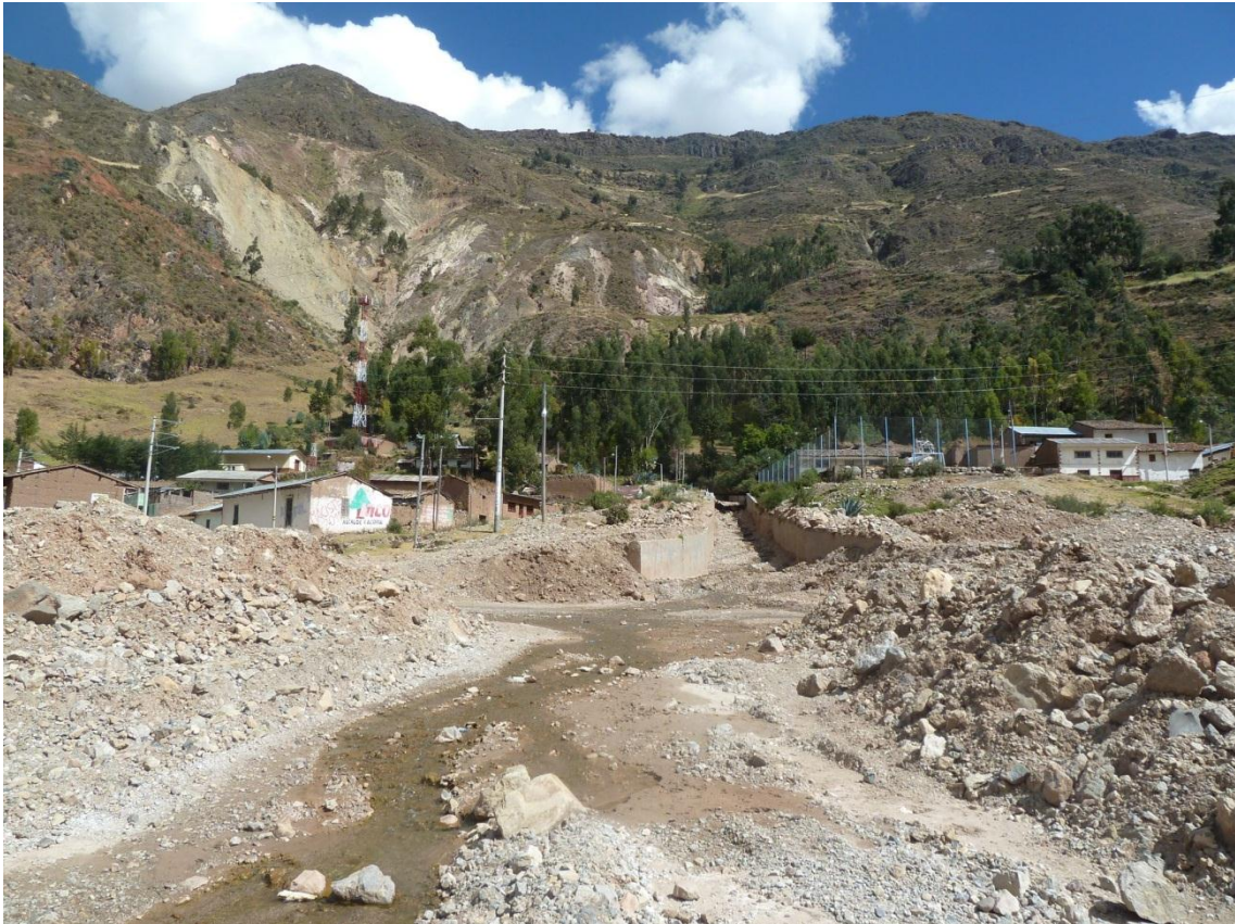
Foto 7: Huayco que baja desde cárcava que pasa por el medio del poblado de Acoria, se ha encauzado la quebrada.
