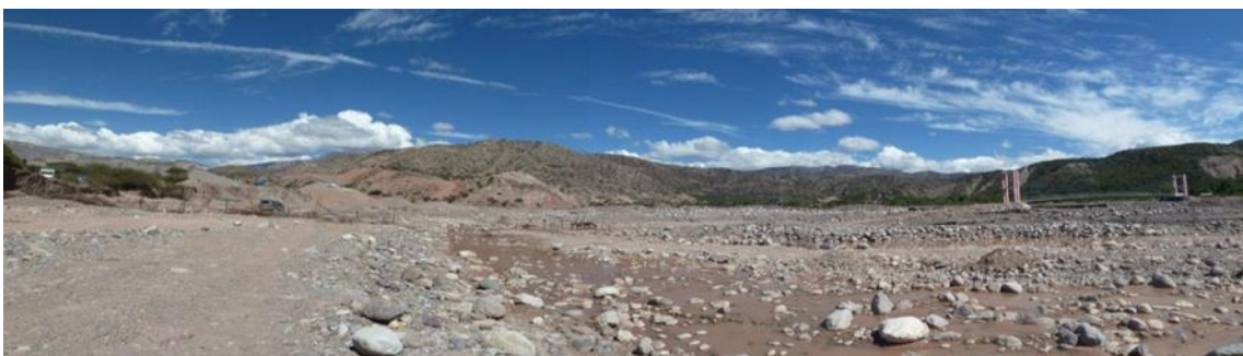
Foto 60: Puente vehicular que permite el acceso hacia Llamoctachi, quedo en medio del cauce del río Cachi, debido a la intensa erosión sufrida en ambas márgenes.
