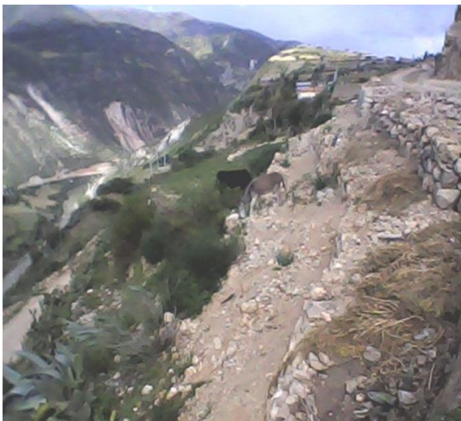
Foto 3: Zona crítica 2, vista de perfil de escarpas iniciales de deslizamiento, tomada el año 2011.
