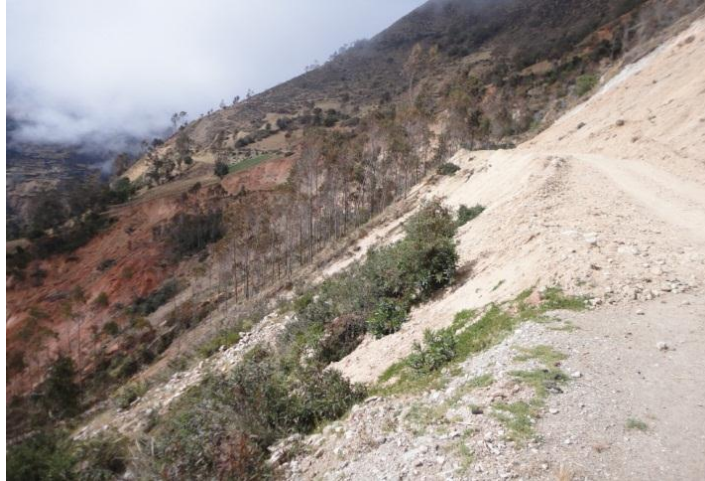
Foto 33: Cárcavas con crecimiento retrogresivo a manera de derrumbes y deslizamientos, sector Santa Cruz de Bellavista.
