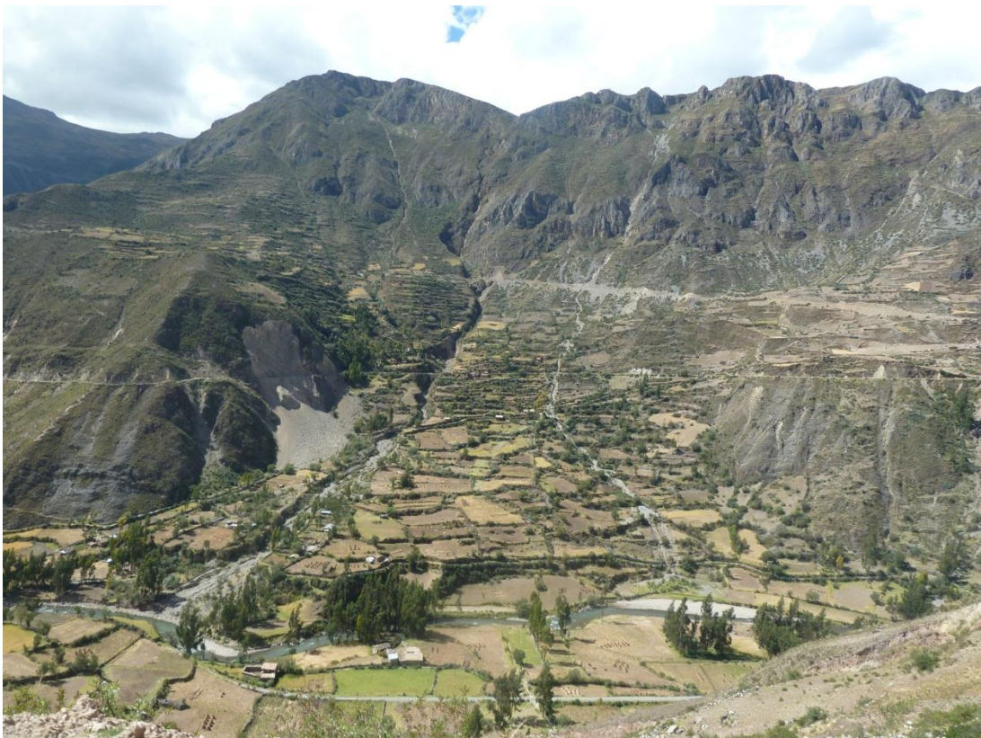
Foto 6: Mega deslizamientos reactivados como derrumbes por cortes realizados en la ladera para construir la carretera hacia la localidad de Mariscal Cáceres.
