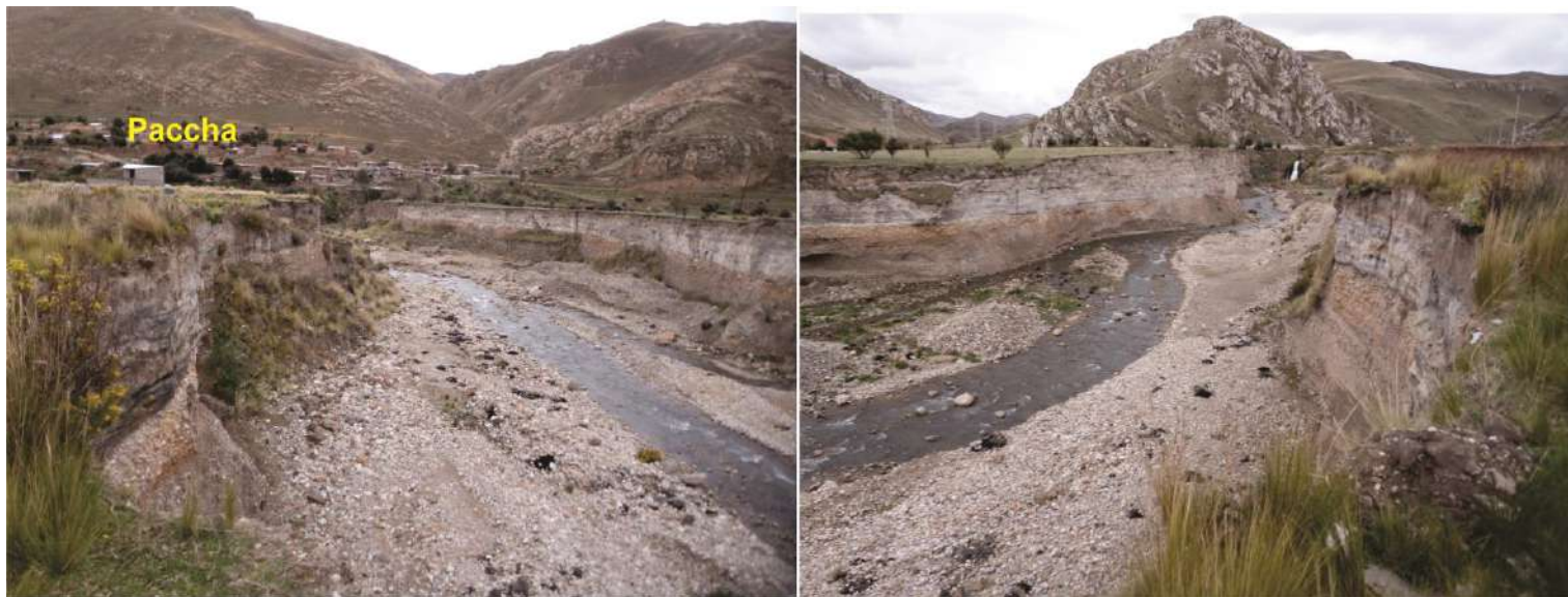
Foto 7.1. Erosión fluvial en ambas márgenes del río Mantaro, en el sector Paccha.
