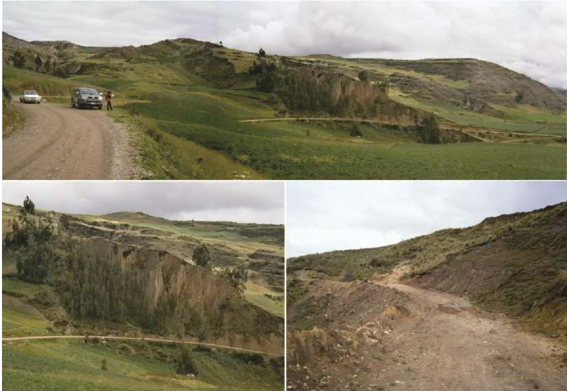
Foto 7.14. Vista de intensa erosión en bad lands, con presencia de derrumbes en el talud superior de carretera Paccha-Jauja, sector Casa Blanca.
