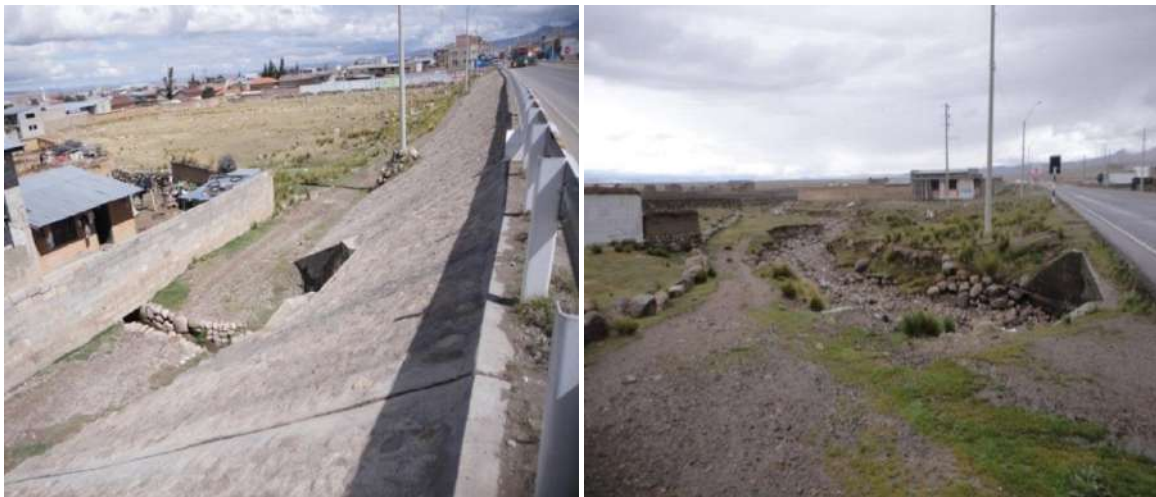
Foto 7.3. Viviendas del poblado Junín se ubican sobre el cauce de la quebrada Santa Catalina, altura del km 0+700 de la carretera Junín-Pasco.
