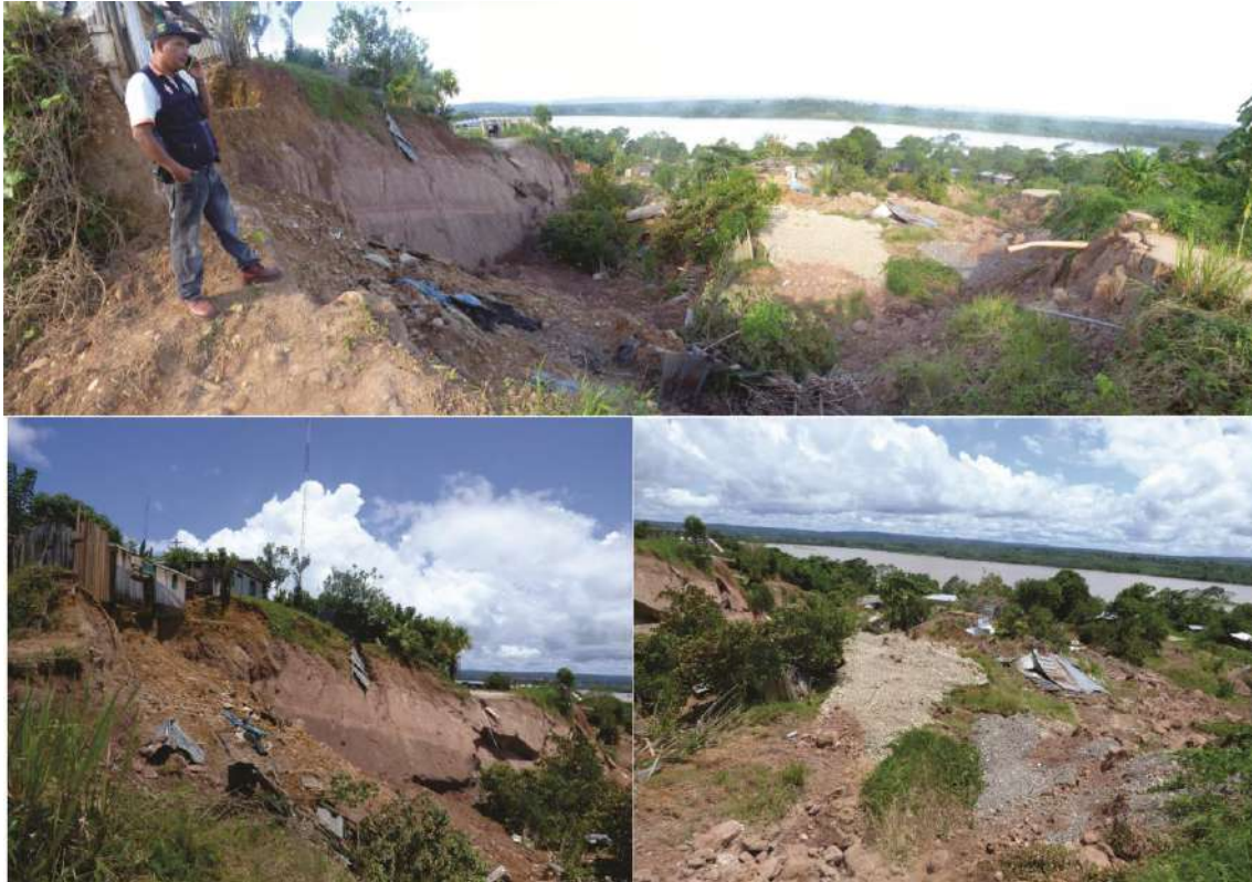
Foto 7.28. Deslizamiento en el sector Villa Junín, en la margen izquierda del río Tambo. Tomado por S. Nuñez, 2015
