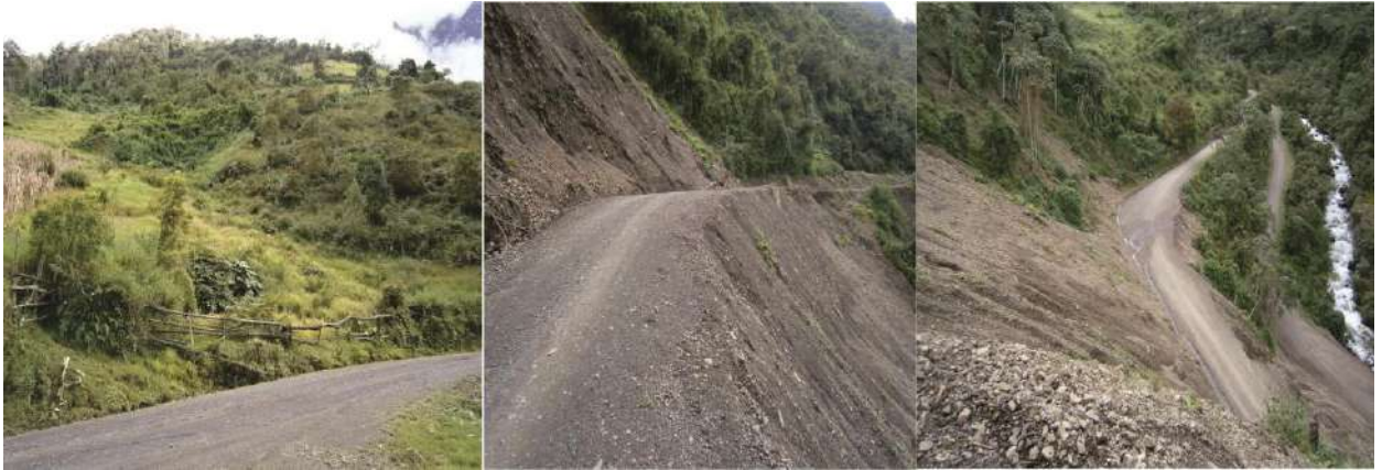
Foto 7.25. Deslizamiento activo con presencia de asentamientos y derrumbes en la carretera Comas – Satipo, en el km 152+950.
