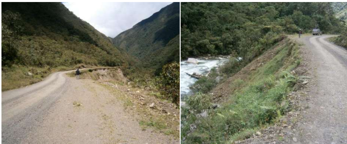
Foto 7.26. Carretera Comas-Satipo que por sectores la plataforma ha sido erosionada por el río Yungorplaya.
