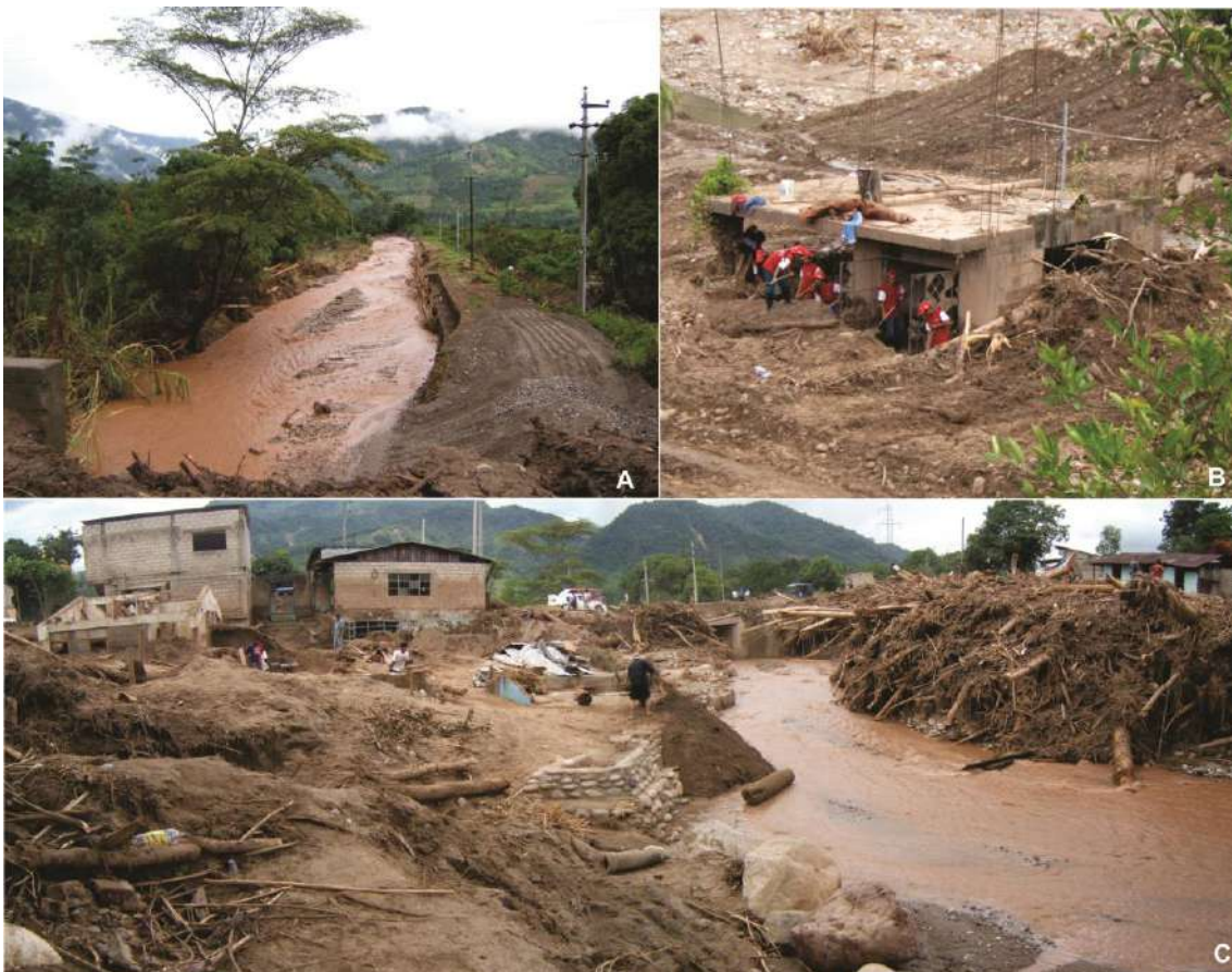
Foto 7.11. A) Quebrada cuyo huaico del año 2007 ocasionó la pérdida de dos personas y la destrucción de varias viviendas. B). Vivienda enterrada por depósito de huaico en el sector Huacará. C) Sector Huacará, zona afectada por huaicos y palizada, se observa el puente Huacará obstruido por palizada y bloques de roca. Tomado por Nuñez, S. (INGEMMET, 2007).
