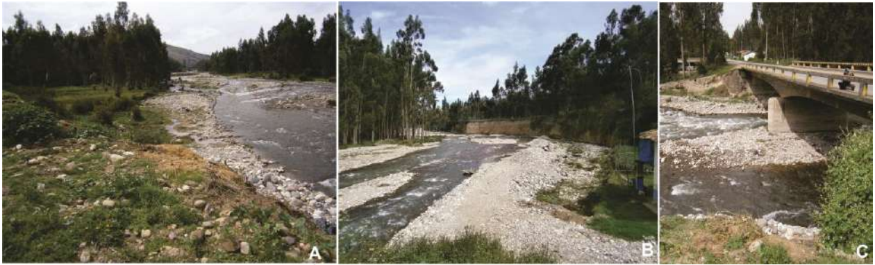
Foto 7.17. Vistas del río Achamayo, A) Área sujeta a inundación en la margen derecha del río Achamayo, B) Erosión fluvial en la margen derecha del río, C) Erosión en estribo derecho del Puente Santa Rosa de Ocopa.
