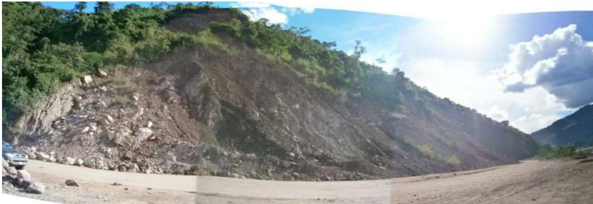
Foto 7.10. Derrumbes en talud superior de la Carretera Marginal Santa Ana-Maranquiari, sector Maranquiari.
