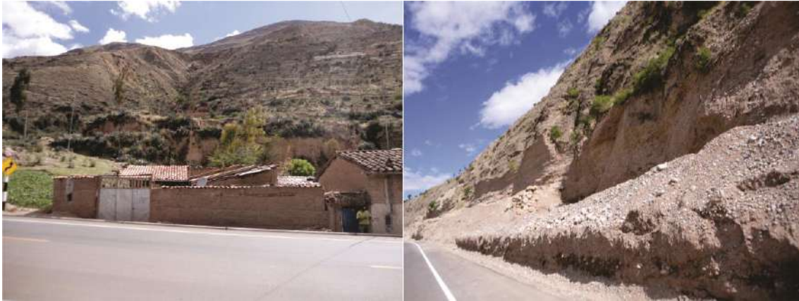
Foto 7.23. Erosión en cárcavas en el sector Iscotiana, también genera derrumbes en talud superior de la carretera Chupaca-San Blas.
