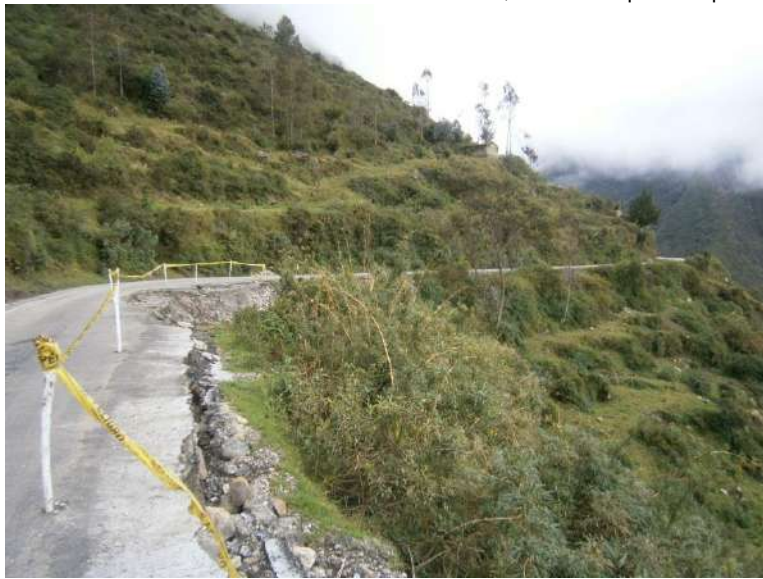
en la carretera Ingenio-Comas, se llevó una parte de la carpeta asfáltica en el km 51+500.
