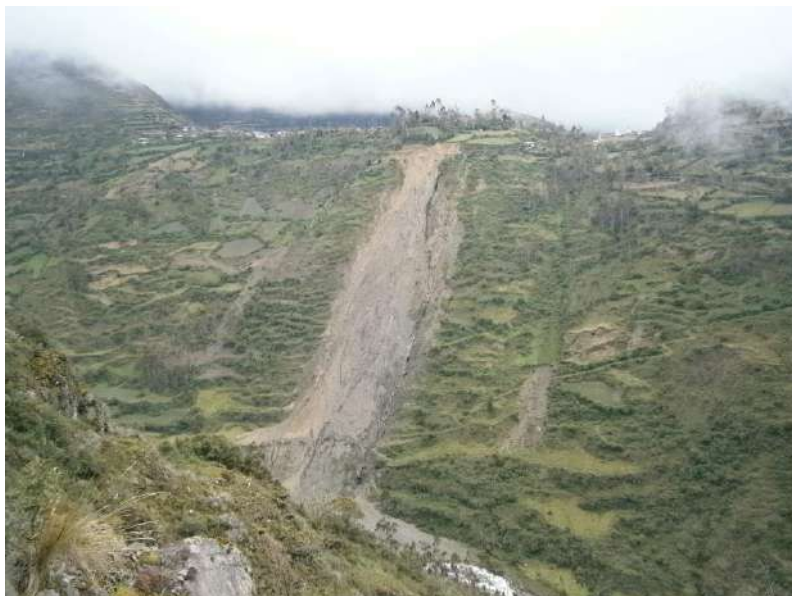
Foto 7.19. Se observa un derrumbe debajo del poblado de Comas en laderas del cerro Milupata, cuyo material originó el embalse del río Comas
