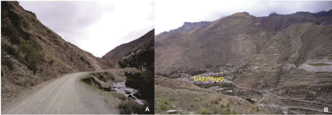
Foto 7.2. A) Desviación del cauce del río Ulcumayo, en la margen derecha presenta erosión fluvial. B) En la otra vista se observa al poblado Ulcumayo asentado sobre el depósito antiguo de una avalancha del cerro Huallimarca.
