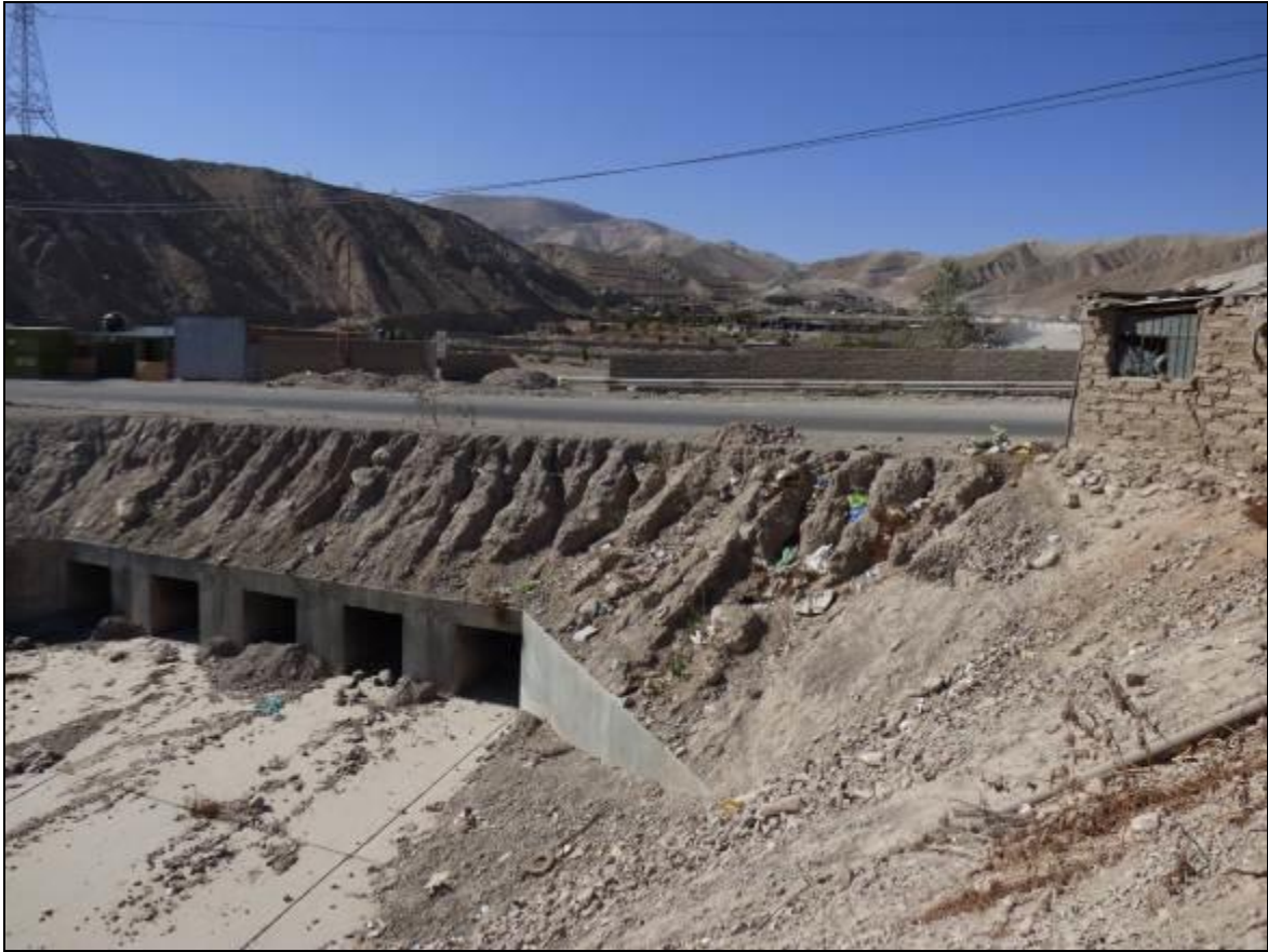
Foto 11. Puente que comunica los distritos de Samegua y Moquegua, construidos dentro del cauce de la quebrada El Cementerio.
