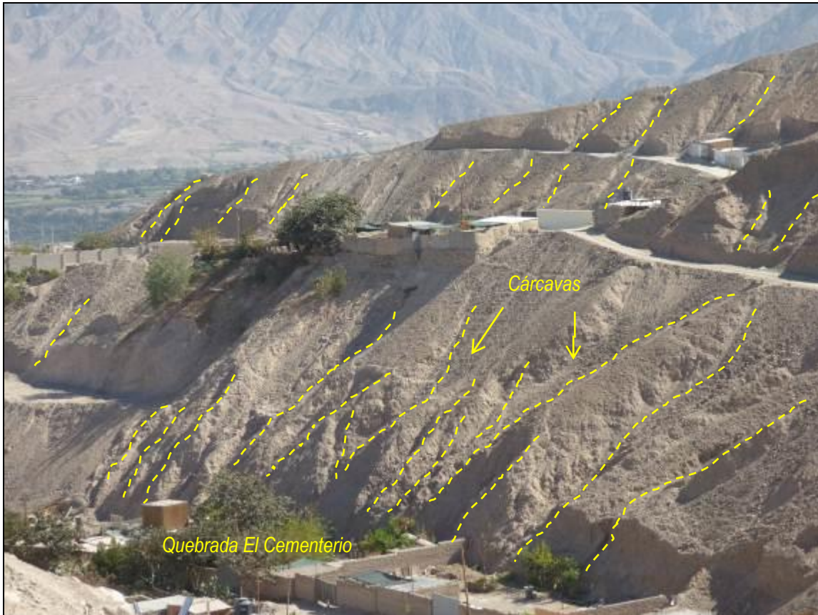
Foto 12. Erosiones en surco en la margen izquierda de la quebrada El Cementerio, generando material suelto que es vertido en la quebrada. En la parte superior se observa viviendas construidas sobre cortes del talud.
