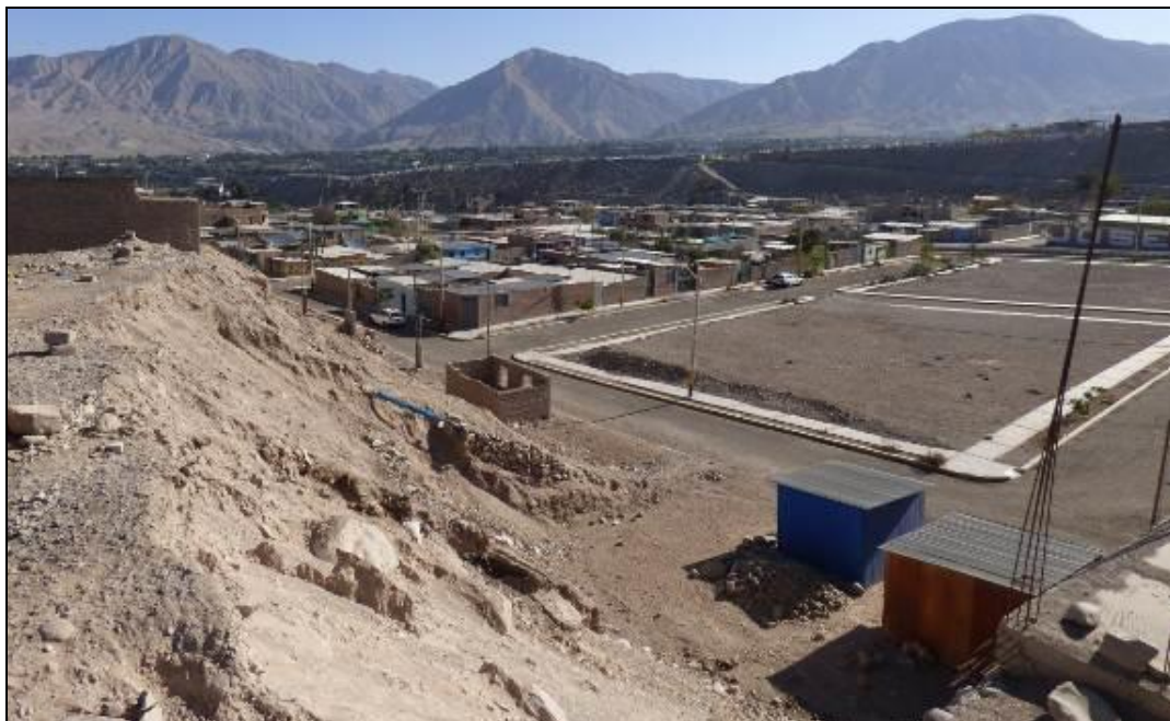
Foto 8. Viviendas asentadas dentro de la quebrada El Cementerio.
