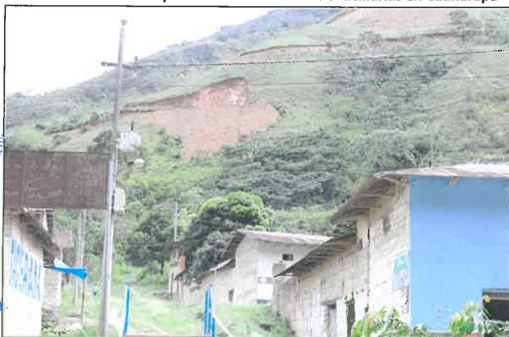
FOTO N° 07 Alumbrado Público y conexiones eléctricas domiciliarias en Caunarapa
