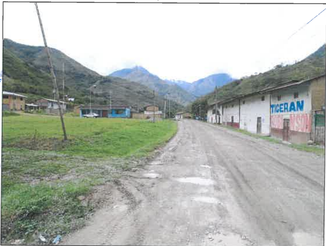
FOTO N° 06 Material de construcción Predominante en viviendas del Centro Poblado de Cañarapa
