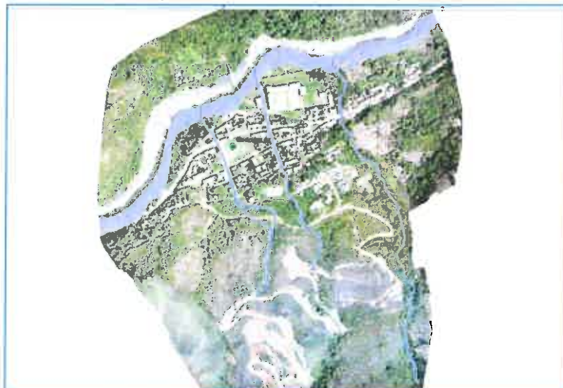
IMAGEN N° 03 Depósito Fluvial en Cañarapa
