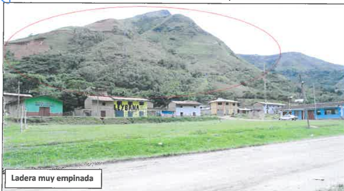
Ladera de montaña con pendiente Muy Empinada Centro Poblado de Cañarapa
