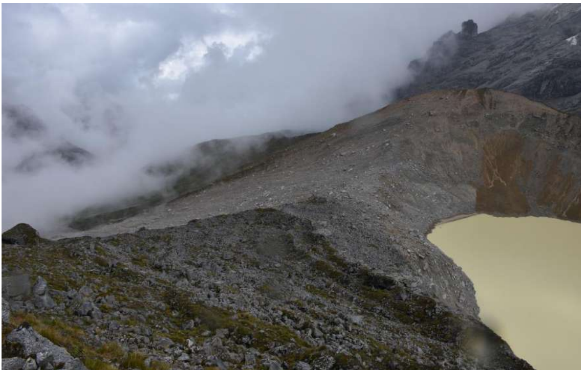
Figura 4. Zona frontal, se observa la huella del flujo de agua que sobrepasó la cota de rebose, también la erosión producida en la cara exterior (Fuente: INAIGEM / O.Vilca – 25.02.2020)
