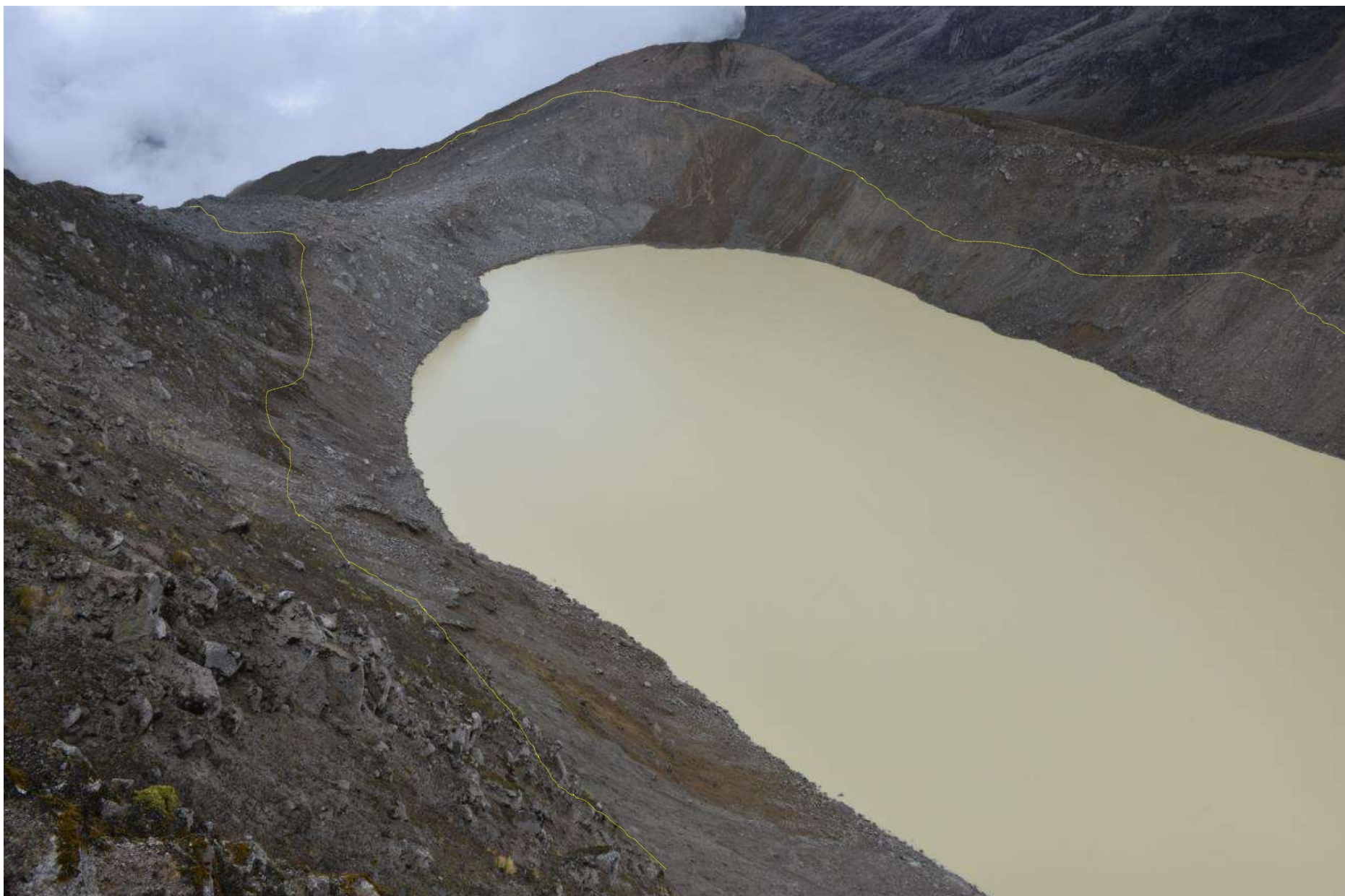
Foto 4. Taludes interiores del vaso, en línea amarilla se señala el impacto de los oleajes producidos por la avalancha (Fuente: INAIGEM / O.Vilca).
