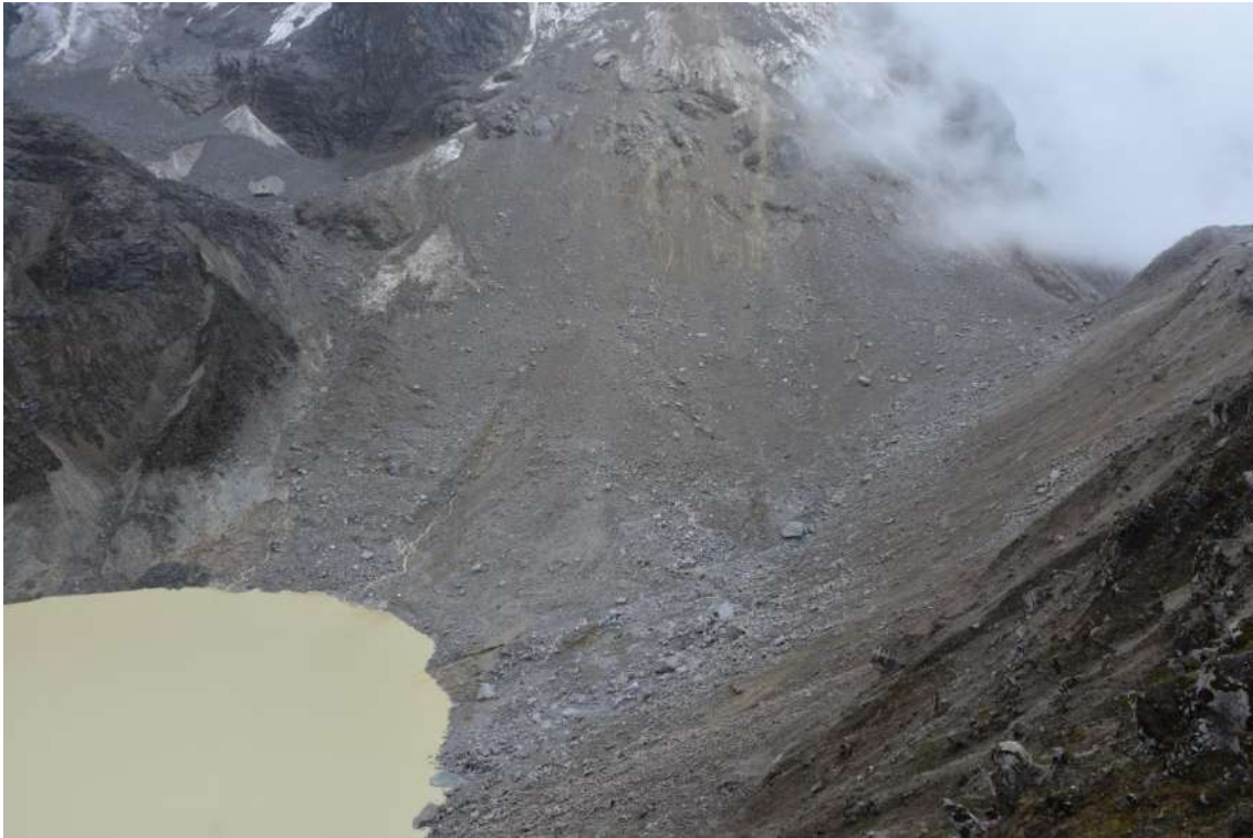
Figura 5. Vista de la zona posterior con presencia de abundante escombros, al momento de la inspección se observó caída de roca y hielo desde el frente glaciar. (Fuente: INAIGEM / O.Vilca)
