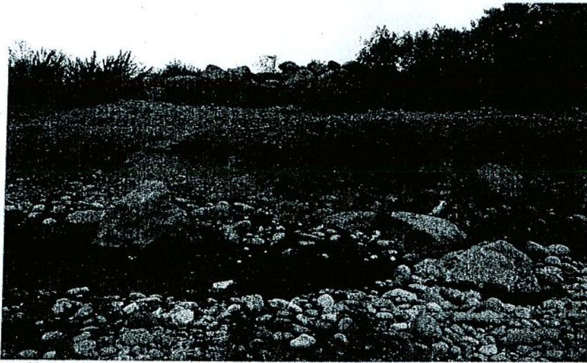
Foto: Margen derecha, socavación de dique arrimado con peligro de desborde Sector Roma Baja
