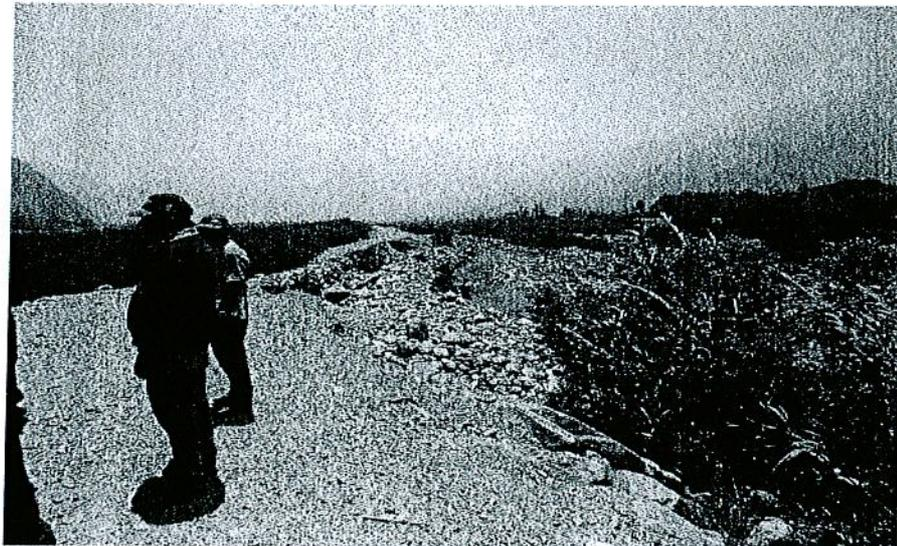
Foto : Margen derecha. Socavación de dique arrimado con peligro de desborde
