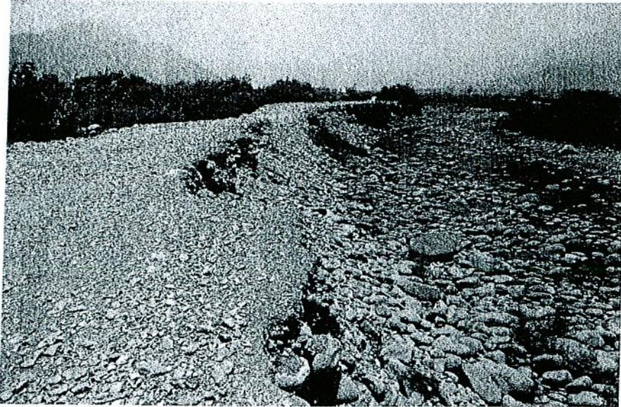
Foto: Margen derecha. Socavación de dique arrimado con peligro de desborde
