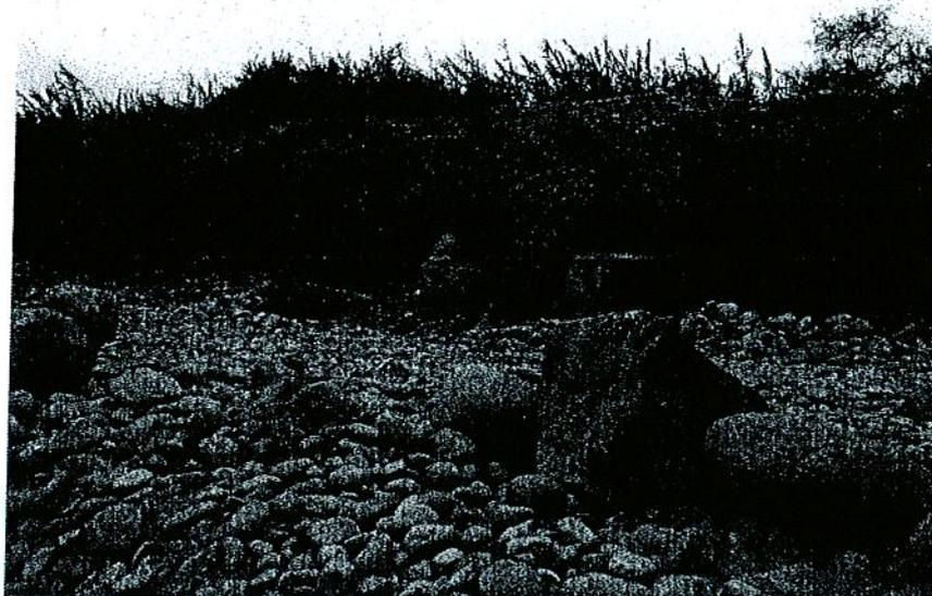
Foto : Margen Izquierda. Socavación de dique arrimado con peligro de desborde Sector Ribereños margen izquierda
