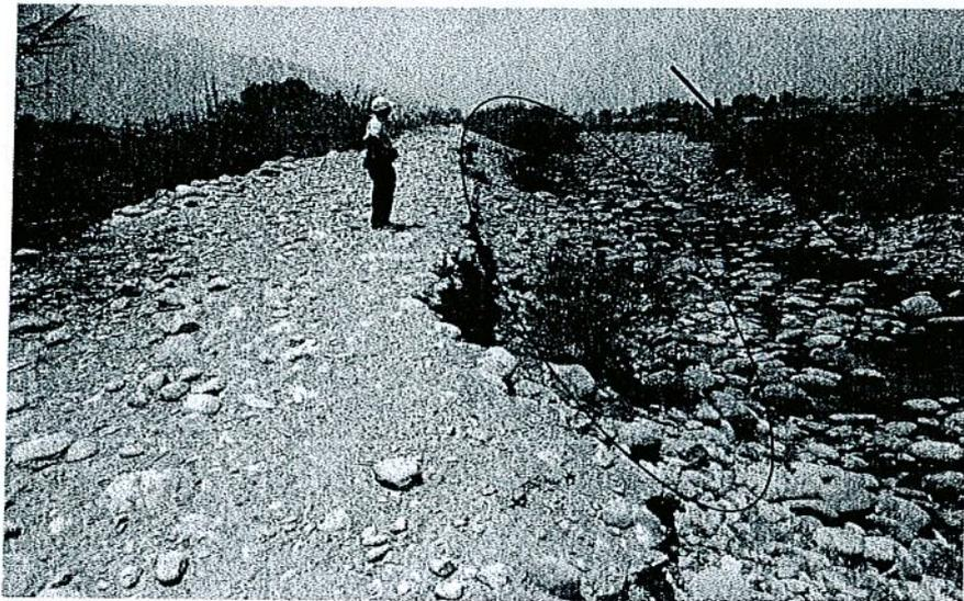
Foto : Margen derecha. Socavación de dique arrimado con peligro de desborde.
