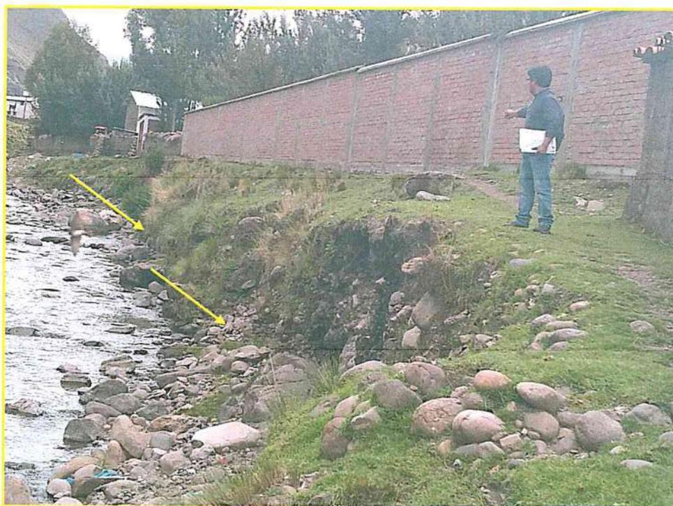
Fotografías 05; vista del lado posterior del centro de salud (MINSA) expuesto a la socavación por acción de la fuerza del agua.
