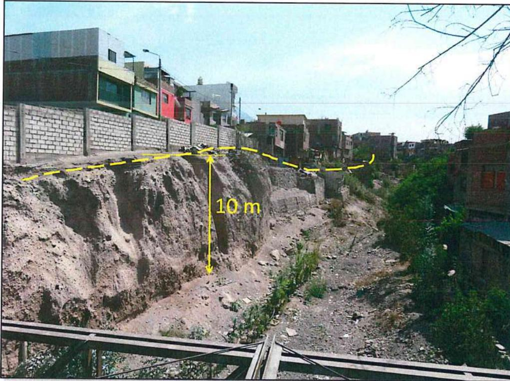
**Figura 12.** *Puente Progreso, se aprecia un depósito de flujo piroclástico de pómez y ceniza de 10 m de espesor que aflora en la quebrada San Lázaro.*
