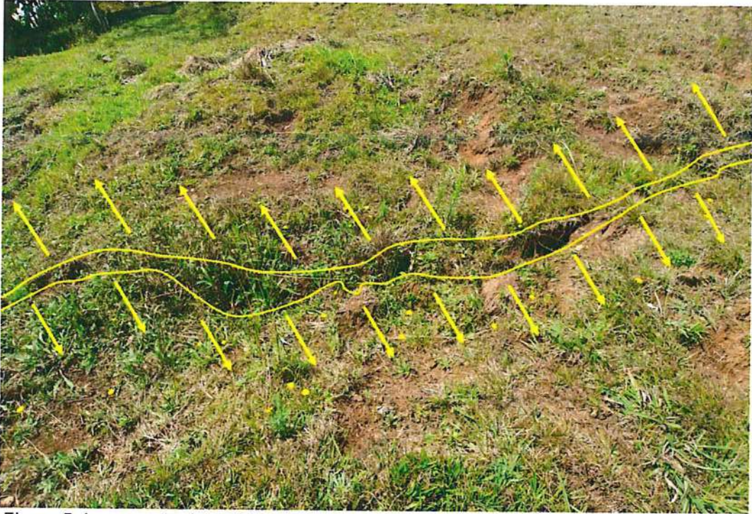
Figura 5: Incremento de agrietamientos en la ladera con dirección SE – NO.
