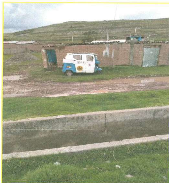
Fotografía 02; vista de las viviendas expuestas, construidas con material de adobe y techado de calamina, área EVAR.
