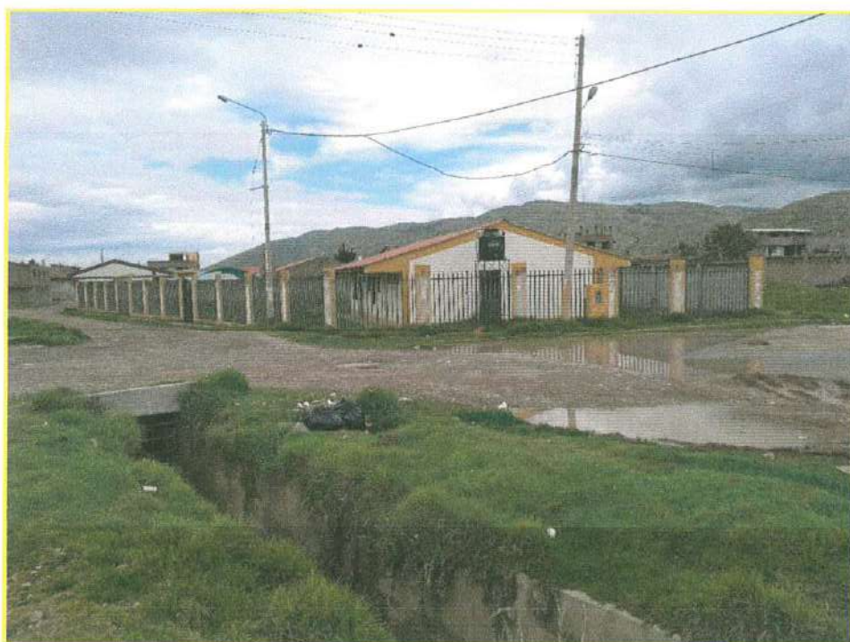
Fotografías 04; vista del centro de salud de la localidad de Sausa, expuesta al desborde del canal, área EVAR.
