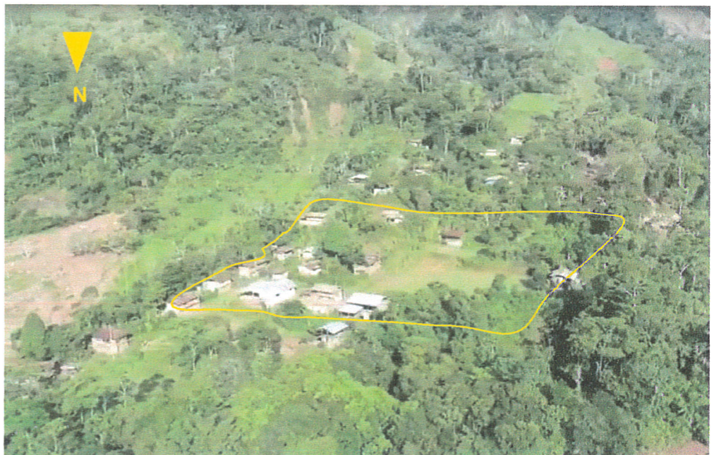
Foto 06: Terraza aluvional sobre la cual se asienta parte del área urbana de Nuevo Sinaí
