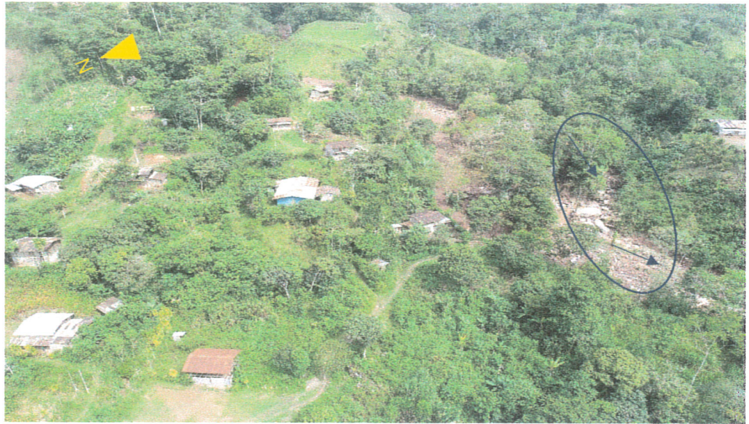
Foto 18: Quebrada ubicada a 200 m al sur del área de estudio, a través de la cual descienden flujos de detritos
