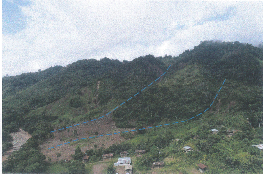
Foto 02: Cauce aluvial de las quebradas que se activaron por la ocurrencia de lluvias y ocasionaron flujos de lodo y detritos
