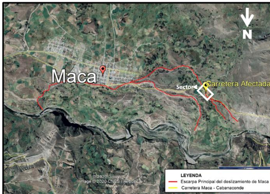
Figura 14. Muestra la escarpa principal del deslizamiento de Maca y tramo afectado de la carretera Maca – Cabanaconde.
