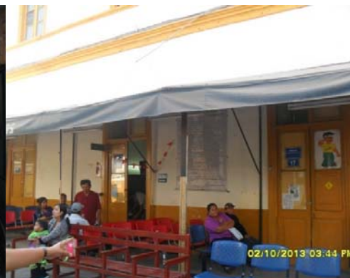
Foto 7. Sala de espera de Emergencia y Consultorios, patio exterior, construcción antigua de adobe.
