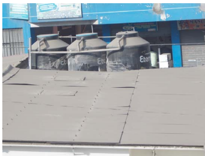
Foto47. Almacenamiento en tanques de PVC
