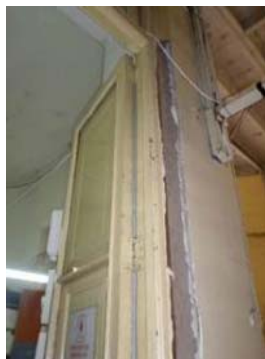
Foto 28 Desprendimiento del enlucido en sectores de las paredes y fisuras en los techos, determinando contaminación y afectando la bioseguridad de los materiales de esterilización.
