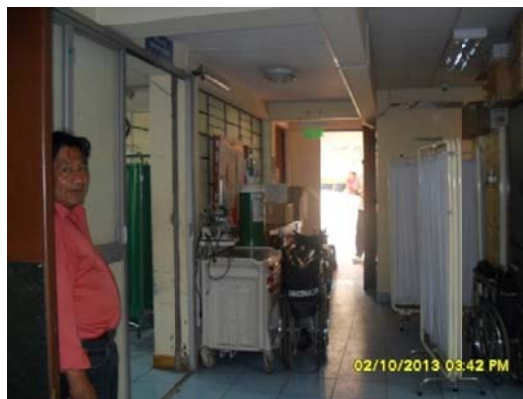
Foto 6. Pasillo hacia salida accesoria de Emergencia ocupado por equipos.
