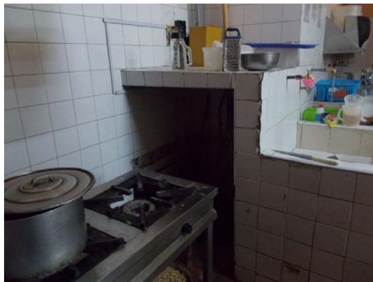
Foto45. Ambiente para bomba de cisterna principal.
