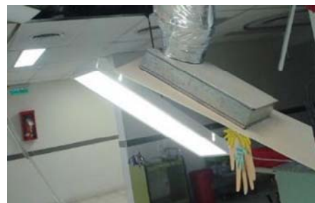
Fig.4.3 Falsos cielos rasos se desprenden por deficiencia en anclajes ante movimientos sísmicos
