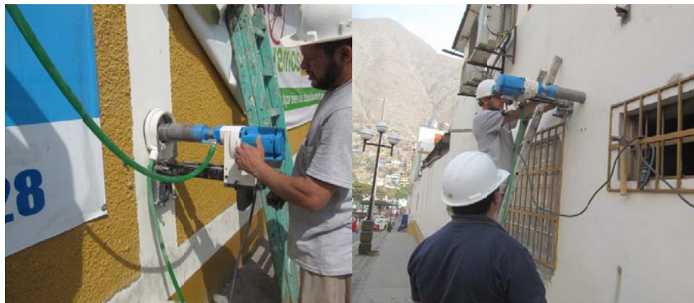
Foto 17. Extracción de núcleos de concreto
