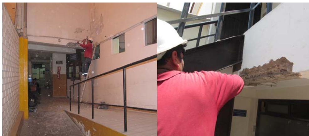
Foto 18. Extracción de núcleos de concreto
