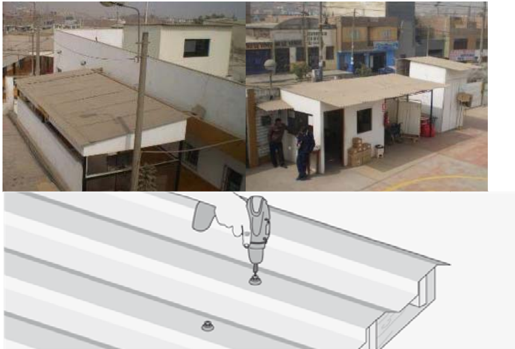
Fig.4.4 Techos ligeros que deben estar sujetos adecuadamente a fin evitar caídas o desprendimientos
