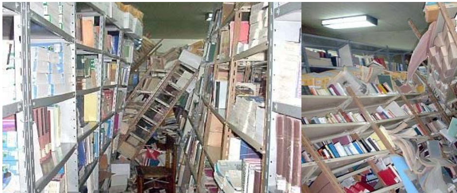
Fig.4.6 Caída y volcamientos de estanterías que no están adecuadamente sujetos.
