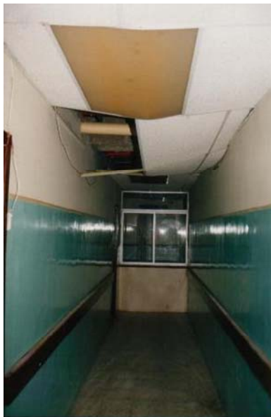
Fig.4.3 Falsos cielos rasos se desprenden por deficiencia en anclajes ante movimientos sísmicos
