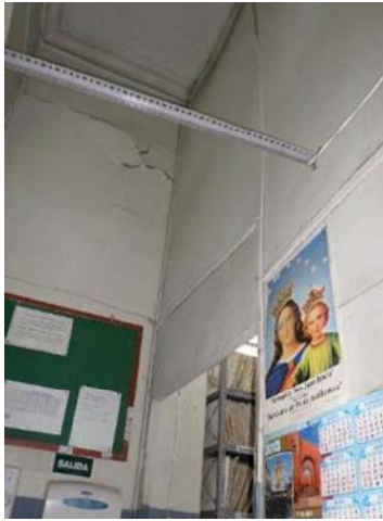
Foto 29 Rajaduras y fisuras en las paredes. Ambiente inseguro para los materiales y equipos de esterilización.
