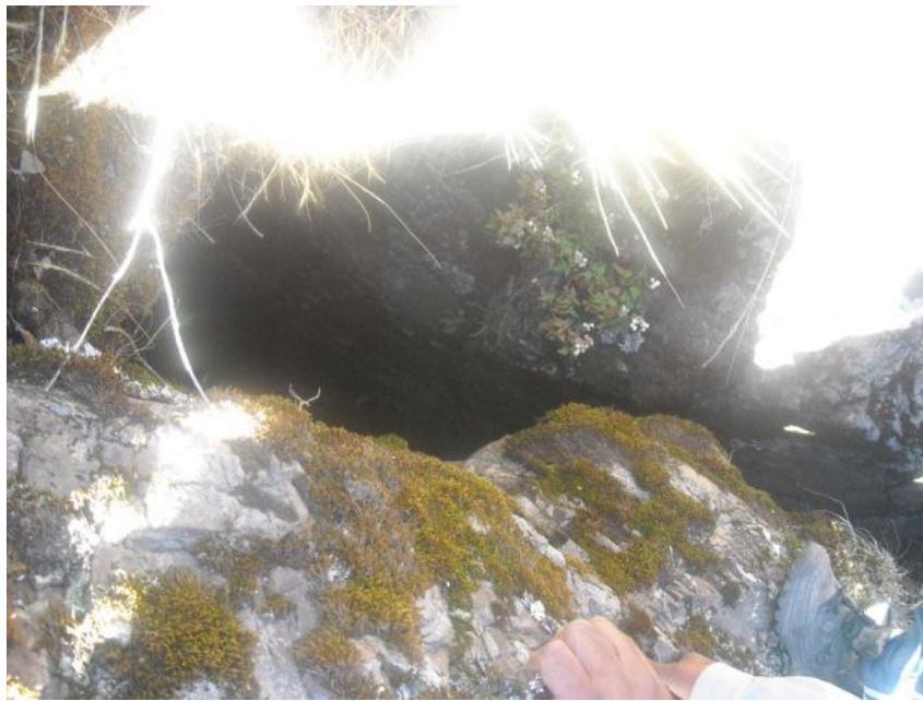
Fig. 5: Fractura de 20 cm del substrato rocoso, ubicado en la cabecera del deslizamiento.
