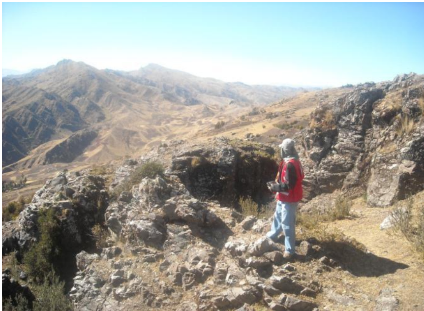
Fig. 4: Afloramiento rocoso fracturado ubicado en la cabecera del deslizamiento de K’asaccunca.
