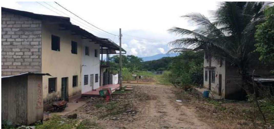
IMAGEN N°23.PASAJE PUMAHUASI, AFECTADO POR LAS INUNDACIONES
