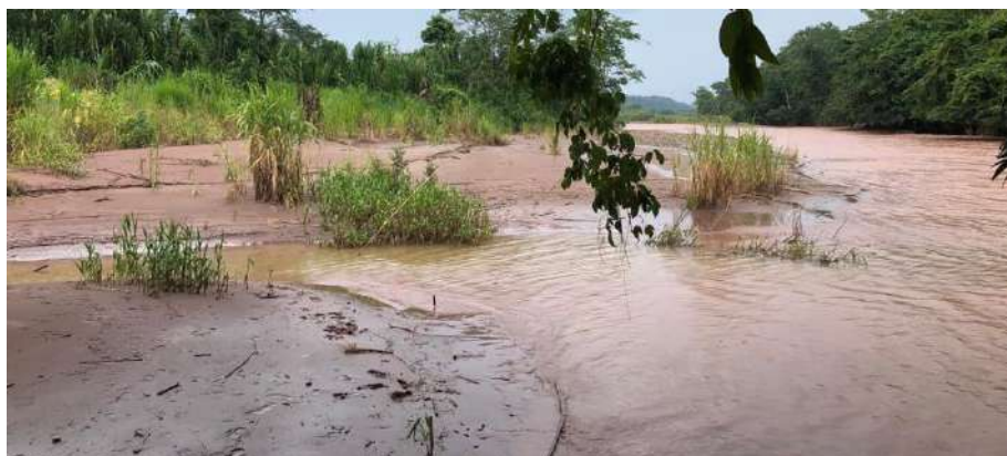
Foto 08.- Afectación de las orillas del Río Tulumayo, por arrase hidráulico, punto crítico a tener en cuenta, afectación de especies de flora del lugar. Todo perteneciente a la localidad de Pumaquasi
