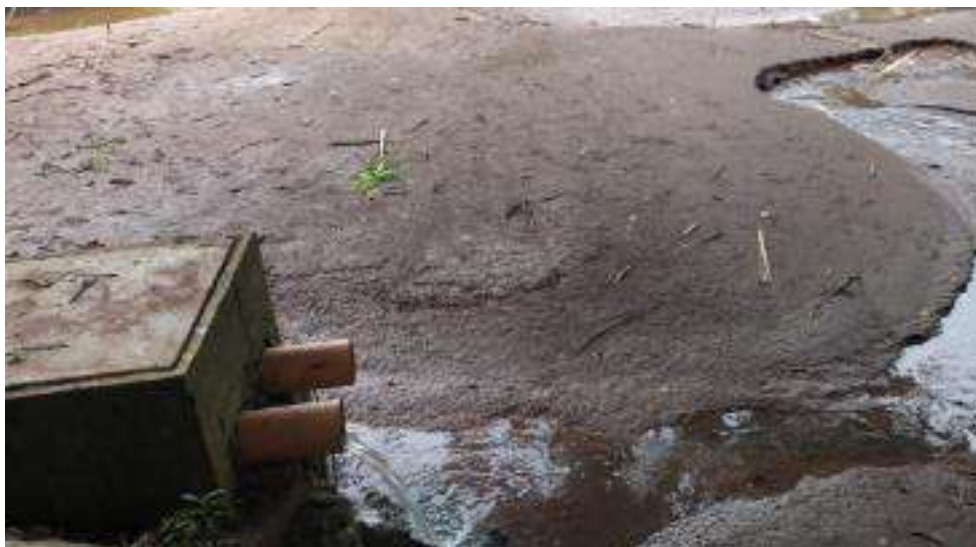
IMAGEN N°14. VISTA DEL EFLUENTE DEL PTAR A LA RIVERA DEL RÍO TULUMAYO
