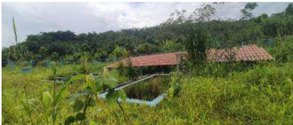
IMAGEN N°12. VISTA DE LA PLANTA DE TRATAMIENTO DE AGUAS RESIDUALES
