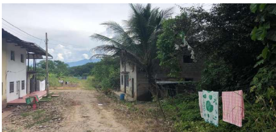
Foto 06.- Se aprecia las calles del sector residencial del Puma afectados por el desborde del río Tulumayo.
