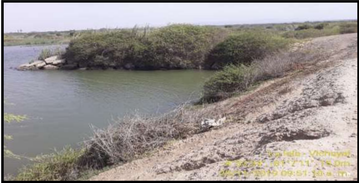
Imagen N° 07 : Dique afectado por crecidas fuertes del rio
