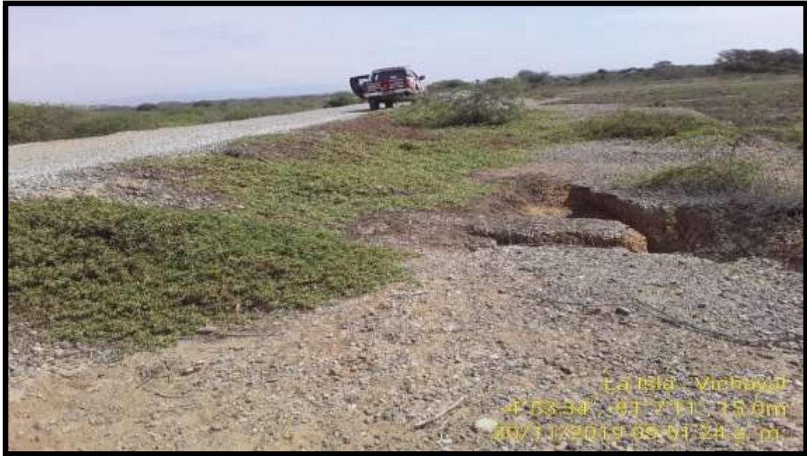
Imagen N° 08 : Dique Erosionado
