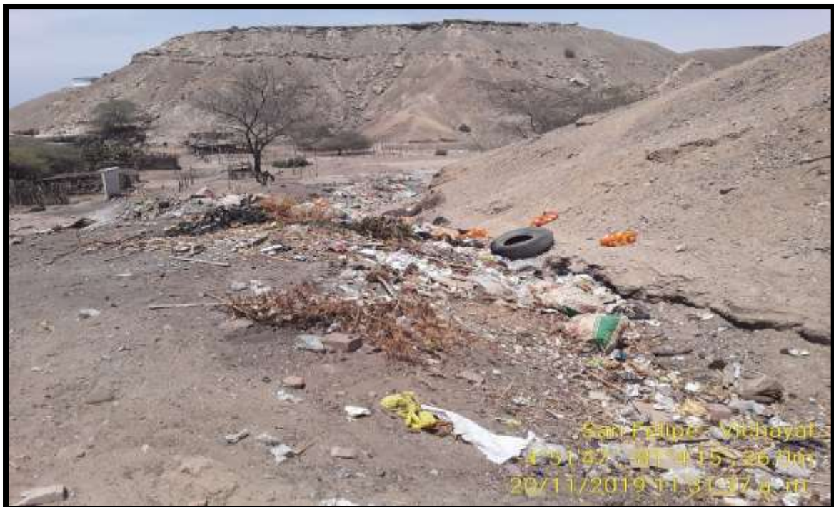
Imagen N° 30: Afluente de quebrada Piura colmatado de basura
