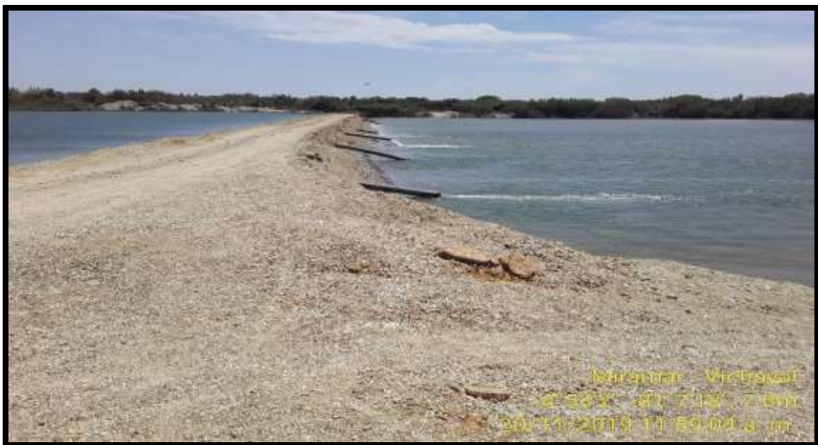
Imagen N° 36: Tapa sobre río, para almacenar agua para la agricultura
