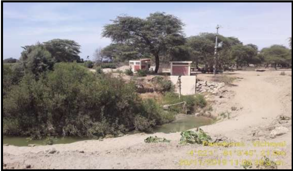
Imagen N° 18 : Canal Aductor paredones
