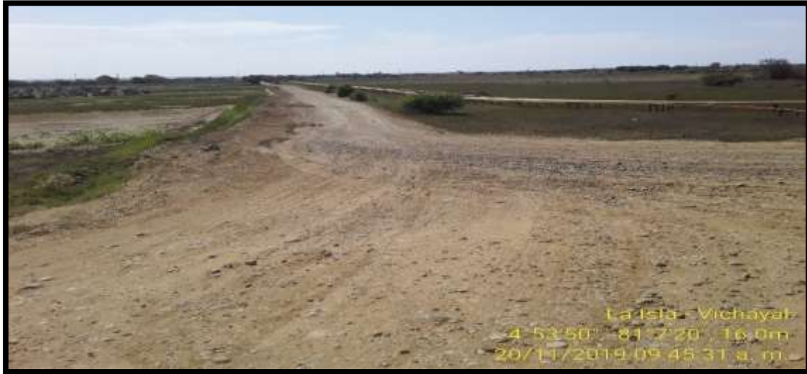
Imagen N°04: Dique Margen Izquierdo carretera hacia Isla San Lorenzo
