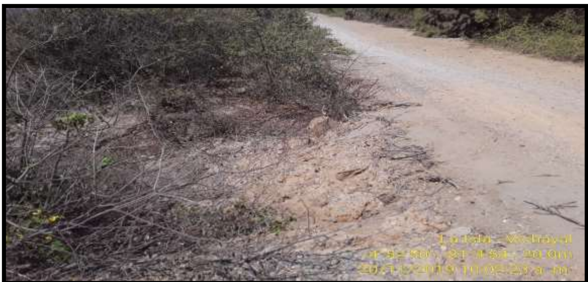
Imagen N° 10 : Corona de Dique margen Izquierdo
