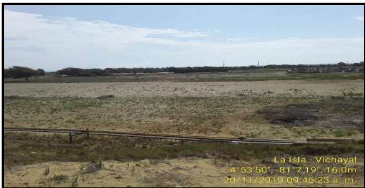
Imagen N°06: Tuberías de empresas de hidrocarburos que operan en la zona
