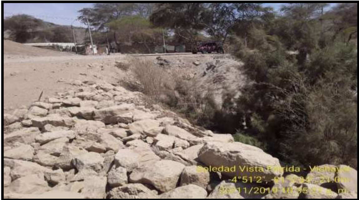
Imagen N° 13 : Espigón, centro poblado soledad margen derecha del río
