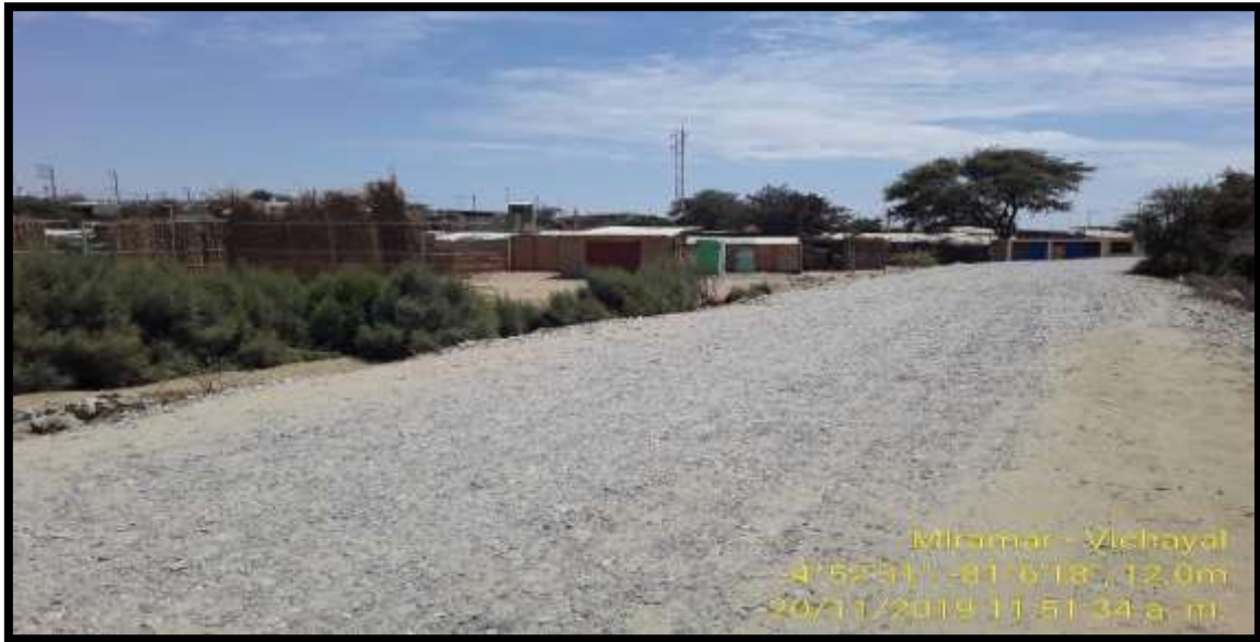
Imagen N° 35: Carretera hacia la bocana
