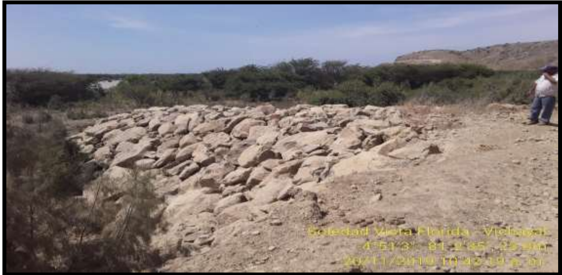
Imagen N° 15 : Espigón que protege la carretera de erosión por el río
