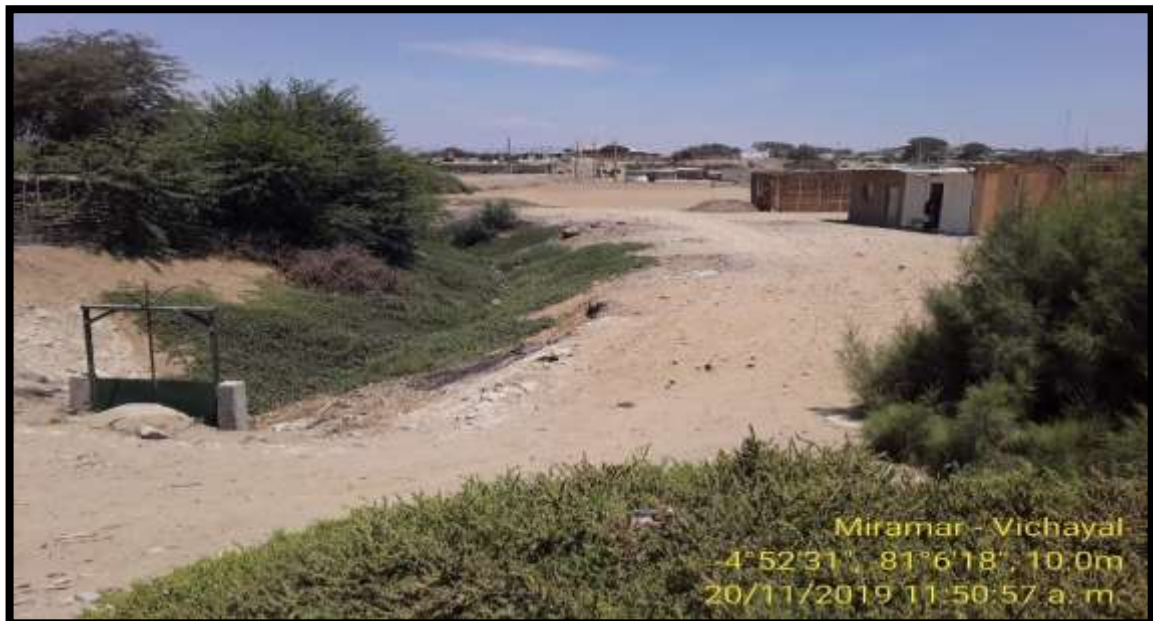
Imagen N° 33: Compuerta de quebrada centro poblado miramar
