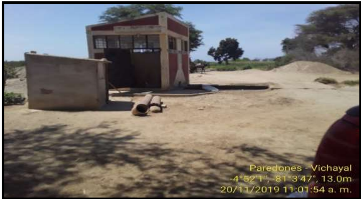
Imagen N° 19 : Caseta de bombeo paredones
