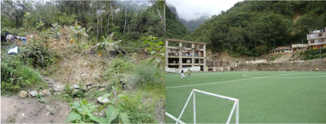
Ilustración 23. Deslizamiento originario por la acción antrópica
