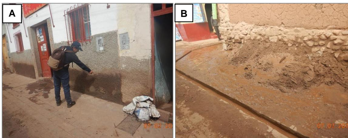
**Figura 8.** Vista del nivel alcanzado por el flujo de lodo en las paredes de viviendas de la Calle Grau.
