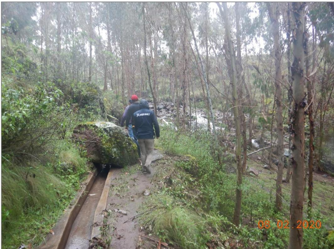
**Fotografía 5.** Caída de rocas sobre el canal de riego para el sector Viacha.
