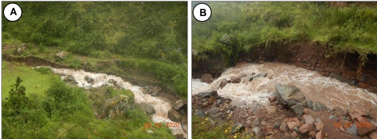
**Figura 13.** A) Vista del muro de sostenimiento inca colapsado en la margen izquierda del río Kitamayo por el flujo de detritos. B) Muro de sostenimiento afectado en la margen derecha.
