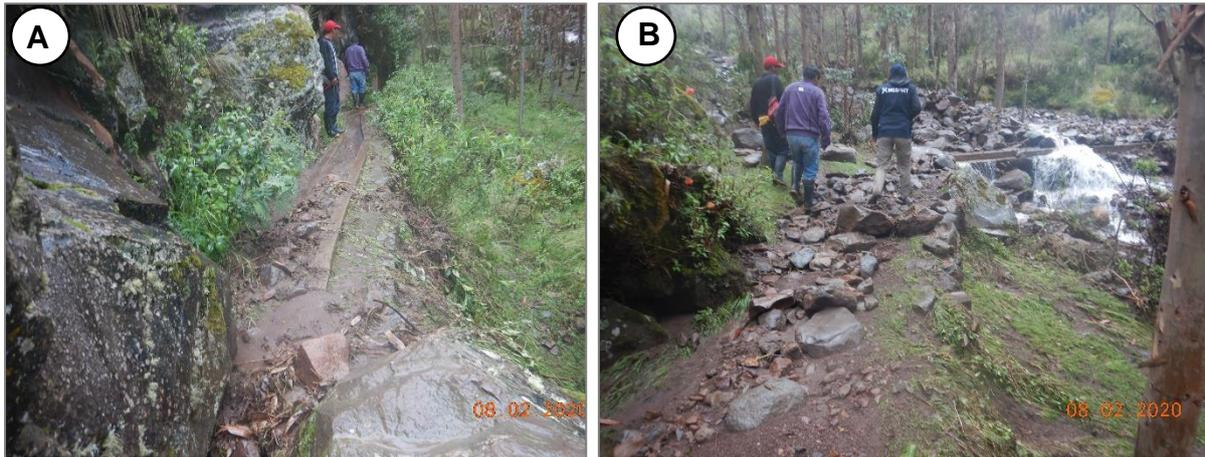
**Figura 11 A,B.** Vista del canal de riego obstruido por el material acarreado por el flujo de detritos (huaico).
