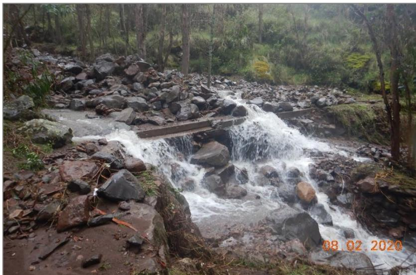
**Fotografía 4.** Canal de riego de la comunidad de Viacha afectado por el flujo de detritos (huaico).
