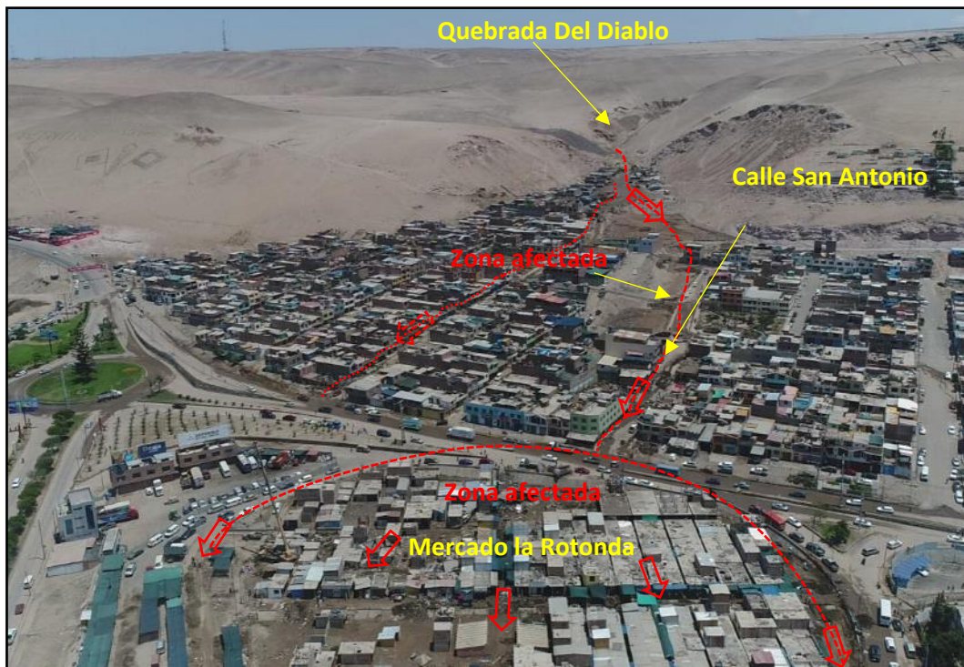
Figura 15. Quebrada Del Diablo fotografía aérea de la zona afectada.
