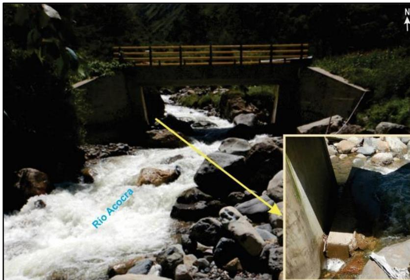
**Figura 15.** Vista donde se observa afectaciones, en donde colapsó parte del estribo izquierdo del puente, que es otro de los accesos al centro poblado de Acocra.
