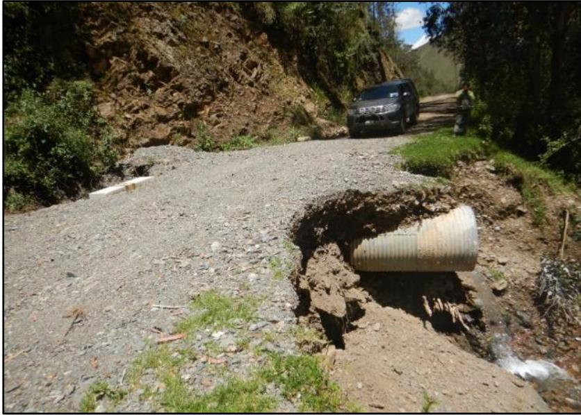
**Fotografía 4.** Vista donde se observa erosión de la plataforma de la trocha carrozable, afectando 12 m longitudinales de la vía entre Acocra – Pucara Pata.
