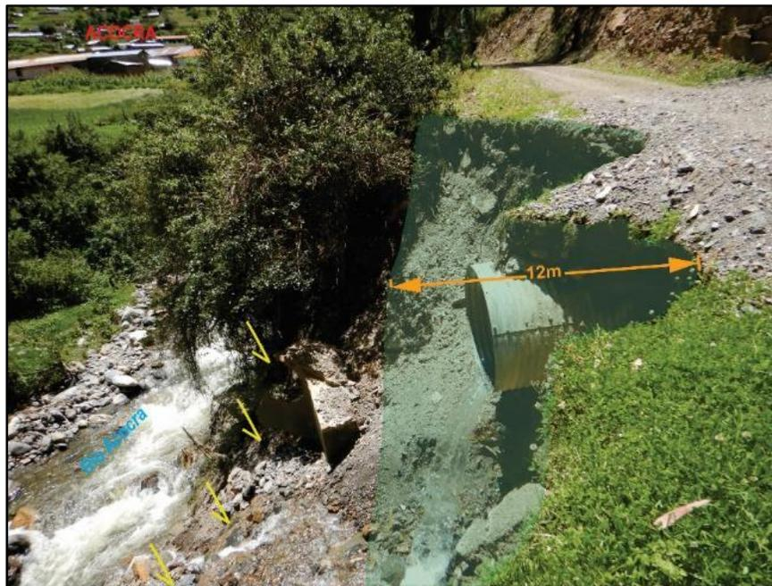
Figura 14. Se muestra alcantarilla de concreto destruido, ubicado en la margen izquierda del río Acocra.
