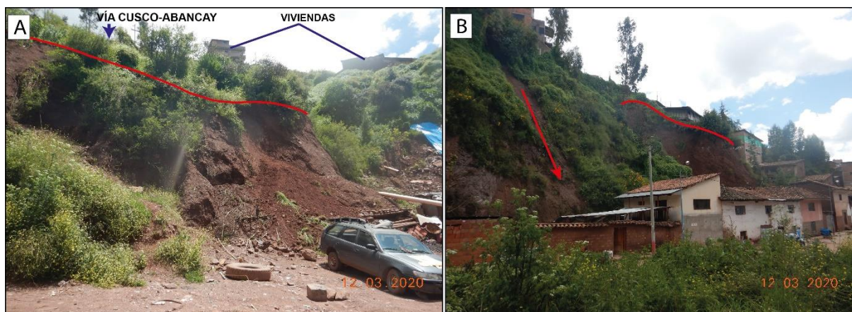
Figura 10. A) Vista de un derrumbe activo, B) Vista de viviendas asentadas al pie del talud
