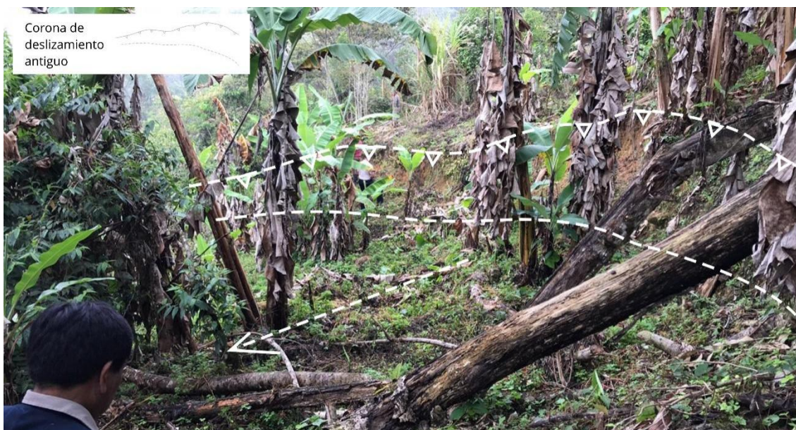
Figura 6. Corona de deslizamiento que afecta torre de alta tensión en San Emilio. Se observa el escarpe erosionado, evidencia de desplazamientos anteriores.
