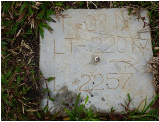
Fotografía 2. Se observa la placa de la torre de alta tensión
