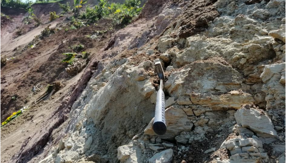
Fotografía 1: Limo arcillitas y areniscas de grano fino con elevado grado de fracturamiento y alteración, fácilmente deleznales.
