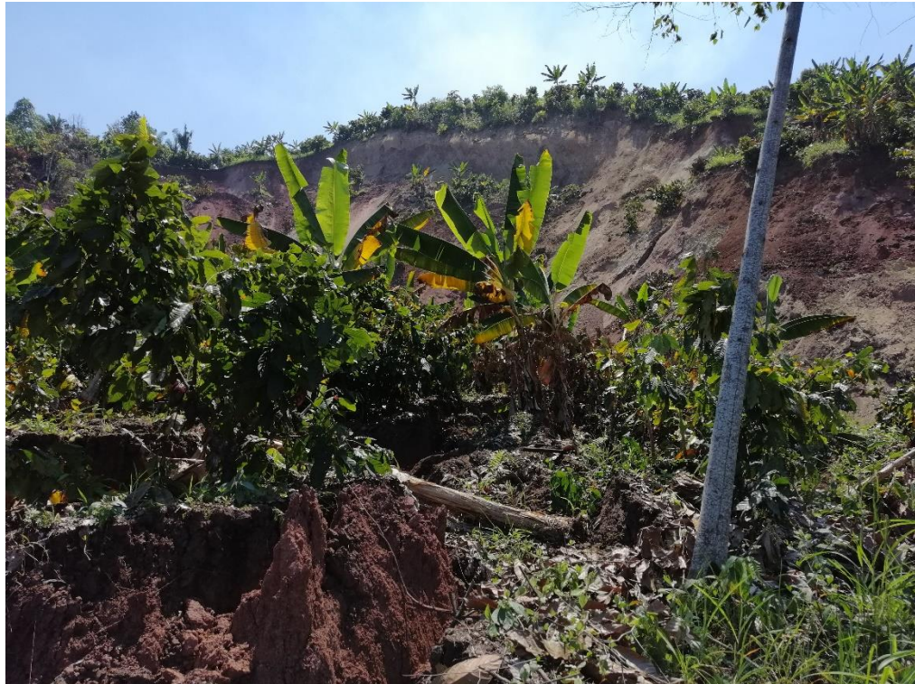
Fotografía 6: Vista ladera arriba de la escarpa principal del deslizamiento.
