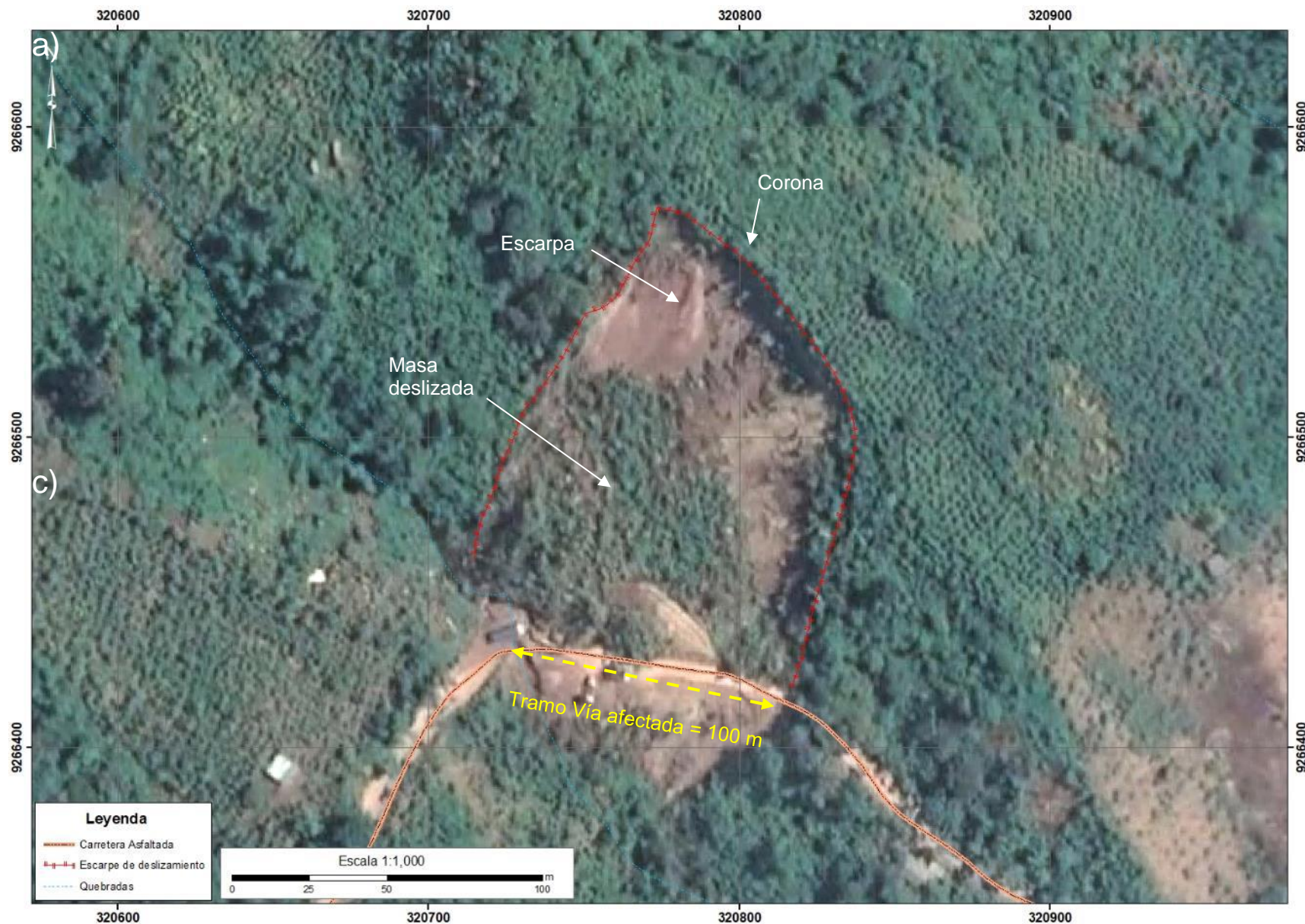
Figura 6: Deslizamiento ocurrido en el km 38+700 carretera Cuñumbuque – Zapatero – San José de Sisa.
