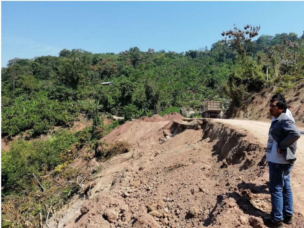
Fotografía 4: Parte baja del deslizamiento que cubrió la totalidad de la vía.
