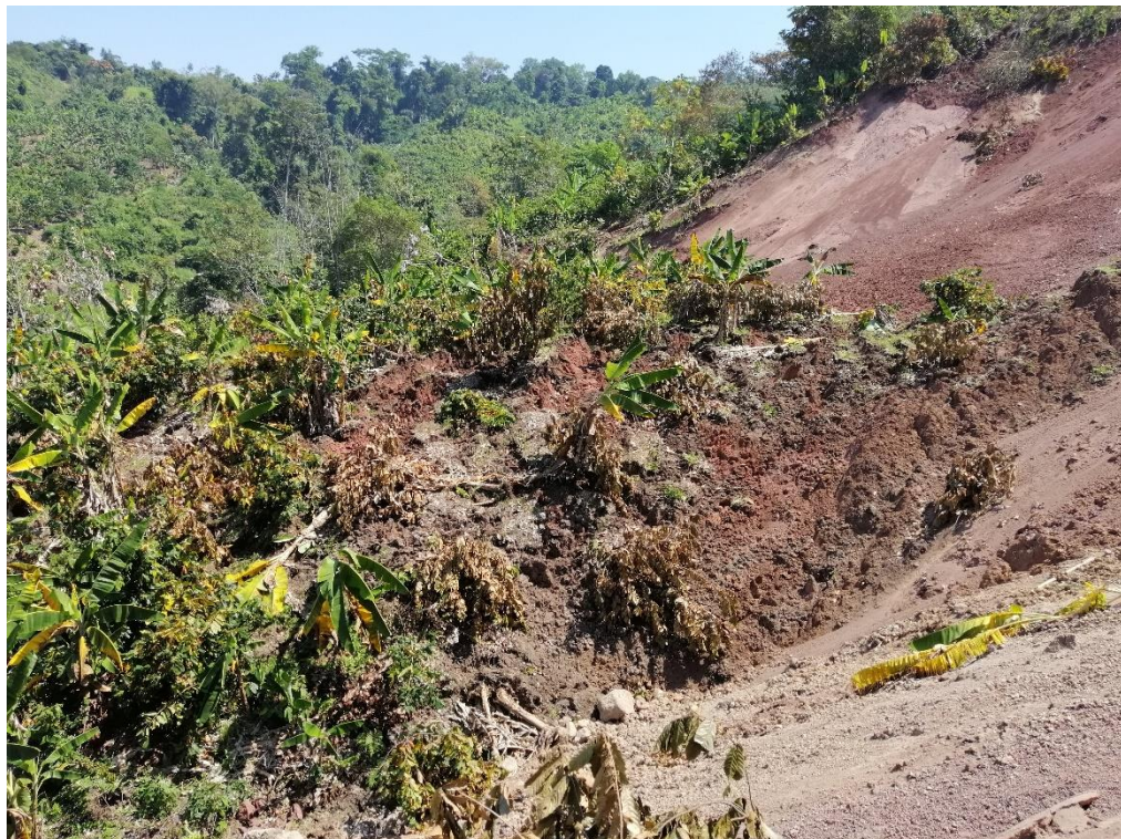
Fotografía 7: Masa deslizada totalmente deformada. Está conformada por material arcilloso.
