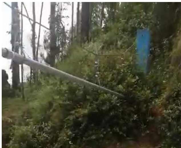
Foto N°13. Tuberías – pase aéreo que pasa por el cauce de quebrada
