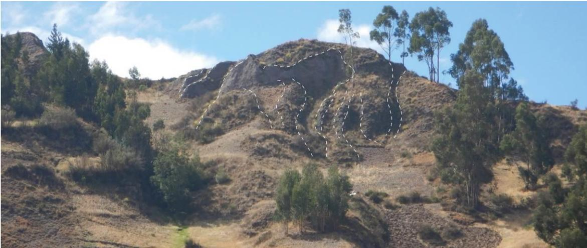
**Figura 7.** Vista donde se observa material morrénico, próximos a la zona de evaluada en donde se aprecia su composición detrítica (bloques angulosos en una matriz limoarcillosa intercalada con arenas), con procesos de carcavamiento (líneas blancas entrecortadas)
