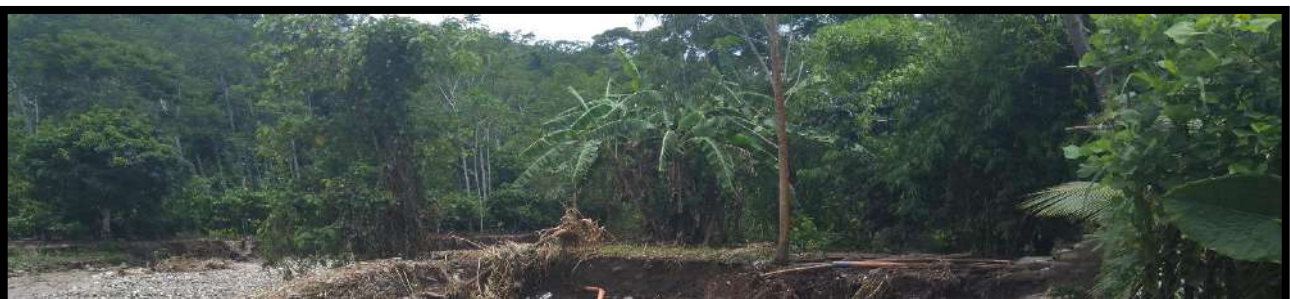
DESBORDE DEL RIO CATUTE AFECTANDO LA ZONA URBANA
