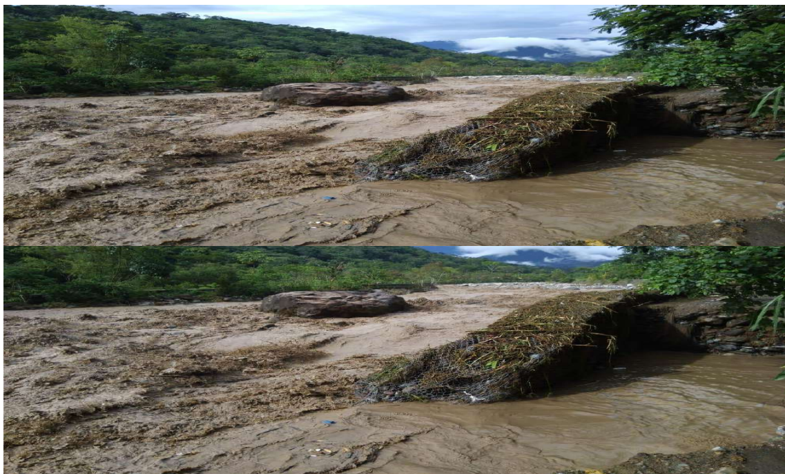
Ilustración 12. Desborde del Río Santa Rosa, destruyendo a los gaviones de protección viviendas urbanas
