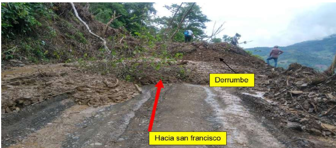
Ilustración 10. Deslizamientos en la vía distrital Santa Rosa – San Francisco, Intransitable
