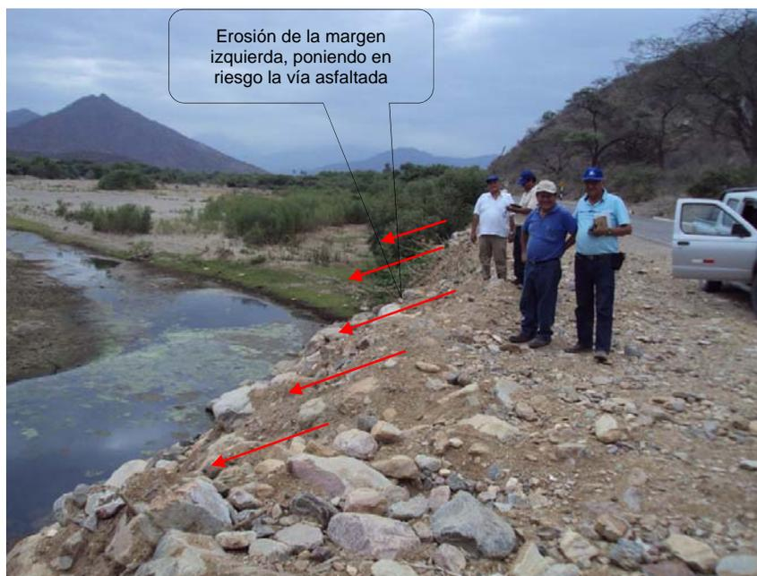
Figura 43. Erosión de la vía asfaltada
