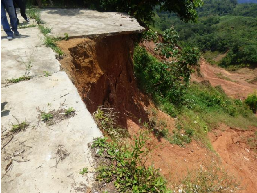
Fotografía 7. Viviendas destruidas e inhabitables ubicadas en la cabecera de las cárcavas. Vista al oeste
