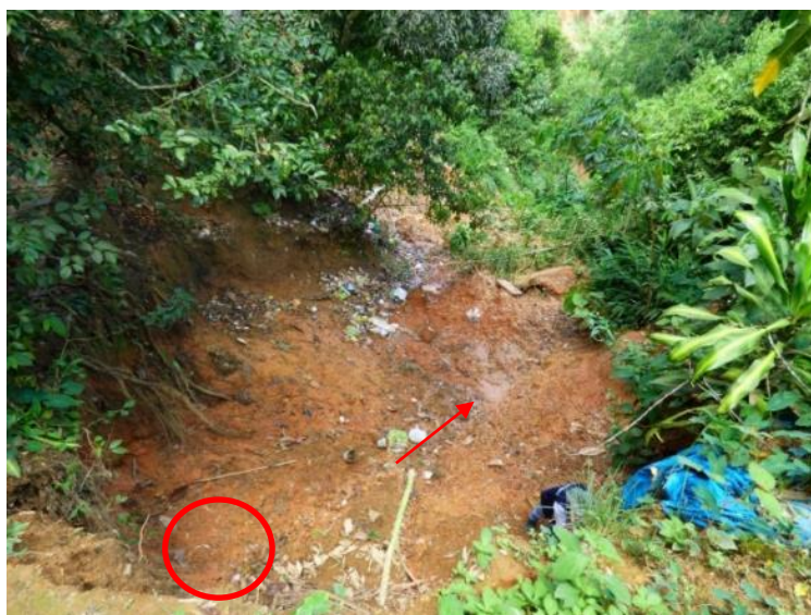
Figura 16. Se identificaron manantiales que saturan los suelos ubicados dentro de las cárcavas. Vista al noroeste.
