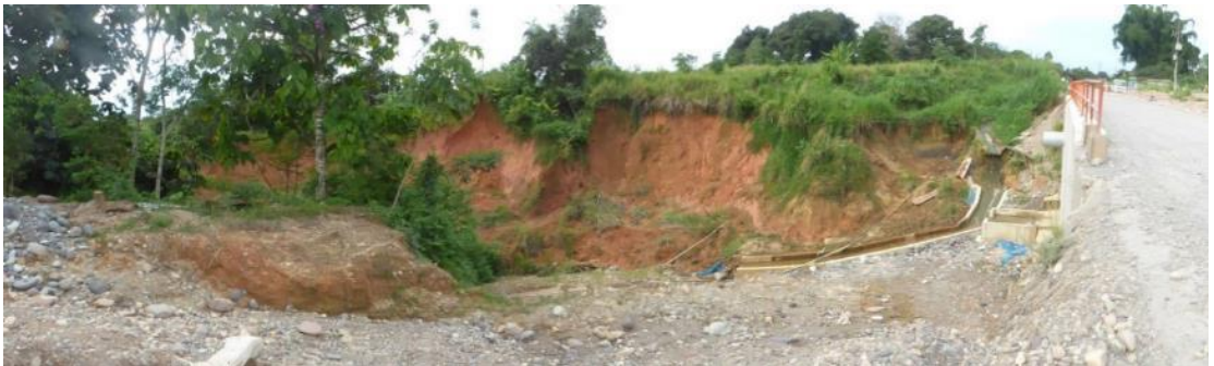
Fotografía 4. Cárcavas identificadas al oeste del caserío Antonio Raymondi Las Vegas, cuya ocurrencia causada por las precipitaciones pluviales de febrero de este año, han afectado la carretera Federico Basadre.
