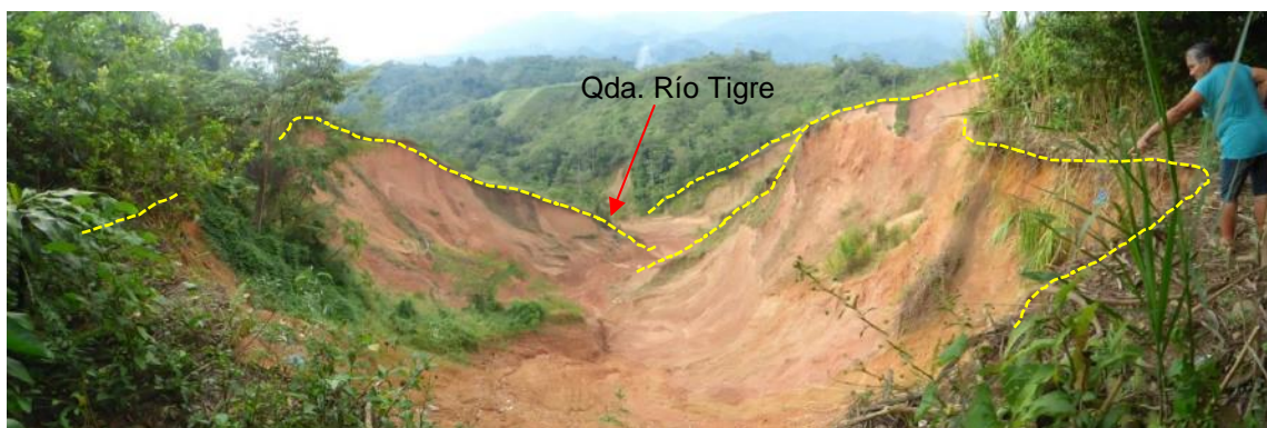
Figura 13. Vista panorámica hacia el noroeste de los procesos de erosión de laderas a manera de cárcavas. Desde el 2005 hasta la actualidad se puede observar el avance retrogresivo de estos procesos, lo cual ha generado deslizamientos (escarpas delimitadas por líneas amarillas discontinuas), derrumbes y flujos de lodo hacia la quebrada Río Tigre. Mientras que en febrero de este año las viviendas del caserío Antonio Raymondi Las Vegas fueron afectadas.
