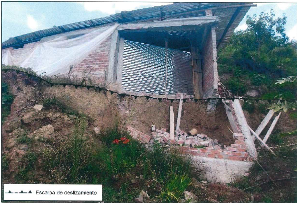
Figura 12: Colapso parcial de vivienda construida sobre la corona del deslizamiento. Nótese la escarpa principal que atraviesa la edificación.
