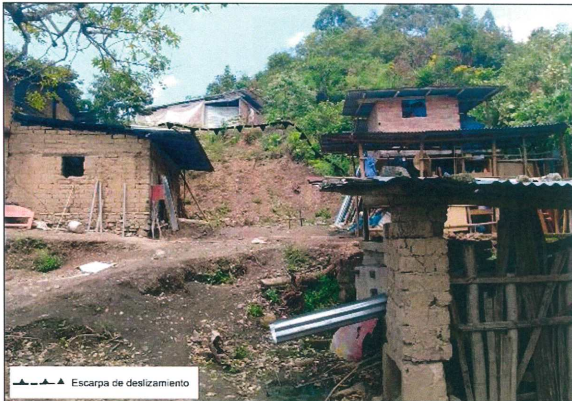
Figura 13: Viviendas en peligro muy alto de ser afectadas por el deslizamiento. Adviértase en el fondo la escarpa principal del deslizamiento.
