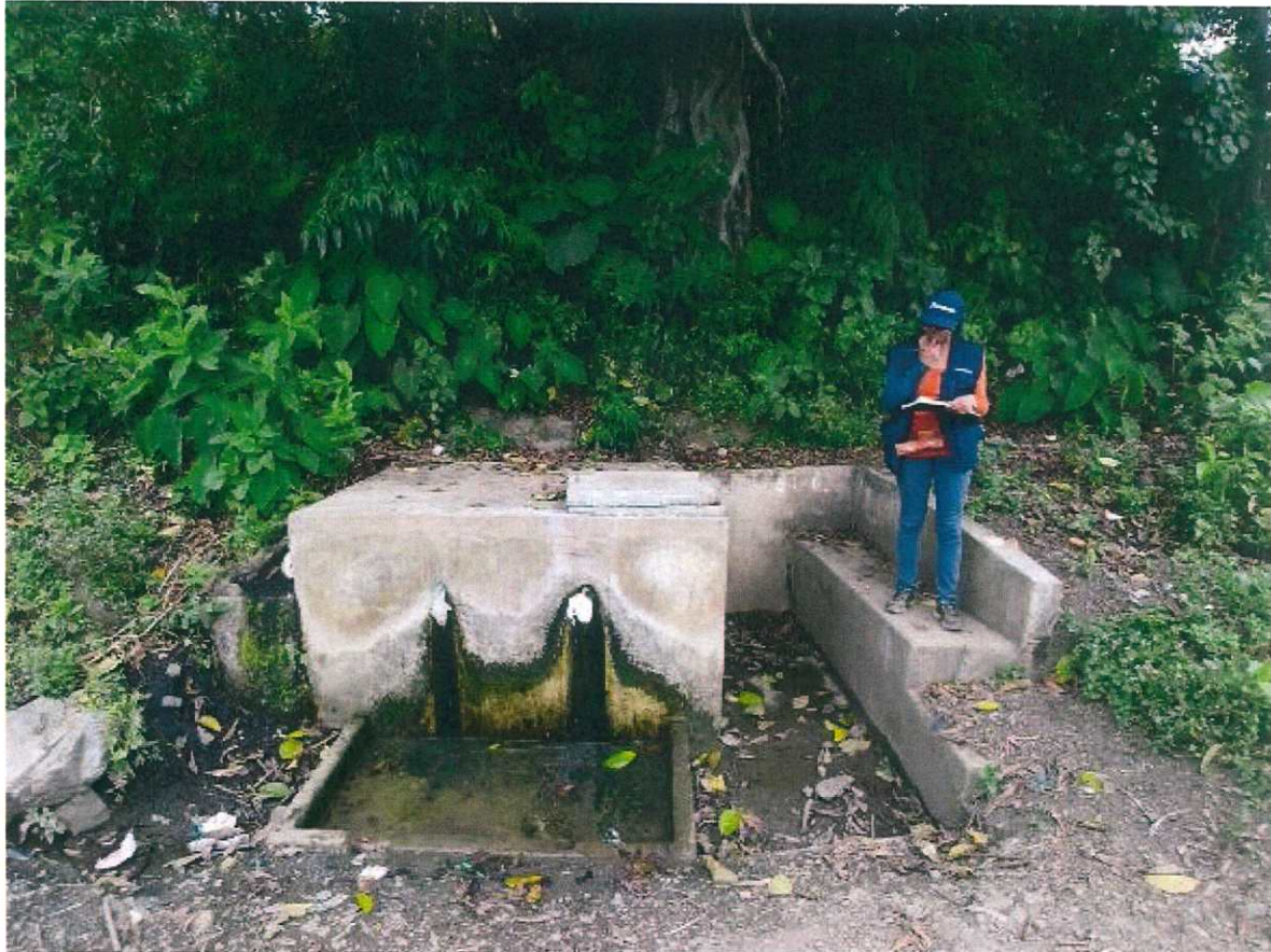
Figura 14: Reservorio de agua ubicada hacia aguas debajo de los pozos negros que emplea la población del caserío la Tranca.
