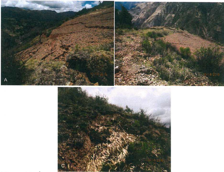
Figura 14. Área donde se observa la mayor cantidad de grietas originadas durante el año 2019, dejando el lugar inestable y que ocasione un deslizamiento de magnitud mayor
