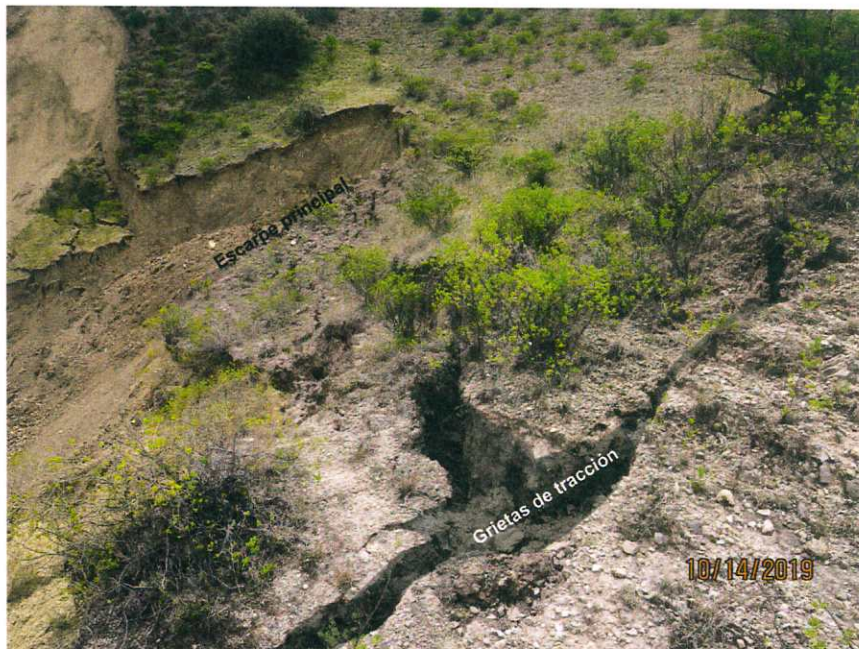
Figura 15. Vista del escarpe principal que presenta una longitud de 60 m con salto vertical que varía de 2 a 3 m también presenta grietas de tracción con longitud que varía de 2 a 10m con una apertura de 0.6m y una profundidad de 1m
