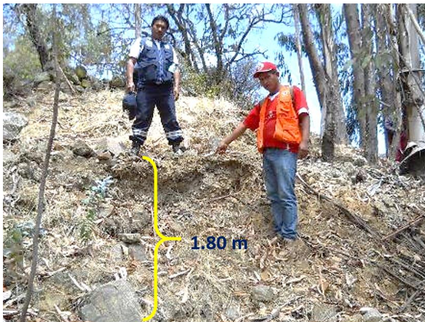
Figura N° 16.- Sector Chacapa, parte superior. Zona de deslizamiento en un área con pendiente promedio de 36°. En la vista se observa un “salto” del terreno de 1.80 m.
