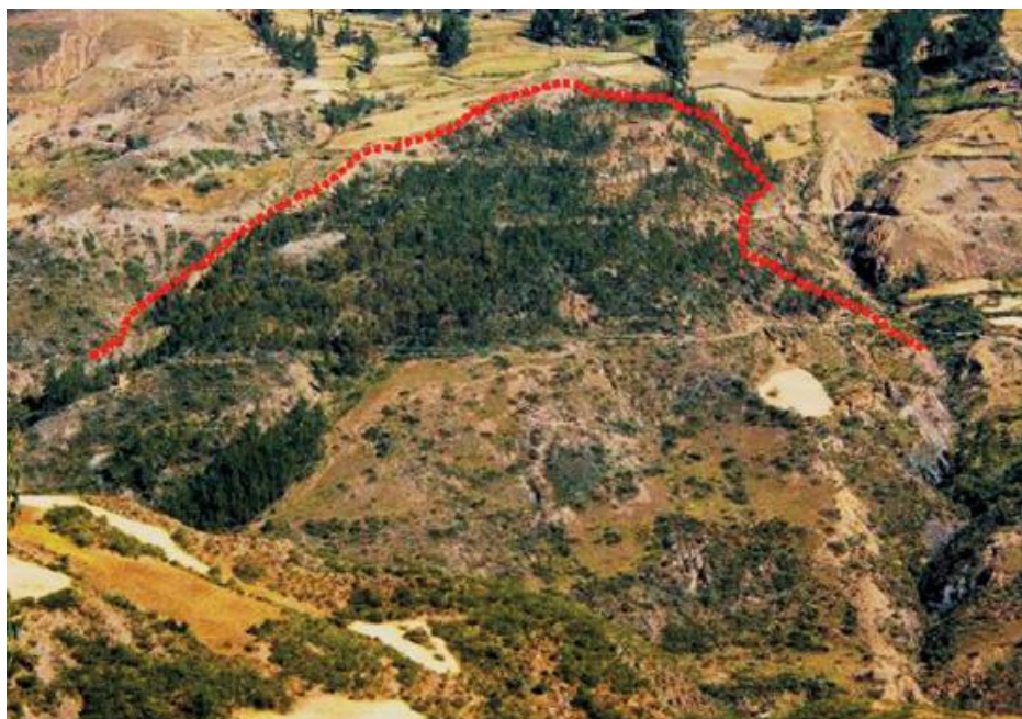
Figura N° 27.- Forestación de laderas para estabilización en cuerpo de deslizamiento.
