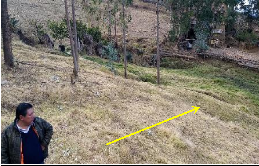
Figura N° 19.- Sector Yauya, parte inferior del distrito de Yauya, margen izquierda de la quebrada Maribamba, se observa el deslizamiento del terreno superficial con "saltos" de 0.25 m a 0.60 m en promedio, a manera de "escalones", en una pendiente superior a 25°. Los troncos de los árboles presentan una ligera inclinación en contra de la pendiente.
