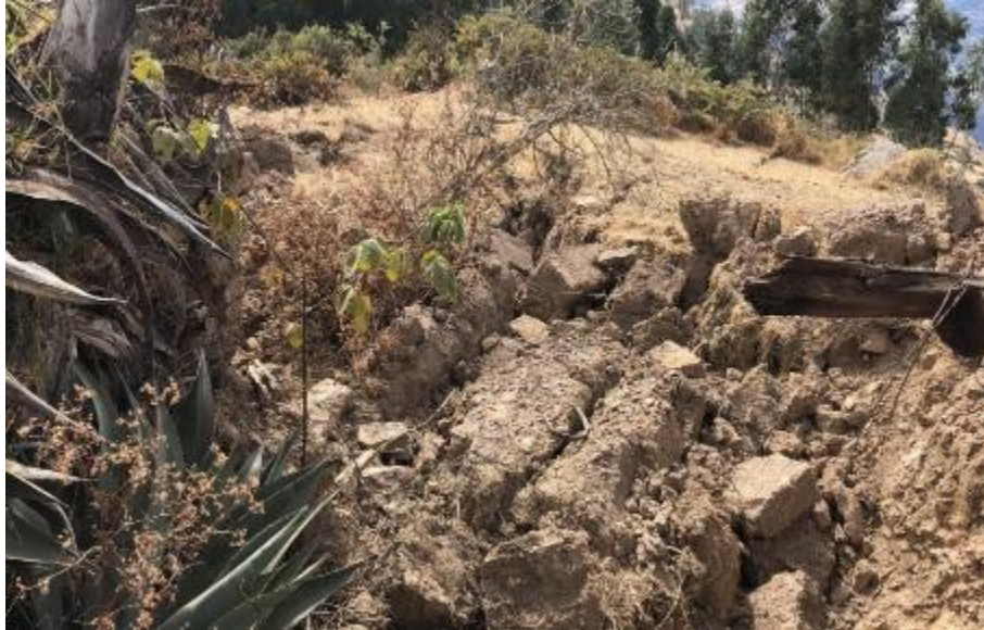
Fotografía N° 14.- Substrato rocoso de mala calidad. Secuencia de areniscas con intensa meteorización y fuerte fracturamiento, generando suelos residuales (arenolimosos oxidados). La meteorización es principalmente de tipo fisicoquímica.
