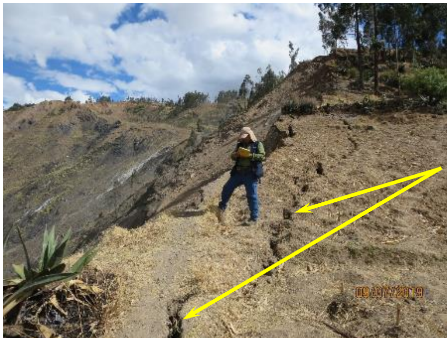
Figura N° 23.- Parte superior de la corona de deslizamiento, se observan grietas de tracción paralelas al borde de la escarpa con aperturas de 15 cm – 30 cm en promedio, por donde se infiltra el agua de lluvia, contribuyendo a desestabilizar la ladera.
