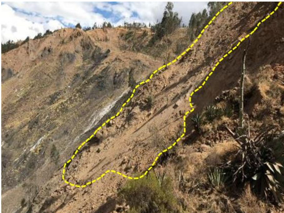
Figura N° 05.- En la vista se observa un depósito de materiales coluvio-deluviales en la margen izquierda del cuerpo del deslizamiento, en la parte superior del valle, en el sector Chacapa. La pendiente promedio está en el rango de 40° - 45°.
