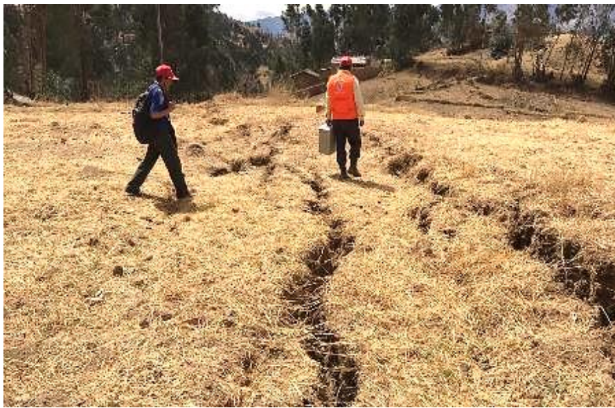
Fotografía N° 08.- Sector Chacapa, área inestable afectada por grietas subparalelas, con longitudes en superficie que varían de 2 m a 10 m, aperturas de 10 cm a 30 cm, y profundidades que alcanzan los 3 m.
