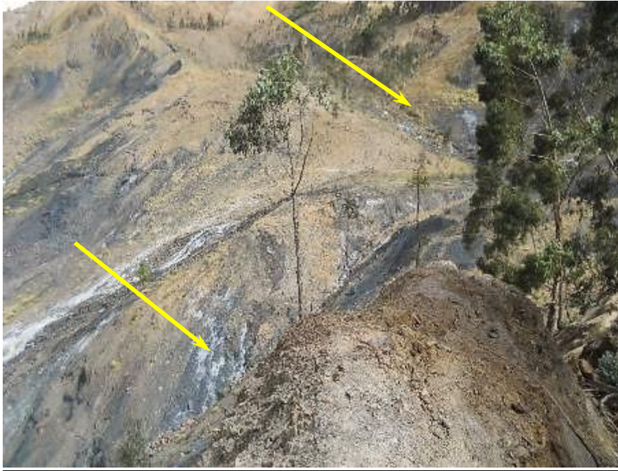
Fotografía N° 09.- Sector Chacapa, área inestable. Vista panorámica del deslizamiento desde su margen izquierda, se observa un deslizamiento rotacional, flujo de detritos (movimiento complejo), con caída permanente de rocas en una pendiente superior a 50°.
