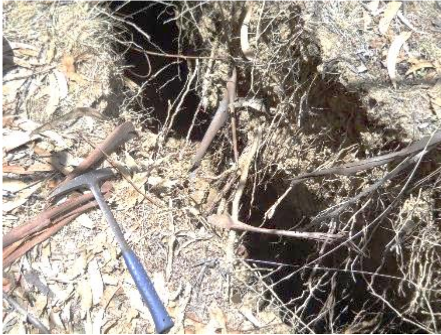
Fotografía N° 06.- Sector Chacapa, grieta con apertura de 45 cm, profundidad de 2.80 m, longitud promedio visible en superficie de 75 m – 80 m, rumbo N30°W. Los pobladores de Chacapa manifestaron que en mayo de 2019 era una fisura y en agosto de 2019 evolucionó a una grieta.
