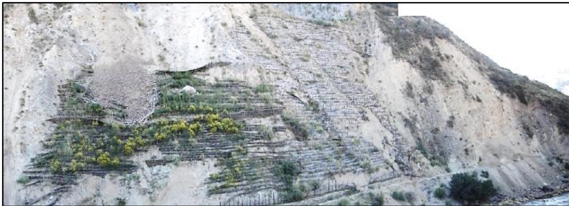
Fotografía N° 16.- Ejemplo de evacuación de aguas superficiales y control de erosión en cárcavas, mediante trinchos escalonados.
