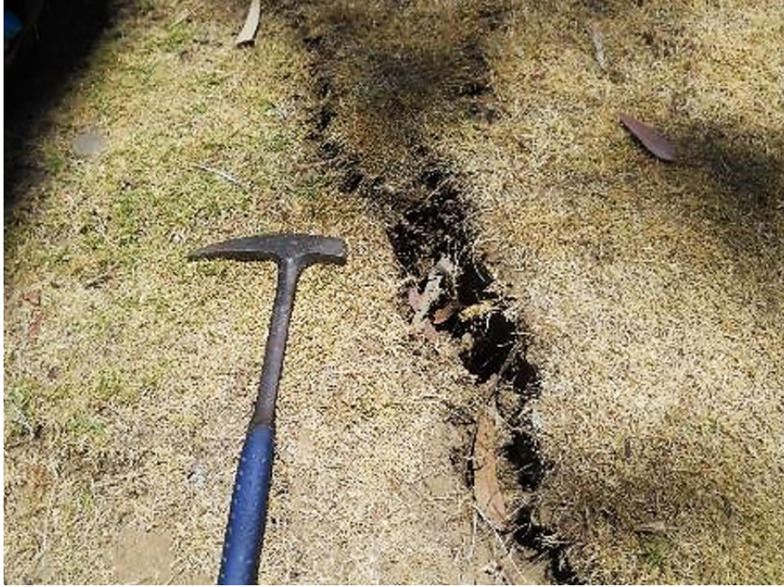
Fotografía N° 05.- Sector Chacapa, área denominada Surco Rumi; grietas con aperturas de 15 cm – 25 cm, profundidad promedio de 0.70 m, longitud visible en superficie de 10 m, rumbo: N30°W.
