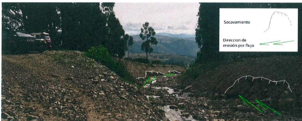
Figura 13. Canalización de la quebrada Llamac – Totora. Se observa un estrechamiento de cauce y socavamiento generado por flujos recientes.
