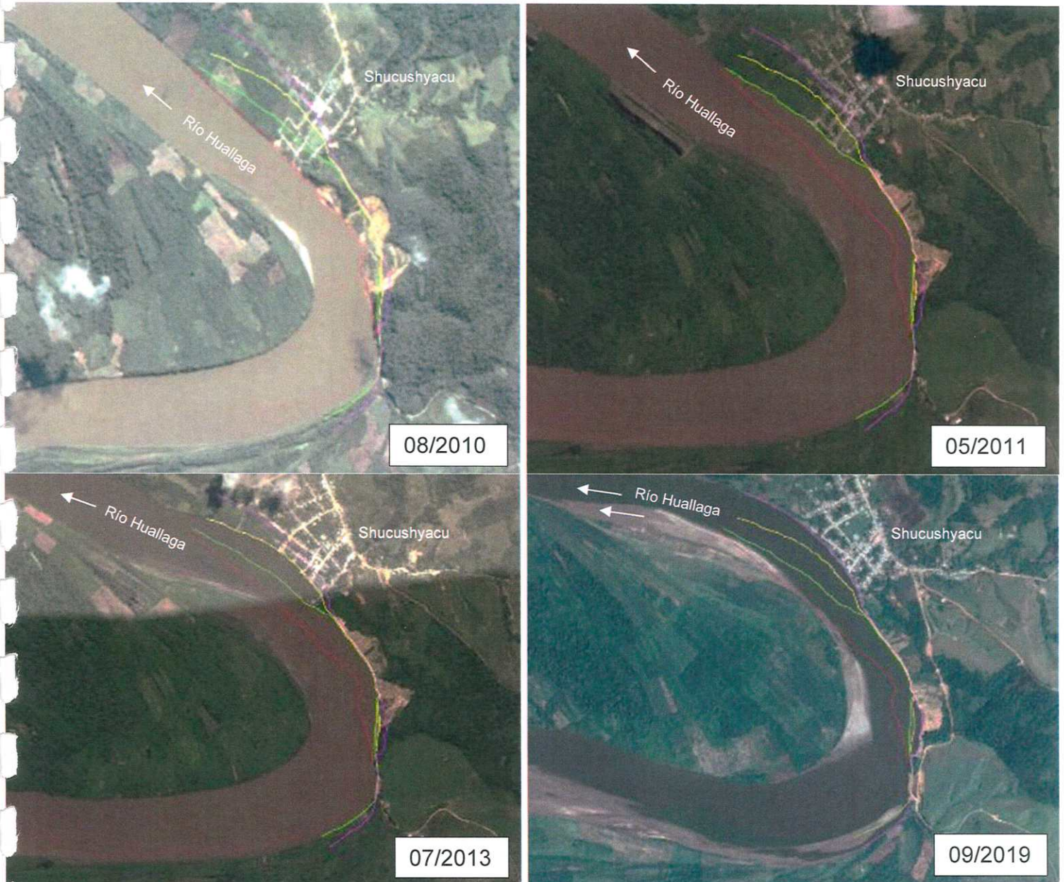
Figura 8: Evolución del proceso de erosión fluvial generado por el río Huallaga en la ribera derecha donde se ubica el área urbana de la localidad de Shucushyacu.
