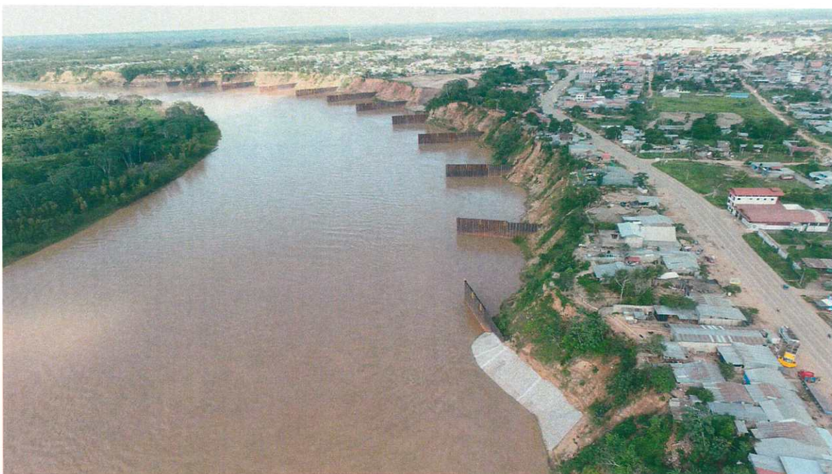
Fotografía 14: Defensa ribereña La Pastora, ubicada en el río Madre de Dios en la ciudad de Puerto Maldonado. Fuente IIRSA SUR, 2016.
