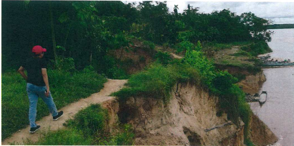
Fotografía 5: Vista del hacia aguas arriba, del extremo sur de la zona urbana de Shucushyacu. Se observa erosión fluvial en suelos arenosos y areno limosos.
