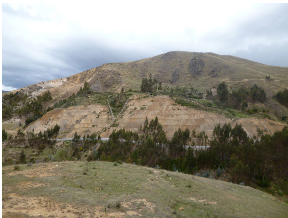
Fotografía 8.54 Vista panorámica del deslizamiento de Huayllopampa a la altura del Km. 50 de la carretera Interoceánica.
