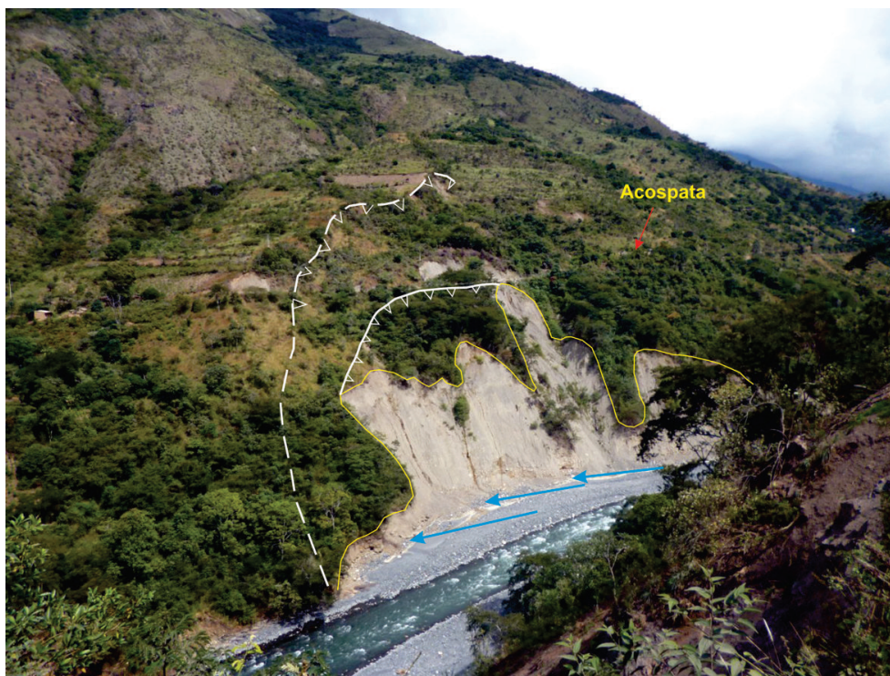
Figura 8.13 Erosión en el pie del deslizamiento de Acospata.
