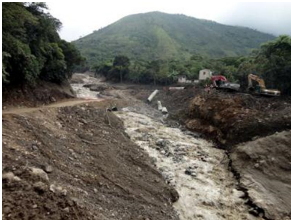
Fotografía 8.23 Quebrada Yuracmayo, vista tomada el 14 de febrero, se observa la magnitud del evento, socavó y erosionó su cauce.
