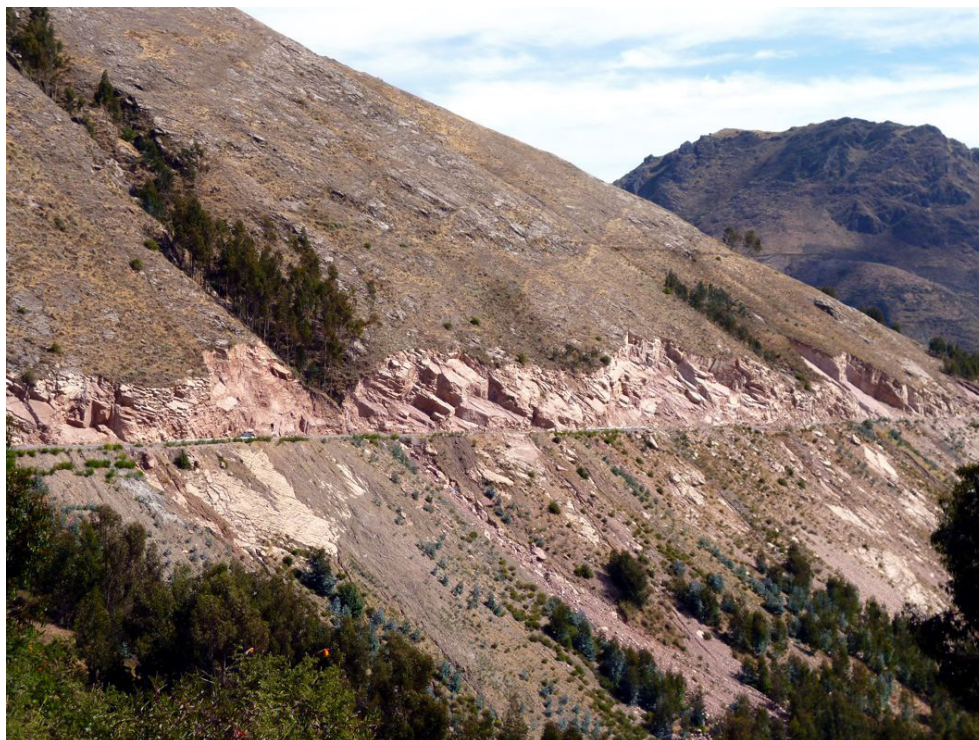
Fotografía 8.91 Secuencia de la Formación Huancané que se inclina a favor de la pendiente de la ladera, caída de bloques por falla planar entre el Km. 12+100 al 16+100 de la carretera a Huancarane.
