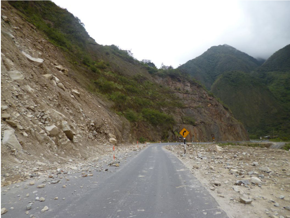
Fotografía 8.43 Detritos caídos obstaculizan el tránsito por la carretera Interoceánica en el Km. 148+500.
