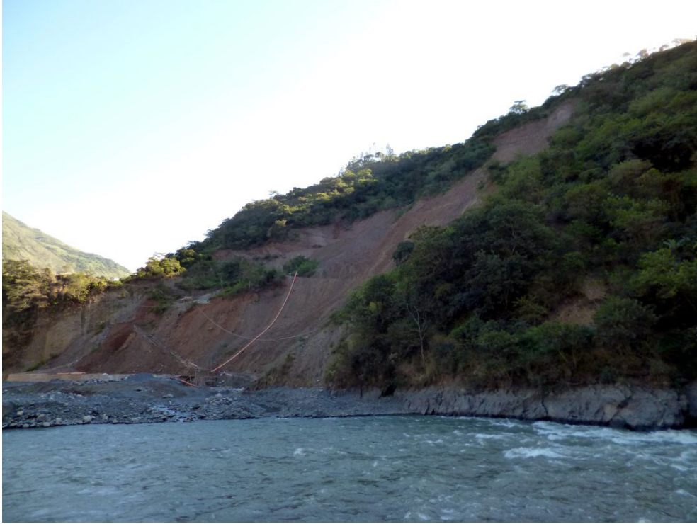
Fotografía 8.14 Deslizamiento en el sector de Naranjal, produce asentamientos en la plataforma de la carretera que conduce a Vilcabamba y al poblado de Socospata; el río Vilcabamba produce erosión en el pie del deslizamiento. Se construye muro de concreto para controlar la erosión.
