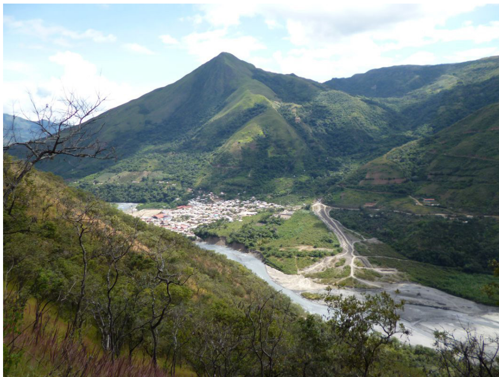
Fotografía 8.7 Huaico de la quebrada Quellomayoc. Puede afectar el poblado de Quellouno, asentado en el abanico proluvial.
