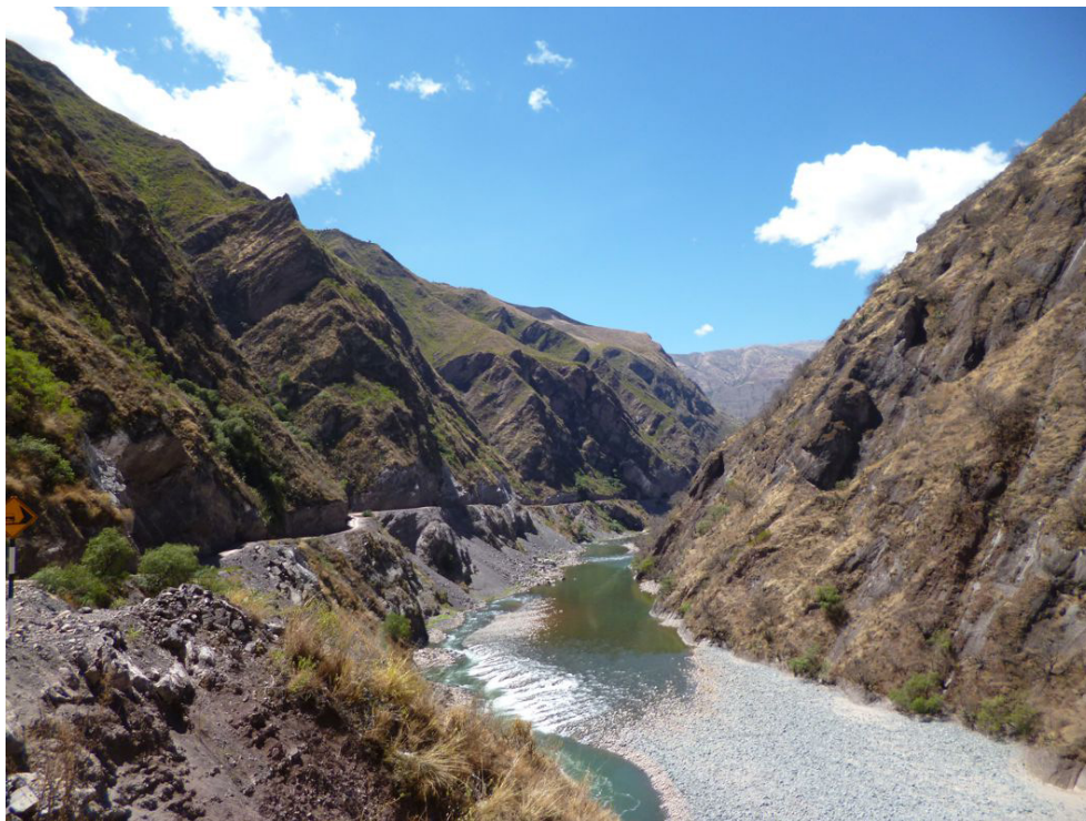
Fotografía 8.96 Carretera Cusibamba Bajo-Huaro Bamba trazada en la margen izquierda del valle del río Apurímac, en una ladera que supera los 40° de inclinación.
