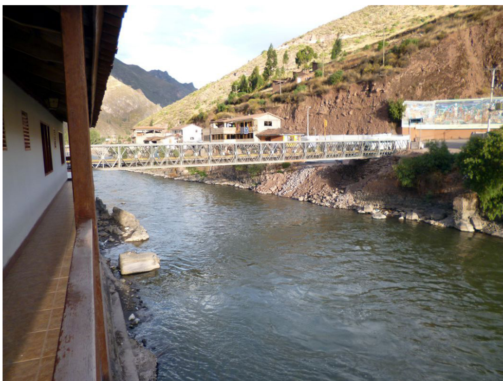
Fotografía 8.39 Puente tipo bailey colocado sobre el río Vilcanota para dar pase a la localidad de Pisac; el puente antiguo fue destruido por el caudal del río.
