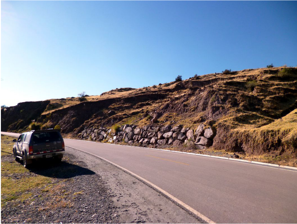
Fotografía 8.99 Carretera Acomayo-Pitumarca, zona donde se presenta asentamiento en el talud superior de la carretera por efectos de un deslizamiento activo.
