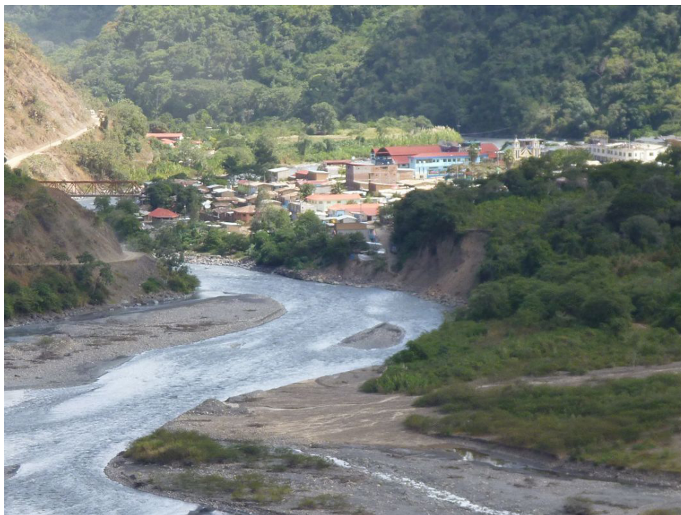
Fotografía 8.8 Erosión fluvial en la margen izquierda del río Yanatile. Puede afectar viviendas asentadas cerca de su cauce.
