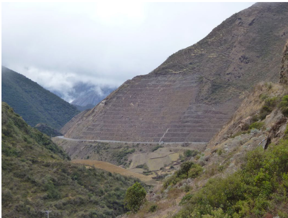
Fotografía 8.47 Derrumbe en el talud superior de la carretera en el Km. 115+950 de la carretera Interoceánica, se ha tenido que hacer banquetas en el talud para estabilizar la zona.
