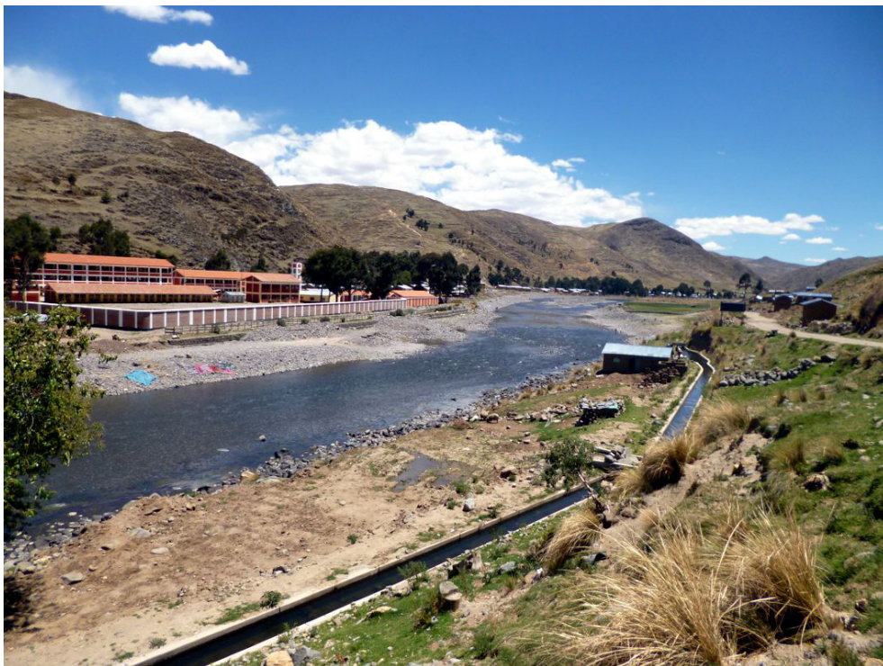
Fotografía 8.1 Río Velille produce erosión en ambas márgenes, también inundaciones con subidas del Caudal.
