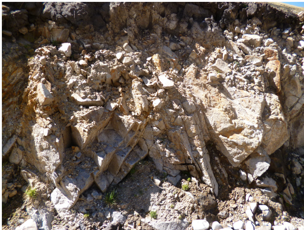
Fotografía 3.11 Tonalitas del Plutón Colquemarca, al sureste de Santo Tomás, en la ruta que la une con Velille. Es posible observar el fracturamiento que presenta la roca en el talud de corte de carretera.
