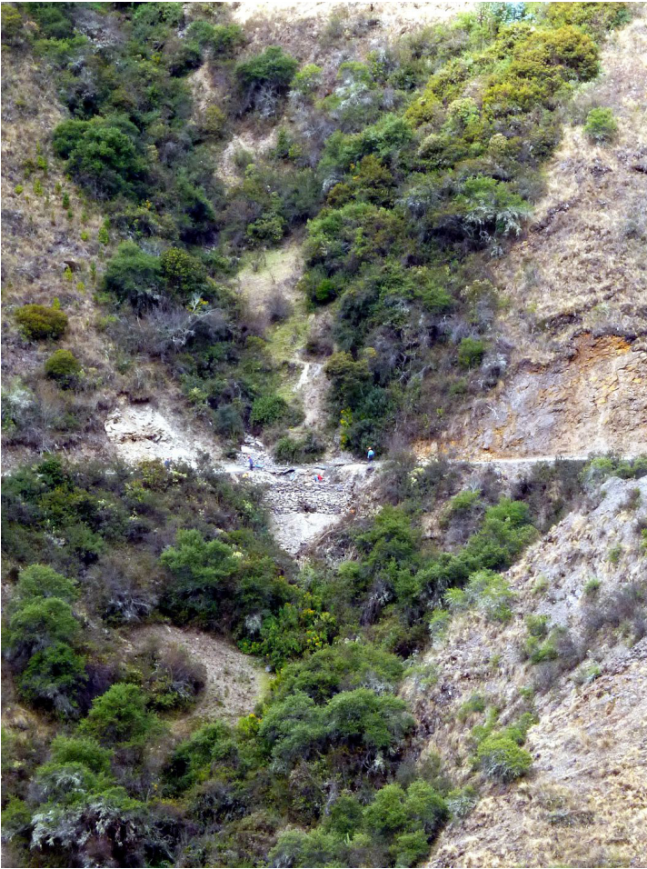
Fotografía 8.89 Carretera a Challabamba cortada por flujo de detritos que baja por la quebrada Cumurumiyoc.
