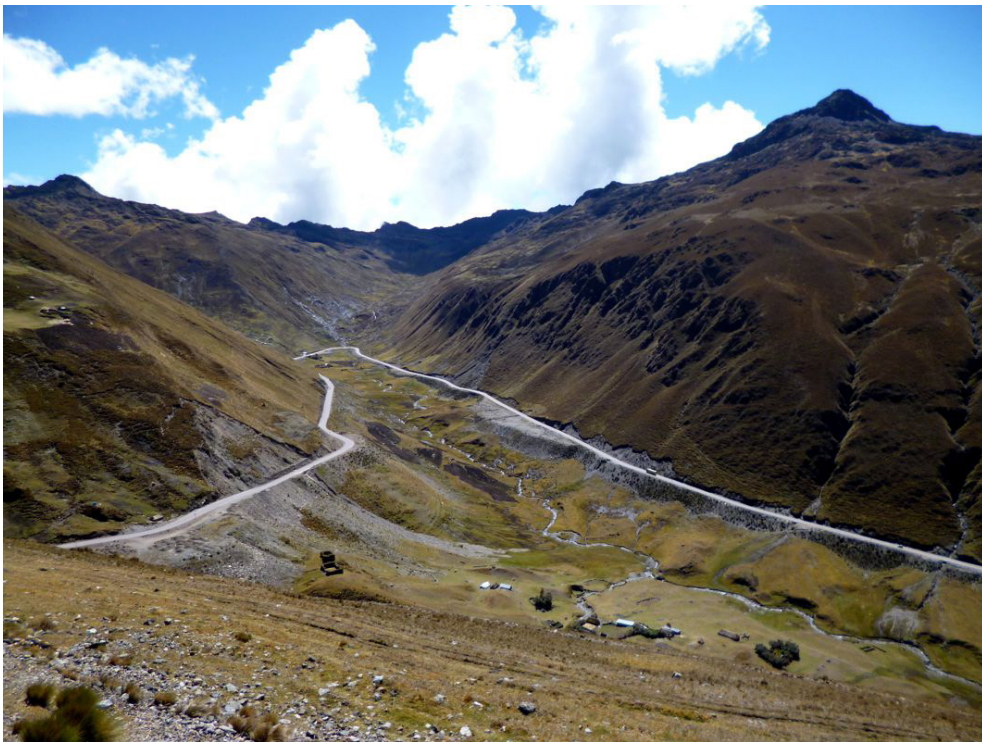
Fotografía 8.72 Derrumbes en el talud superior de carretera entre los Km. 119+500 al 121+500; vista de la quebrada Pillanicancha, tributaria de la quebrada Tanjac.
