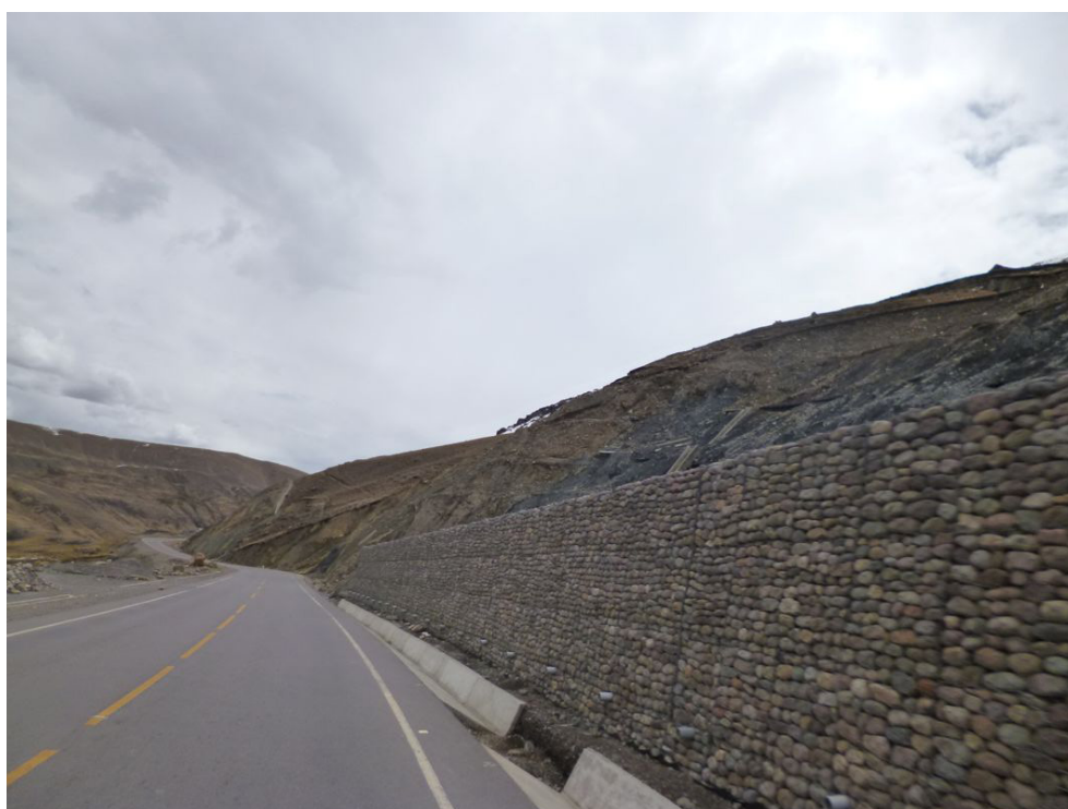
Fotografía 8.50 Talud superior de carretera sostenido con muro de gaviones en el cerro Pucaloma; el substrato comprometido es de pizarras y lutitas.
