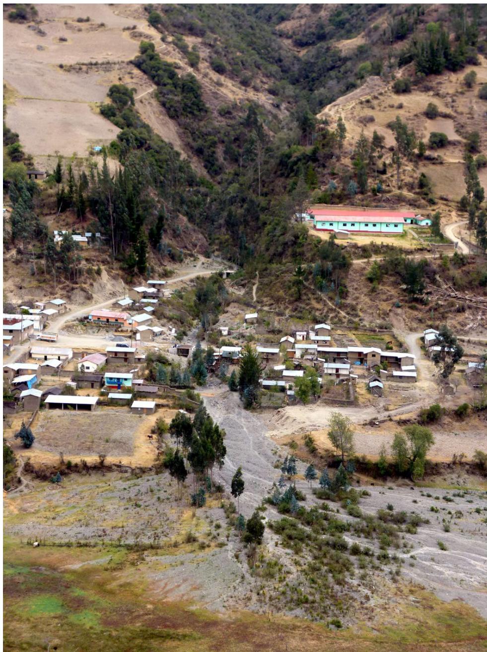
Fotografía 8.86 Flujo de detritos que baja por la quebrada Meclaypata en la margen izquierda del río Paucartambo, puede afectar viviendas del poblado de Meclaypata.
