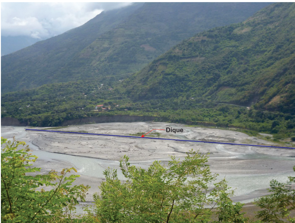
Fotografía 8.22 Sector de Mandor, afectado por erosión fluvial.
