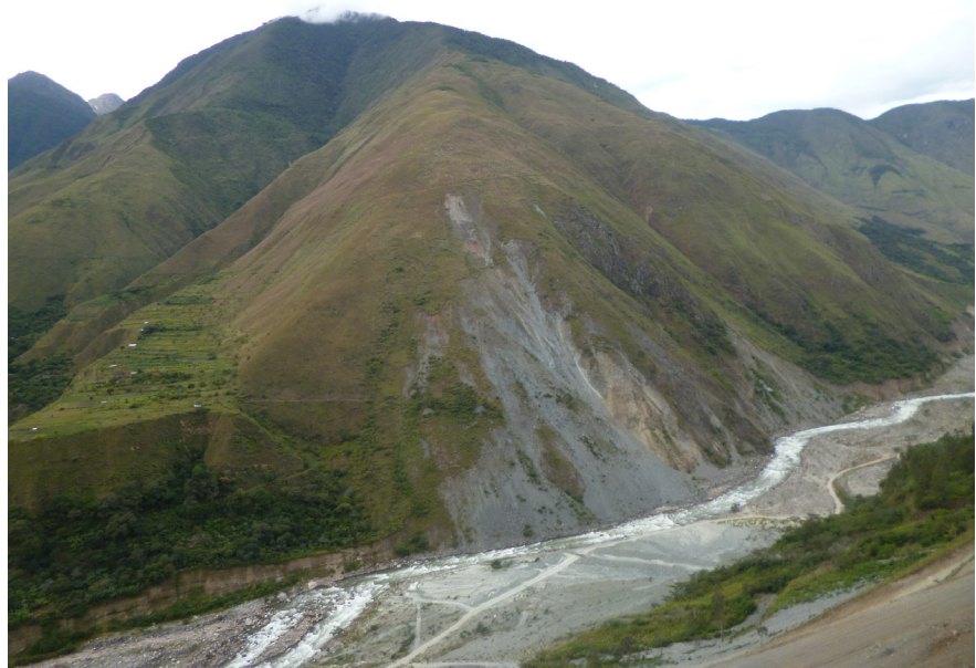
Fotografía 3.6 Derrumbe por erosión en la base de la ladera de la margen derecha del río Vilcanota. Forma un depósito coluvial en el sector de Huillcar, distrito Machu Picchu, provincia Urubamba.
