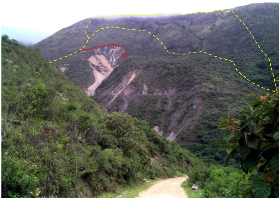
Figura 8.14 Vista del deslizamiento de Toccopuquio en la margen izquierda de la quebrada Yanamayo, actualmente viene siendo monitoreado.
