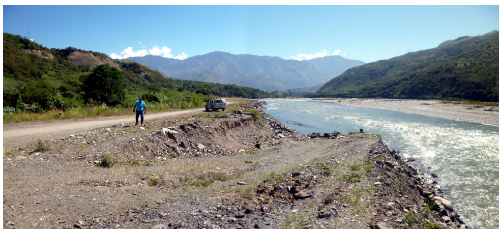
Fotografía 8.24 Sector de La Balsa, espigones rehabilitados después del último evento del periodo lluvioso 2008.
