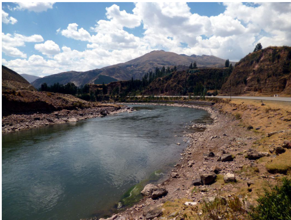
Fotografía 8.62 Erosión fluvial en el sector de Cusipata, afecta la carretera.
