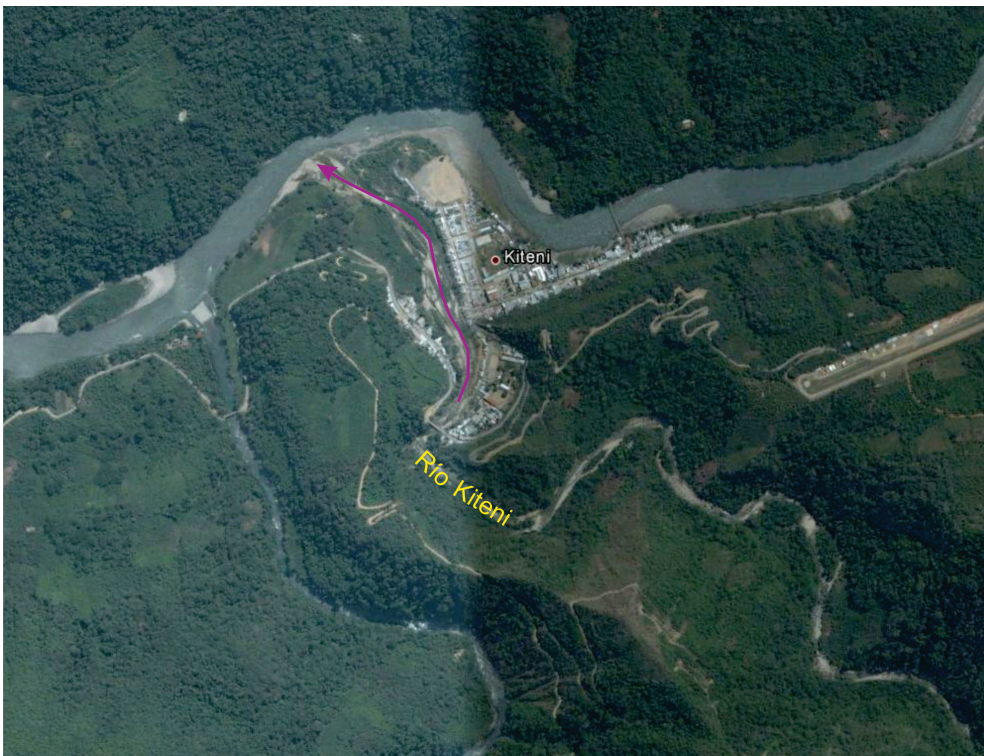
Figura 8.10 Vista del poblado de Kiteni asentado en la margen derecha del río Kiteni, afectado por un huaico el año 1998.
