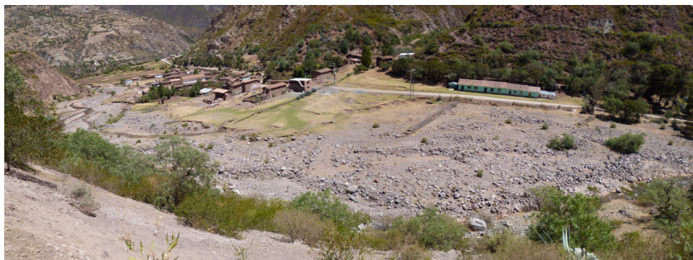
Fotografía 8.98 Valle del río Paruro y del poblado de Cusibamba bajo asentado en su margen izquierda cerca a la desembocadura en el río Apurímac, afectado por procesos de erosión fluvial y huaicos, se han colocado espigones con gaviones para evitar que el poblado sea afectado.
