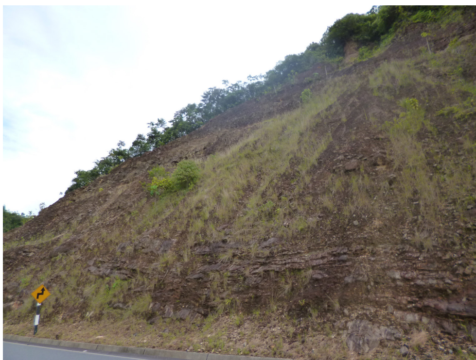
Fotografía 3.23 Areniscas cuarzosas masivas del Grupo Oriente en el talud superior de la carretera Interoceánica Km. 218, distrito de Camanti, provincia de Quispicanchi.
