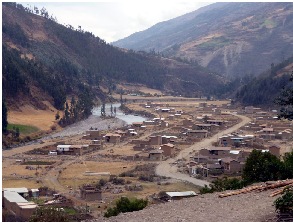
Fotografía 8.85 Población que ocupa terrenos de la hacienda Llaychu, asentada sobre una terraza baja en la margen derecha del río Paucartambo, puede ser afectada por procesos de erosión e inundación fluvial.
