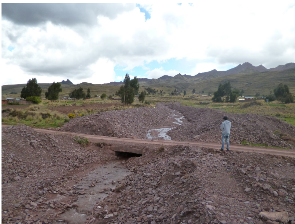
Fotografía 8.104 Flujo de detritos en el sector de Caluyo fomo albardones, carretera Langui-Layo.
