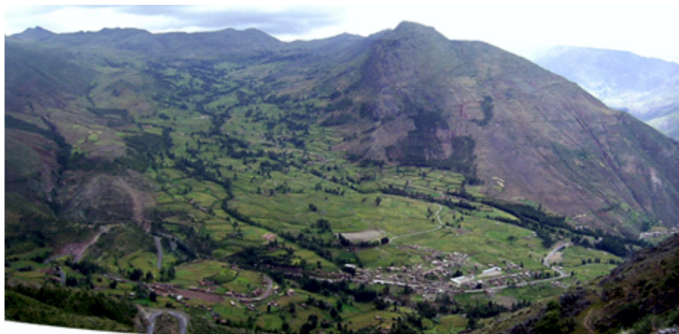
Fotografía 8.35 Deslizamiento-flujo de tierra de Cuyo Chico.
