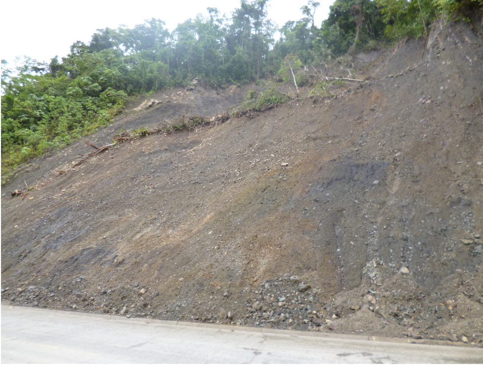
Fotografía 3.16 Interestratificación de lodolitas, limolitas y calizas de la Formación Chonta. También se puede apreciar el grado de fracturamiento y alteración de las rocas. Talud superior de corte de la carretera Interoceánica, sector de Otorongo Chico distrito Camanti, provincia Quispicanchi.
