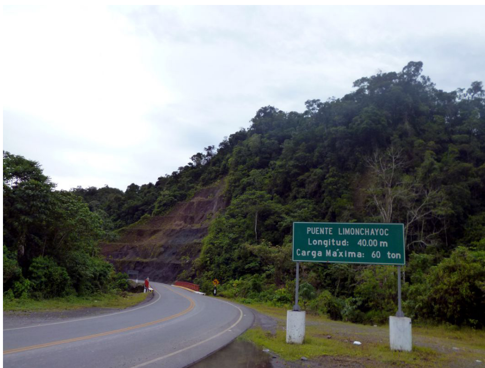
Fotografía 8.46 Derrumbes en talud superior de la carretera, sector del puente Limonchayoc. Se han construido banquetas en el talud para estabilizarlo.
