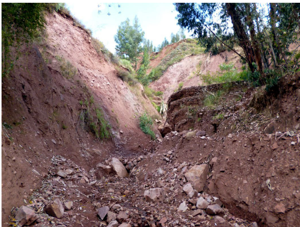
Fotografía 8.33 Sector de Coya, ladera del cerro Bandera cortada por quebrada con derrumbes activos en su cabecera, materiales sueltos son acarreados en forma de huaicos. Se pueden observar los muros de gaviones destruidos.
