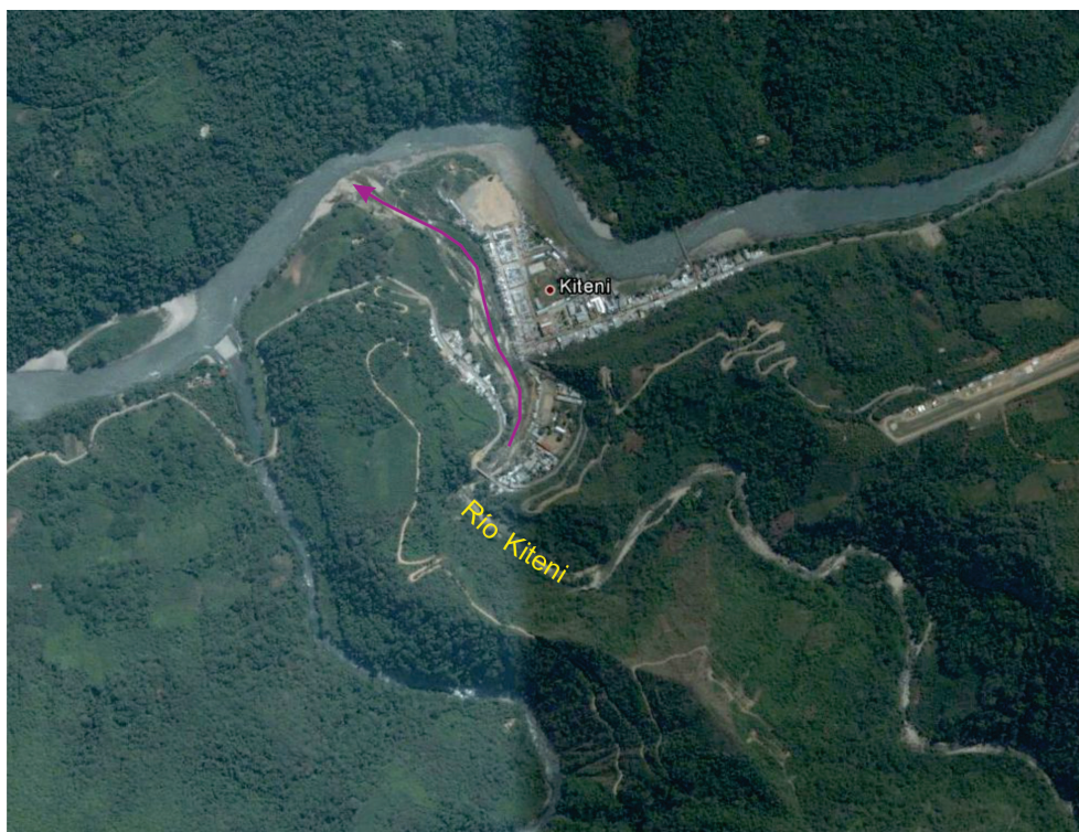
Figura 8.8 Vista del río Urubamba donde se encuentra la C.H de Machupicchu; también se puede observar el cauce del río Aobamba, por donde discurrió un aluvión que represso el río Urubamba y provocó daños en la central hidroeléctrica.
