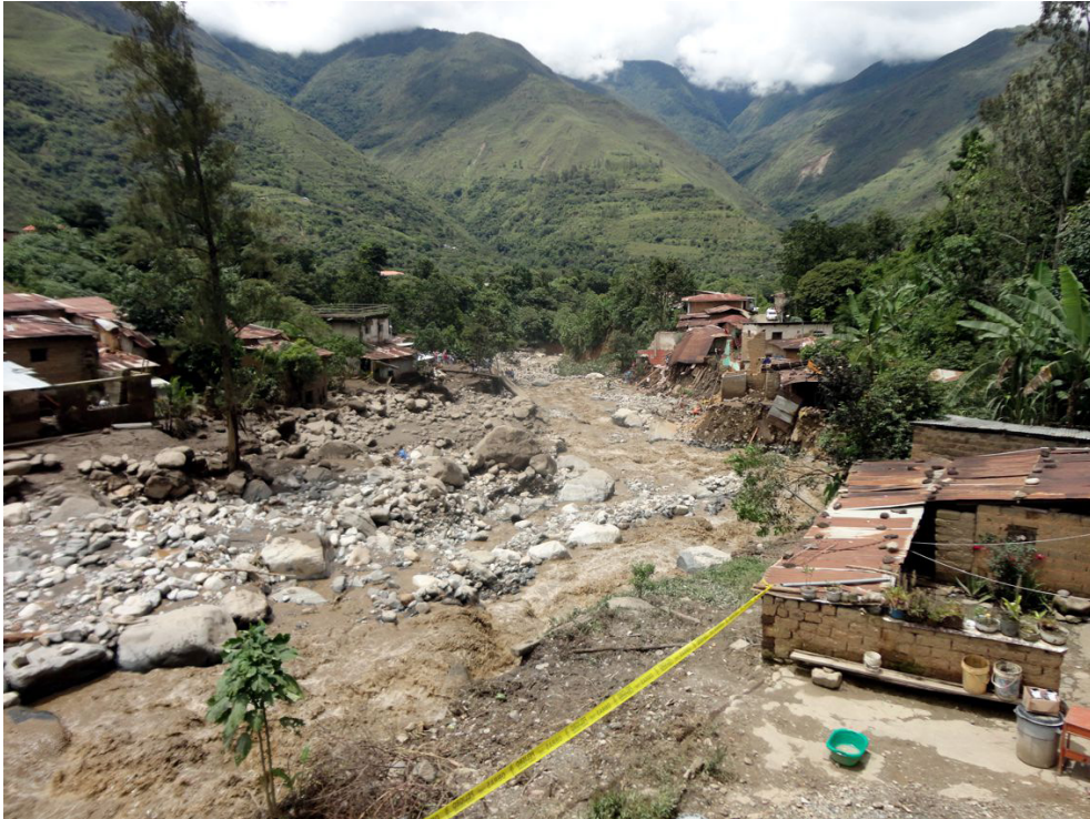
Fotografía 8.9 Destrucción de viviendas asentadas cerca del cauce de la quebrada Calquiña en Huyro.
