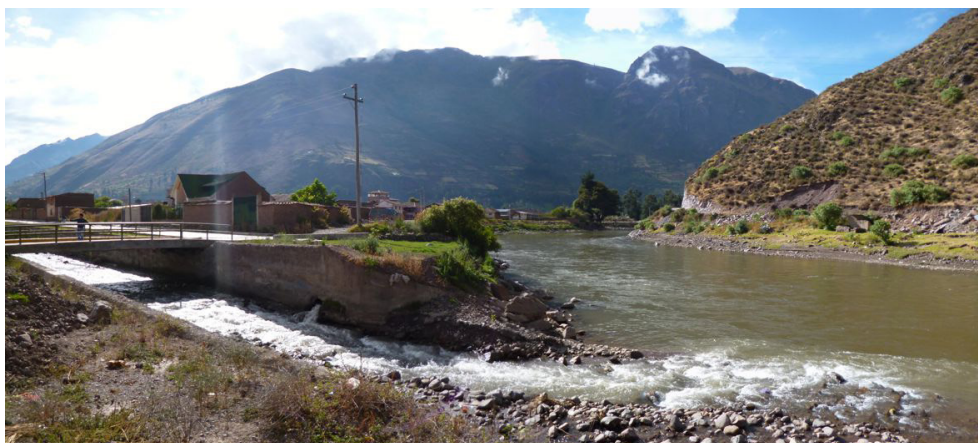
Fotografía 8.32 Confluencia del río Ccochoc en el río Vilcanota. Se observa la ausencia de protección en la margen derecha del río Vilcanota.
