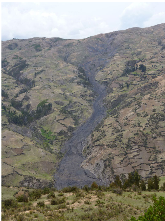
Fotografía 8.93 Deslizamiento rotacional antiguo reactivado en el cerro Jachi, produce asentamientos en la plataforma de la carretera.
