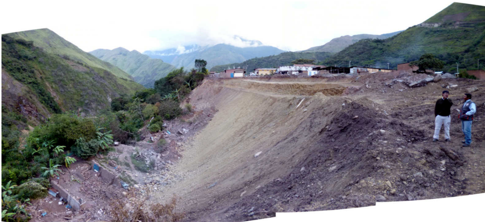
Fotografía 8.15 Superficie de ruptura cóncava del deslizamiento de Ocobamba, que produjo la destrucción de 30 viviendas en el poblado de Ocobamba.
