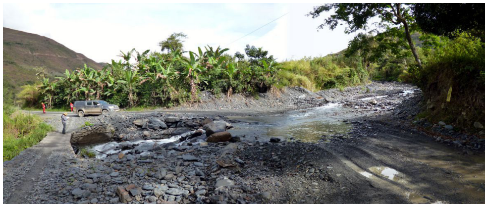
Fotografía 8.26 Flujo de detritos de la quebrada Altarmayo corta la carretera.
