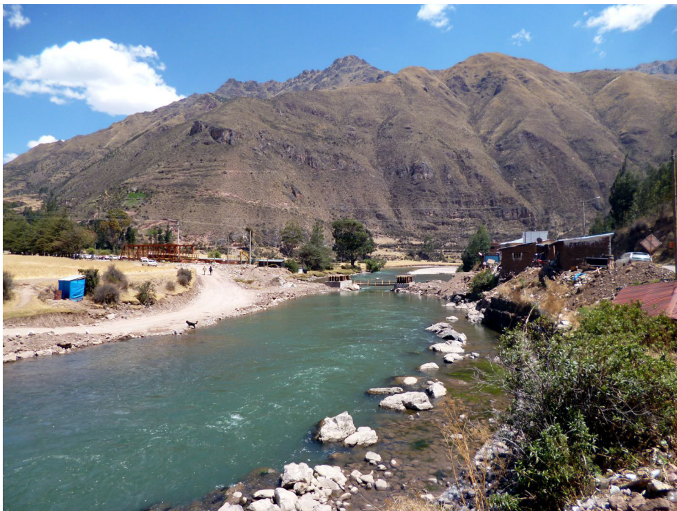
Fotografía 8.4 Sector de Chuquichuana, puente sobre el río Vilcanota, que permite el paso de vehículos hacia Acomayo, destruido por efectos de la erosión fluvial.
