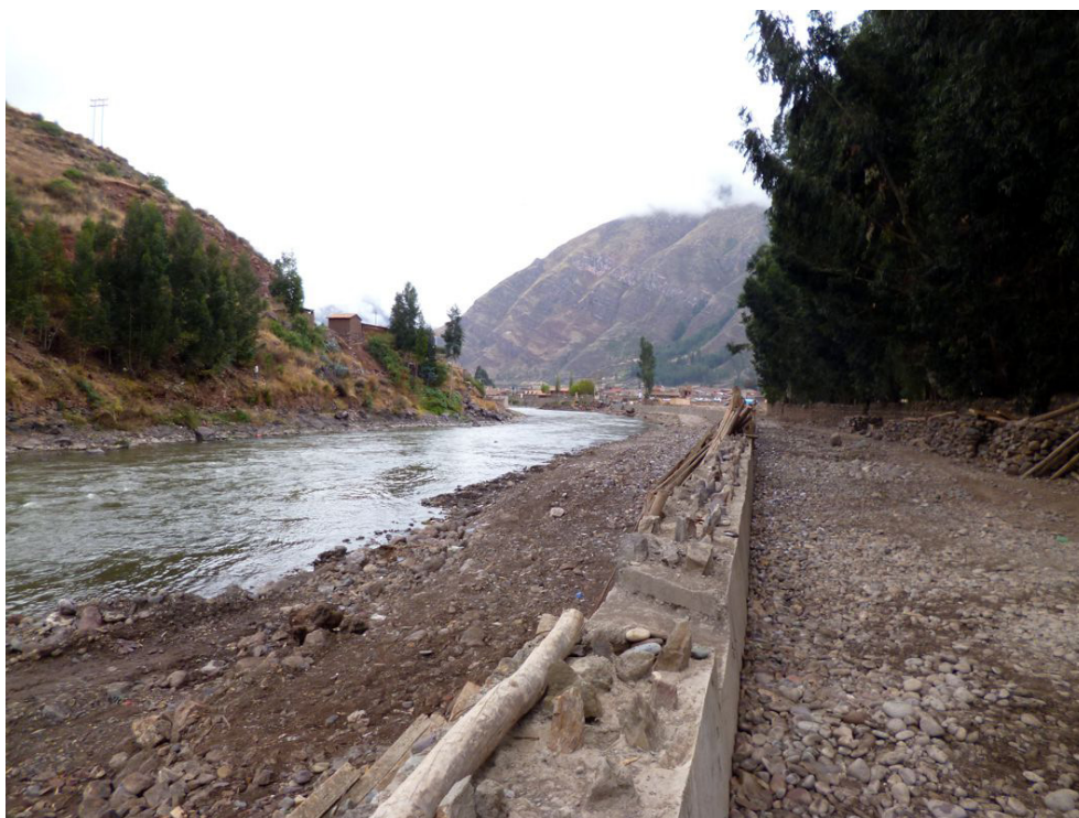
Fotografía 8.38 Trabajos de encauzamiento del río Vilcanota con muros de concreto aguas abajo del poblado de Pisac.
