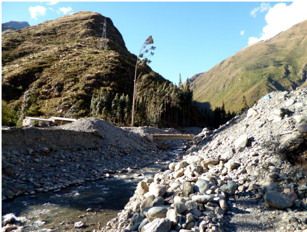
Fotografía 8.76 Quebrada Tanjac, material que acarreó el huaico del 9 de febrero del 2013, sobrepasó la capacidad de carga del cauce, produciendo reboses que formaron albardones, vivienda del Phiri y Tanjac fueron destruidas con este huaico.
