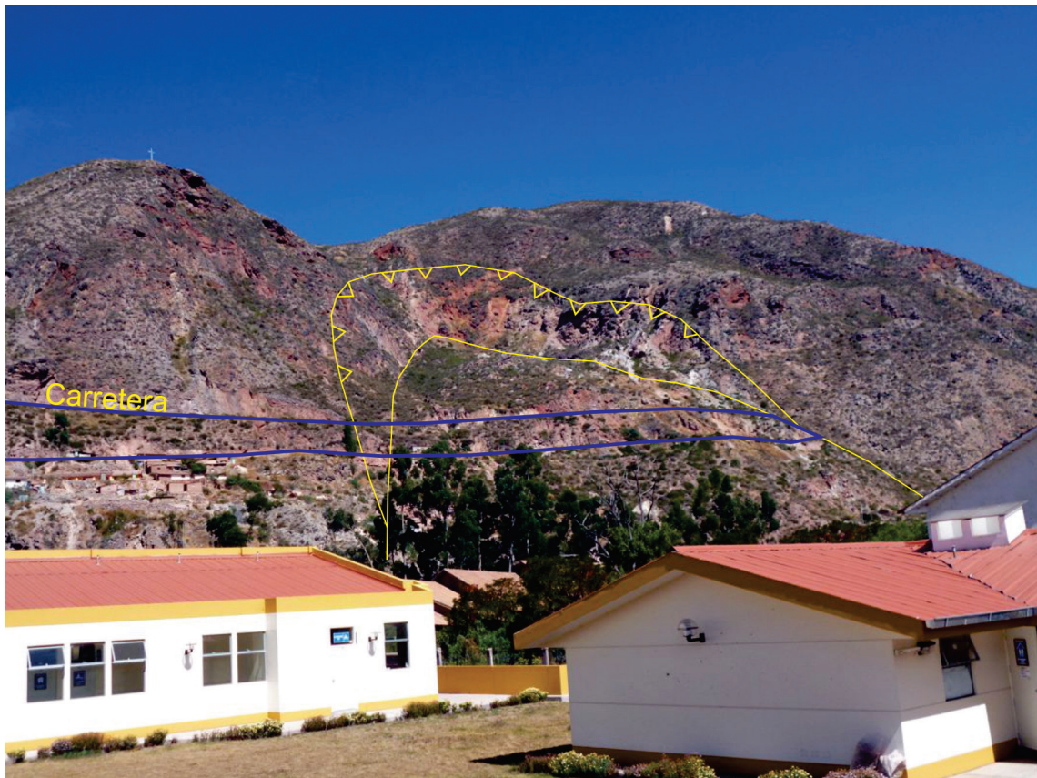
Figura 8.24 Deslizamiento que produce el asentamiento de la carretera que permite el acceso a Urubamba.
