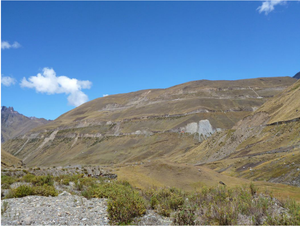
Fotografía 8.71 Desarrollo hacia el Abra Málaga, presenta problemas de derrumbes y deslizamientos en sus taludes superiores por obras de ampliación de la plataforma.
