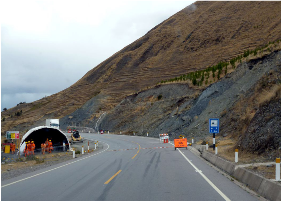
Fotografía 8.51 Trabajos de estabilización en zona de derrumbes de la carretera Interoceánica, sector de Cerro Morallaqui.
