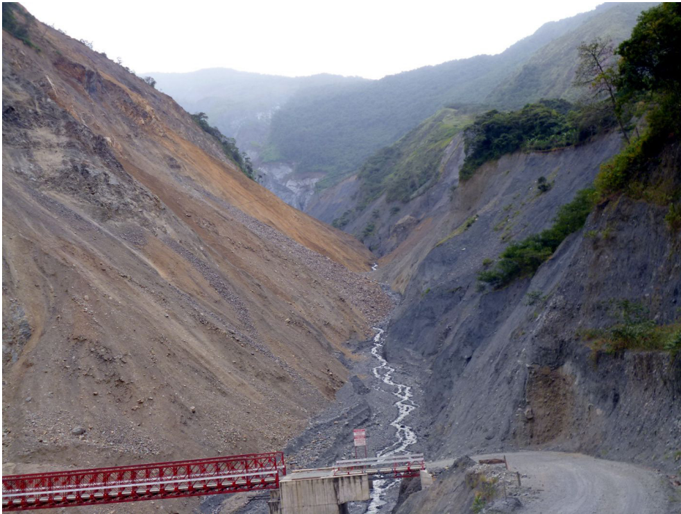
Fotografía 8.12 Flujo de detritos en la quebrada de Puentemayo, sector de Mesacancha
