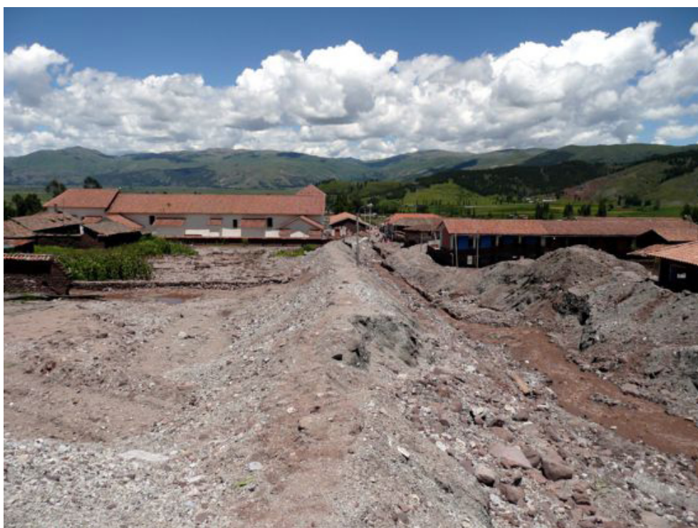
Fotografía 8.70 Cauce colmatado de la quebrada Qenqo, el material transportado superó la capacidad de carga del canal produciéndose desbordes y la formación de albardones. El flujo de detritos afectó viviendas y calles de Zurite.
