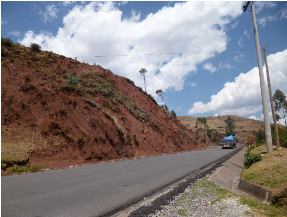
Fotografía 3.21 Estratos de limoareniscas, limoarcillitas y areniscas de la Formación Auzangate, en el talud superior de la carretera Limatambo-Cusco, sector de Chinllawuacho, distrito Limatambo.
