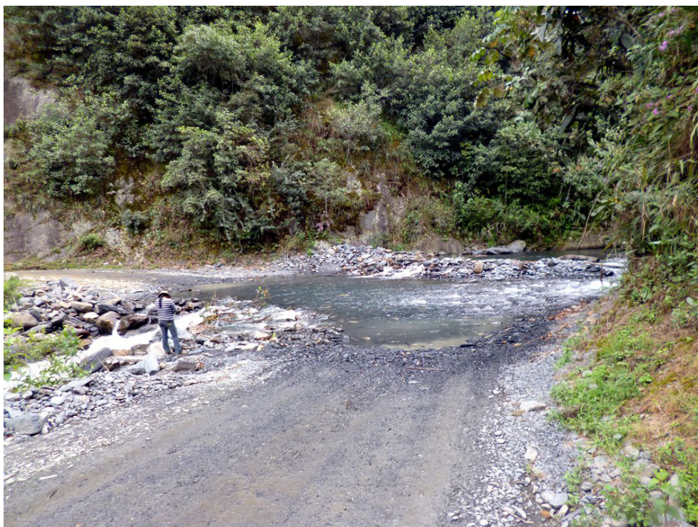
Fotografía 8.28 Quebrada Huachibamba corta el tránsito hacia Lares. Es necesario construir un badén.
