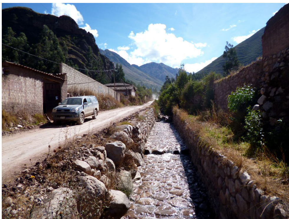
Fotografía 8.83 Tramo encausado de la quebrada Chicón en la localidad de Urubamba.
