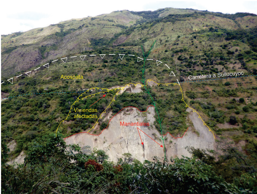
Figura 8.12 Vista del deslizamiento de Acospata.
